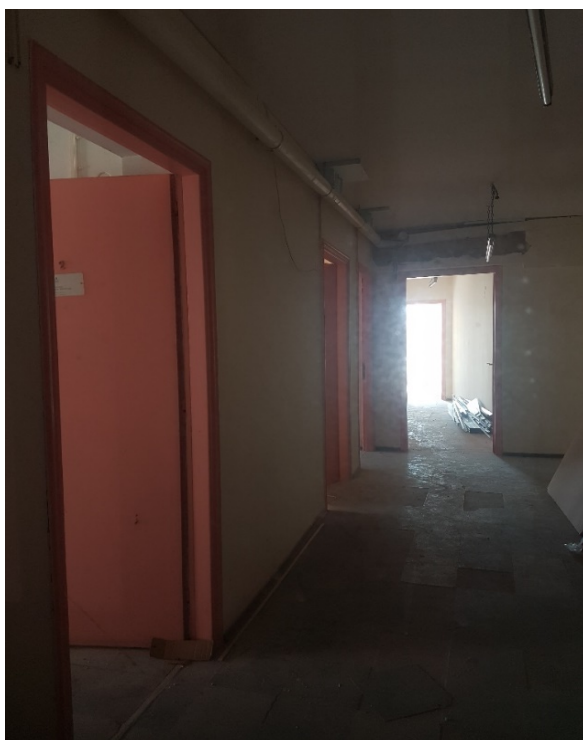
Εικόνα 4.19: Εσωτερικός χώρος γραφείων 3ου ορόφου
