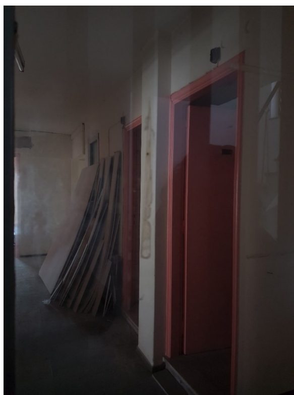
Εικόνα 4.20: WC Γραφείων 3ου ορόφου
