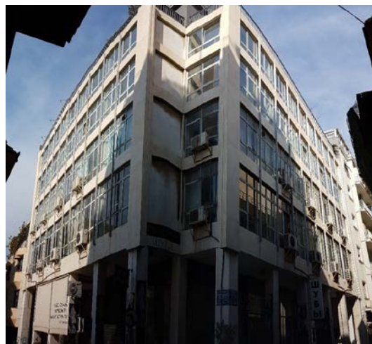
Εικόνα 4.3: Εξωτερικές Όψεις κτιρίου μελέτης
