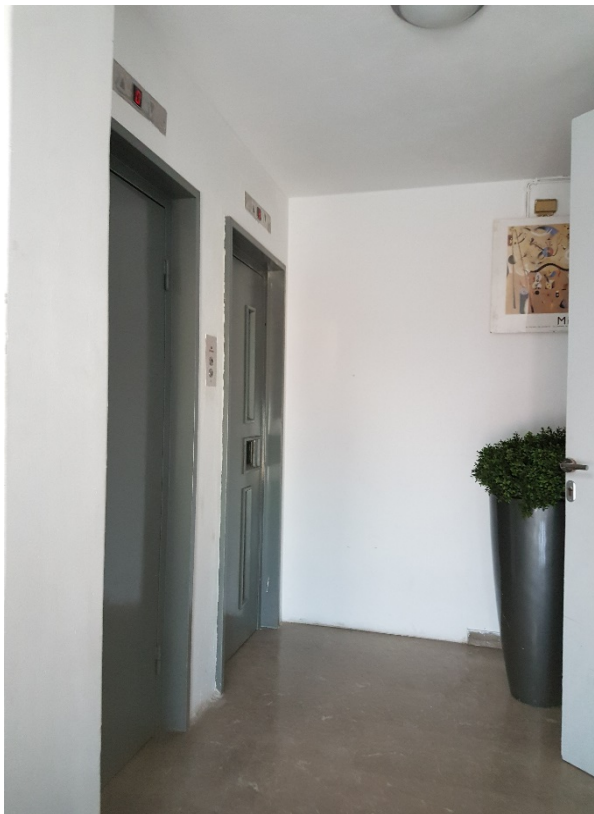
Εικόνα 4.22: Ανεγκυστήρες 5ου ορόφου
