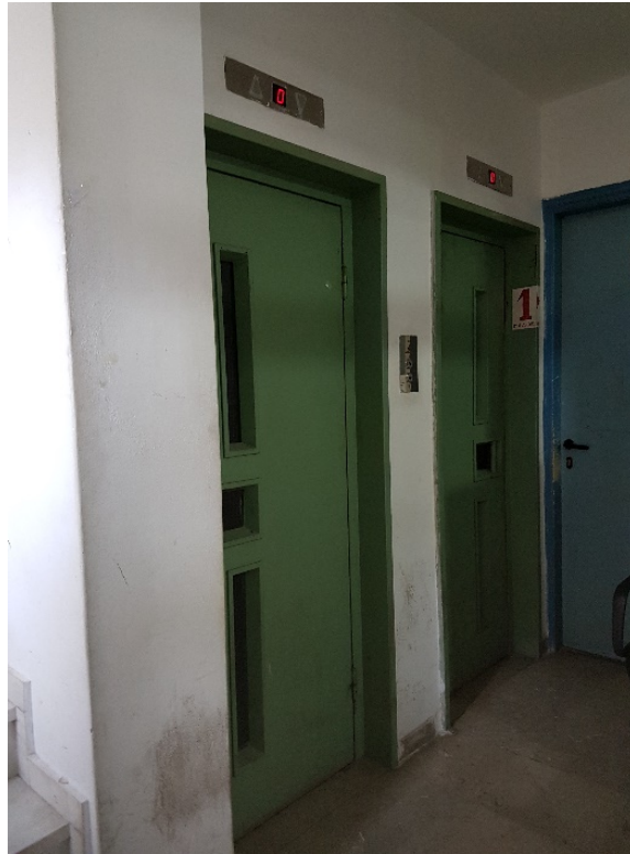
Εικόνα 4.14: Ανεγκυστήρας 1ου ορόφου
