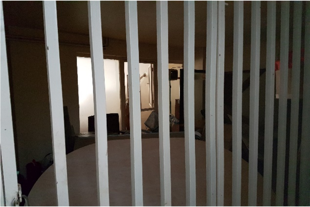
Εικόνα 4.10: Κυλικείο 1ου ορόφου (Εκτός Λειτουργίας)
