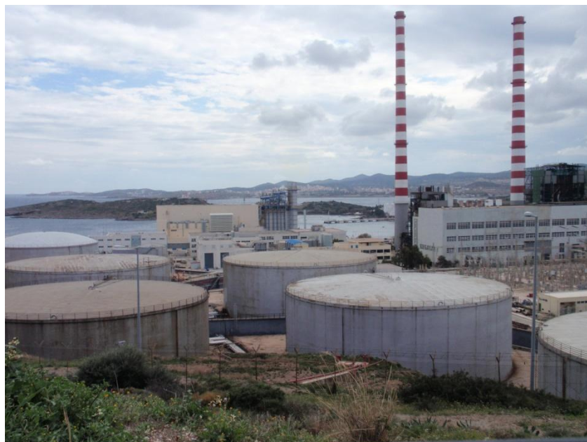
Σχ. 5.6 Καπνοδόχοι Μονάδας I (αριστερά) & II (δεξιά) ΔΕΘ/ΑΗΣ Κερατέας - Λαυρίου
