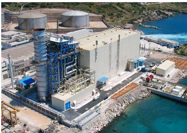
Σχ. 5.5 Εγκαταστάσεις Μονάδας V στον ΔΕΘ/ΑΗΣ Κερατέας - Λαυρίου [www.metka.gr]
