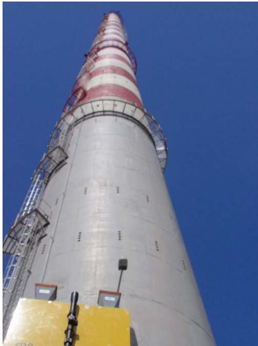
Σχ. 5.9 Σκόπευση καπνοδόχου Μονάδας I από οριζόντια απόσταση 10 m
