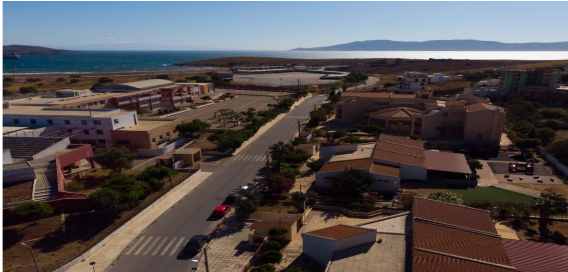
Εικόνα 4.49: Υφιστάμενη Κατάσταση οδού Παναγιώτη Κοκορέ
