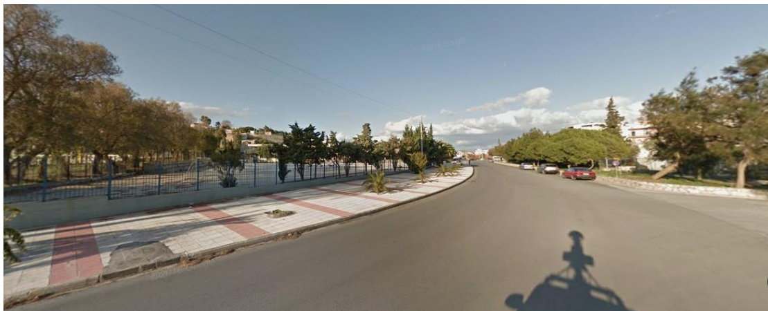
Εικόνα 4.4: Υφιστάμενη κατάσταση οδού Ανδρέα Κορδέλλα (Πηγή: Google Maps)
