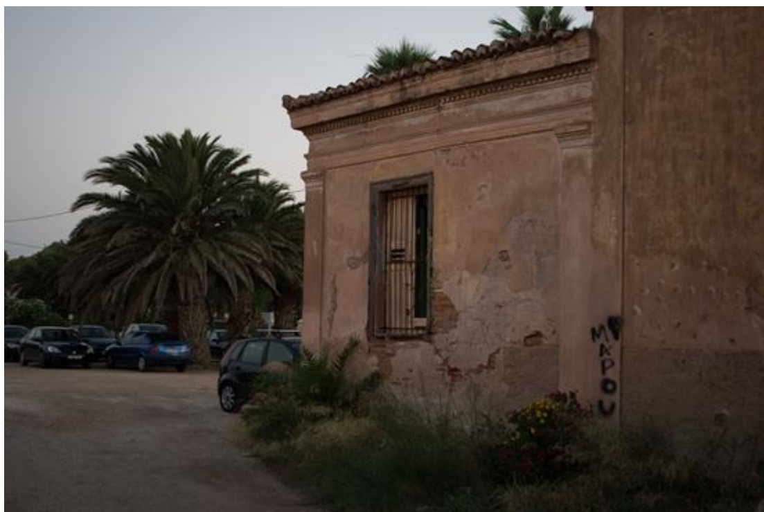
Εικόνα 4.18: Υφιστάμενη Κατάσταση Κτιρίου Ευτέρπης
