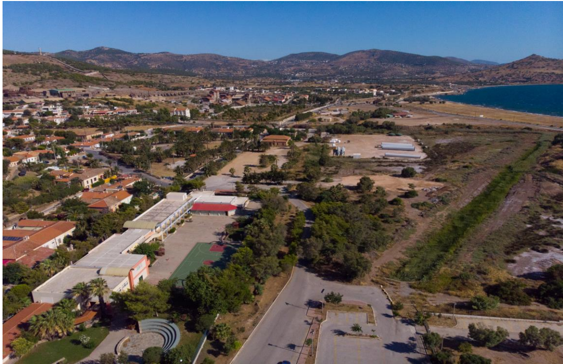
Εικόνα 4.93: Υφιστάμενη Κατάσταση Περιοχής Τέλματα, άποψη από το νοτιοδυτικό άκρο της
