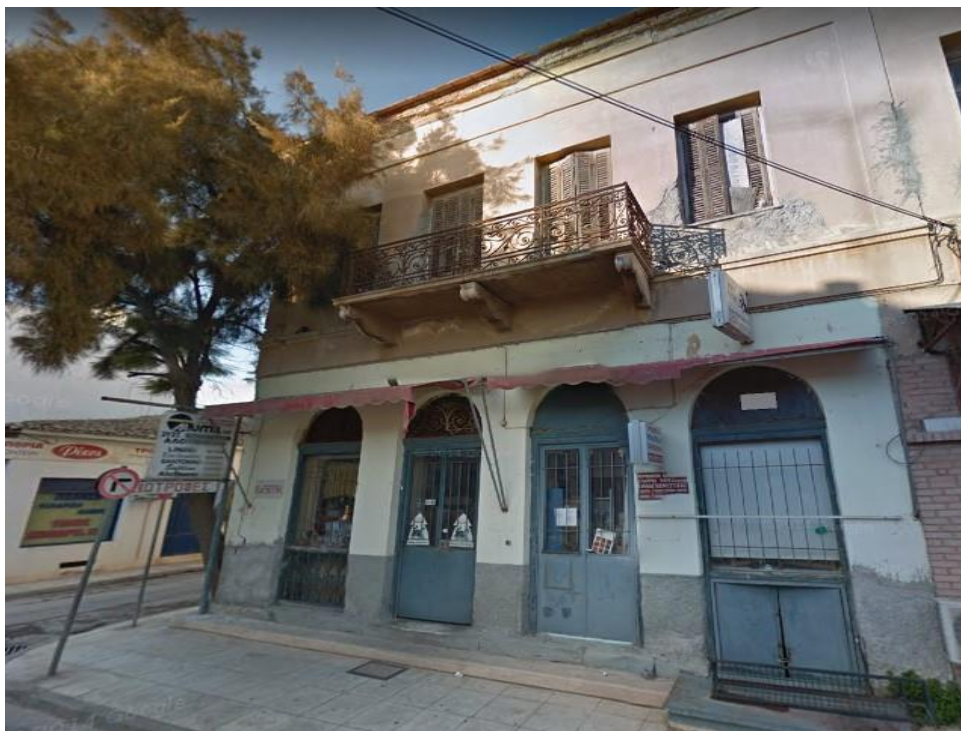
Εικόνα 4.20: Υφιστάμενη Κατάσταση Κτιρίου Λιδωρική (Πηγή: Google Maps)
