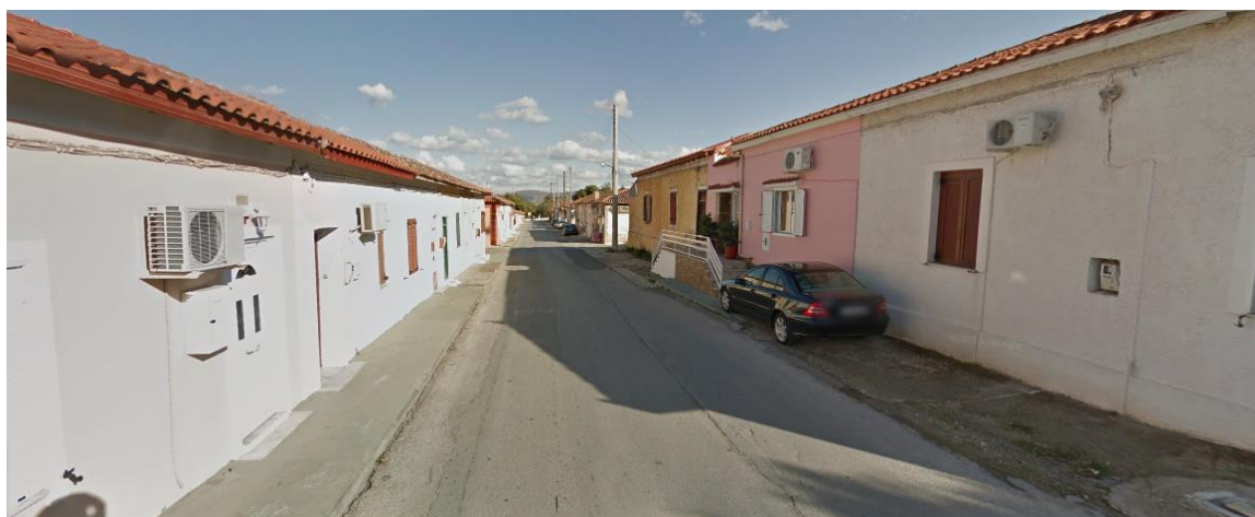
Εικόνα 4.11: Υφιστάμενη κατάσταση οδού Καμαρίζης (Πηγή: Google Maps)
