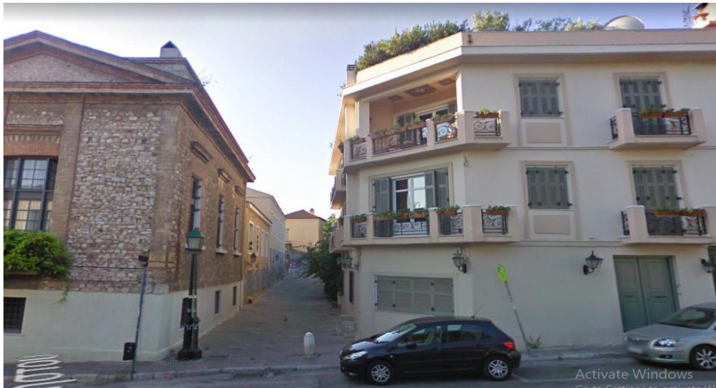
Εικόνα 4.45: Τμήμα Πλάκας, Αθήνα με Σ.Δ. 1,4 (Πηγή: Google Maps)
