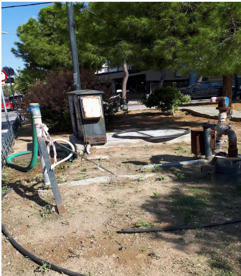
Εικόνες 5.1. - 5.5. Γεώτρηση οδού Τερψιθέας (1ΠΦ) – Π.Φάληρο
