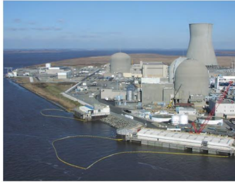
Εικόνα 3.18 Η εισροή νερού πρέπει να προστατευθεί προκειμένου το πετρέλαιο να μην επηρεάσει τις διατάξεις ανταλλαγής θερμότητας κάτι που μπορεί να οδηγήσει σε παύση της παραγωγής καθώς είναι δύσκολο να καθαριστεί ( International Tanker Owners Pollution Federation (ITOPF), 2011 )
