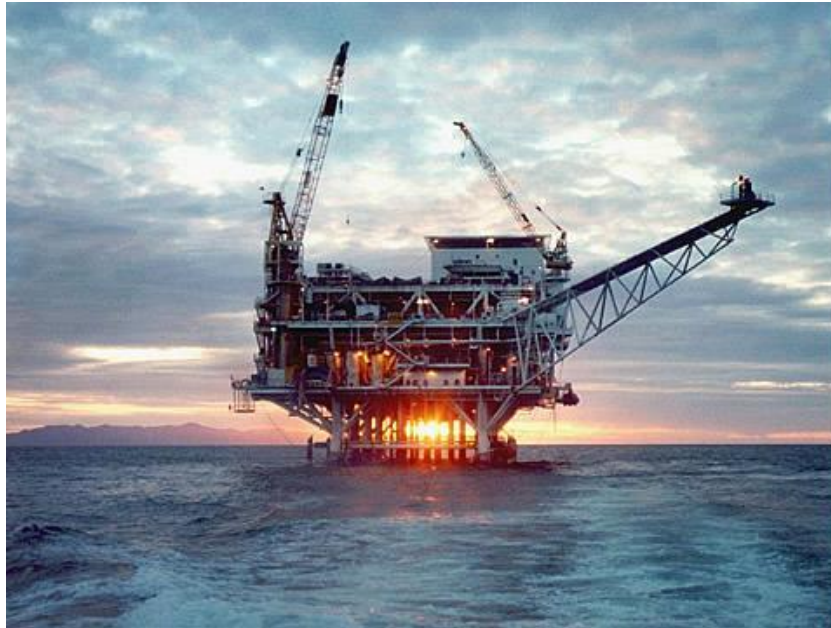
Εικόνα 2.15 Fixed platform στην Καλιφόρνια κοντά στην Σάντα Μπάρμπαρα
