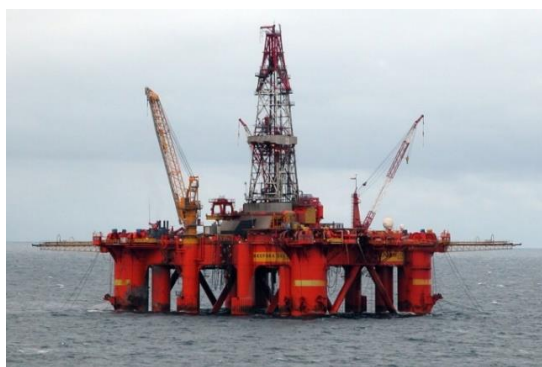
Εικόνα 2.17 Deepsea Delta ημι-βυθιζόμενη (semi-submersible) πλατφόρμα άντλησης πετρελαίου στη Βόρεια Θάλασσα (Wikipedia, Oil Platform, 2019)
