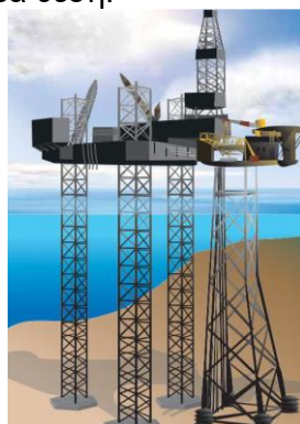
Εικόνα 2.18 Jack-up πλατφόρμα πετρελαίου (Wikipedia, Oil Platform, 2019)
