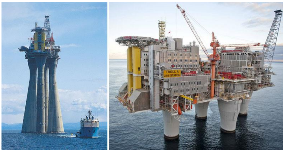
Εικόνα 2.22 Ρυμούλκηση και τελική θέση της πλατφόρμας Troll A (TwistedSifter, 2015)
