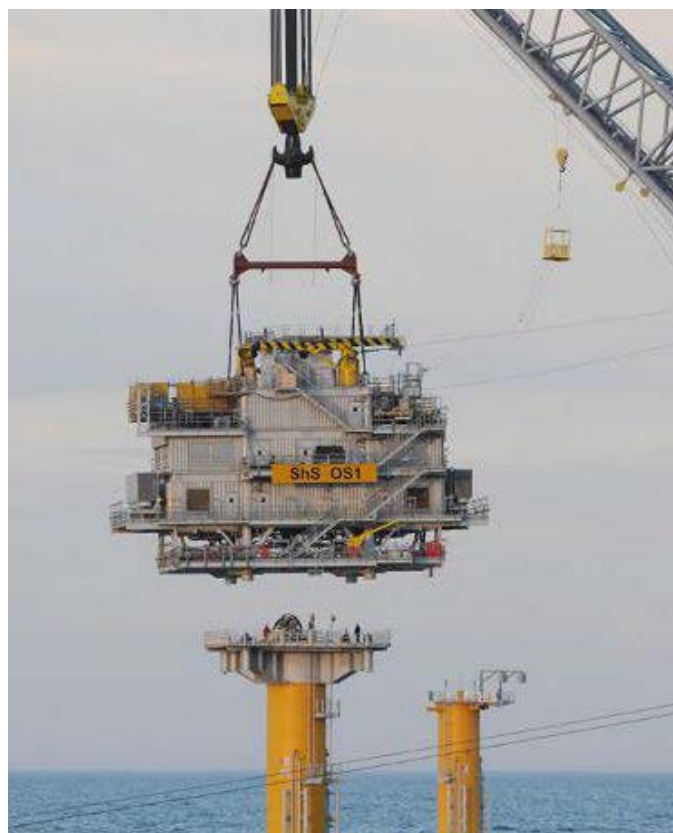
Σχήμα 5-1: Ανέγερση και τοποθέτηση κατασκευής ανωδομής (Πηγή: https://www.4coffshore.com )
