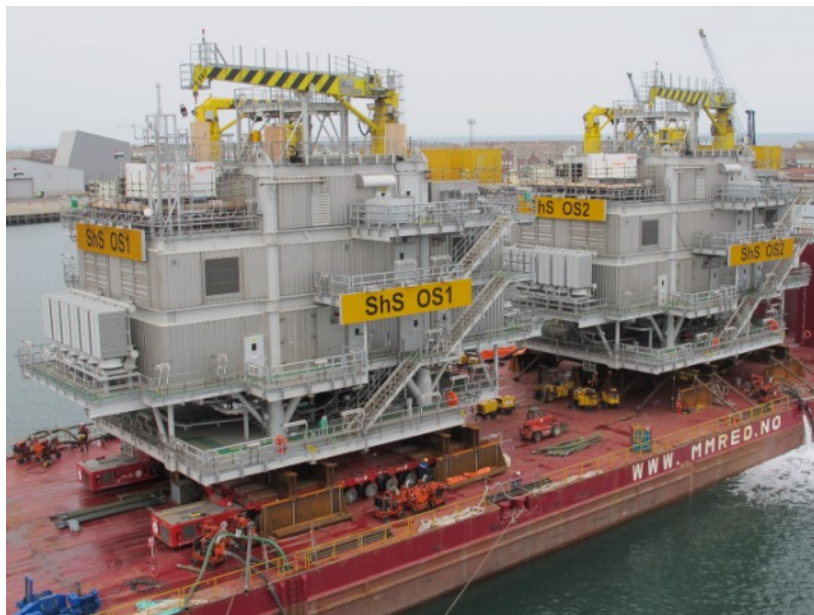
Σχήμα 1-4: Μεταφορά κατασκευής ανωδομής με φορηγίδες (Πηγή: https://hfg.heerema.com )
