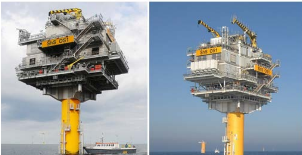
Σχήμα 2-1: Υποσταθμός “Sheringham Shoal 1” (Πηγή: α) https://www.edp24.co.uk , β) https://www.offshorewind.biz )
