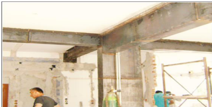
Εικόνα 104 Ενίσχυση μέλους 33 με χαλύβδινα ελάσματα
