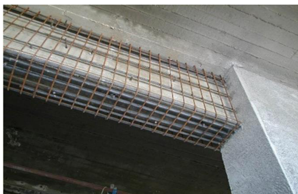
Εικόνα 101 Ενίσχυση δοκού Δ1 2 ου ορόφου
