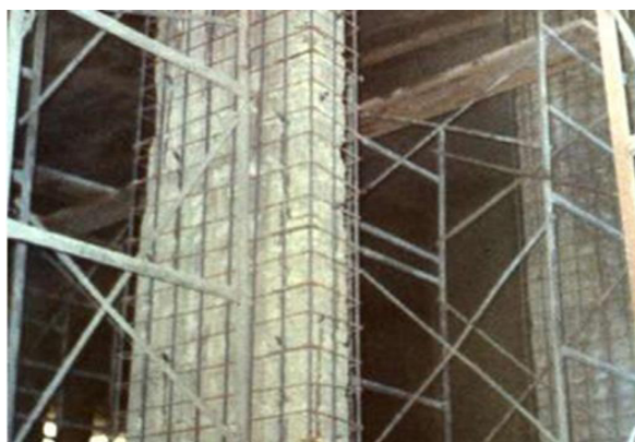
Εικόνα 105 Ενίσχυση με μανδύα σκυροδέματος μέλους 35
