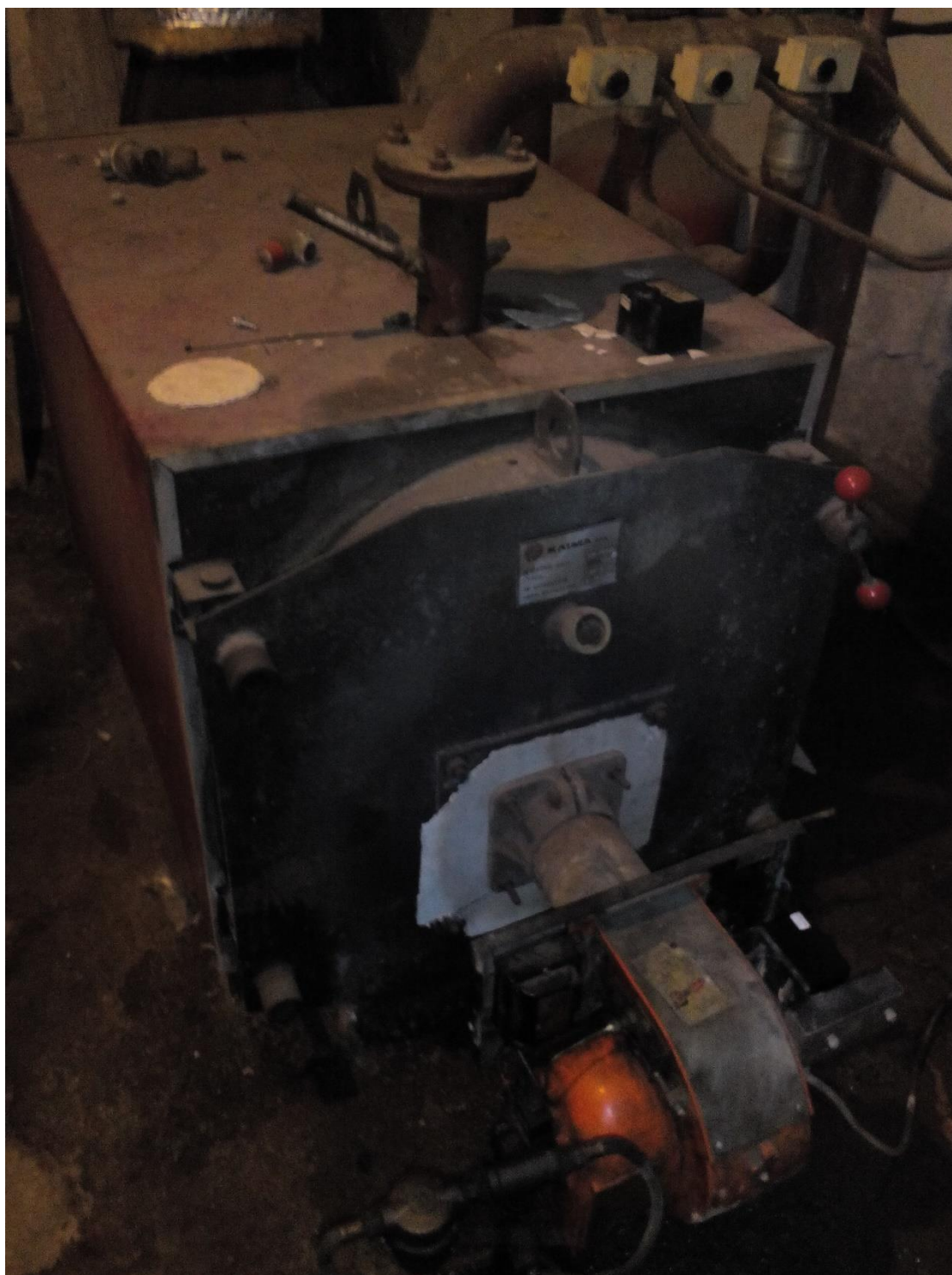
Εικόνα 11: Διάταξη λέβητα
