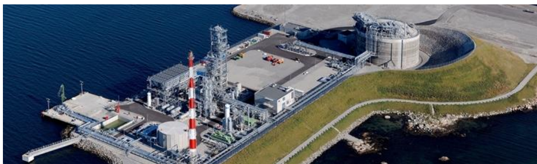
Εικόνα 14: Μικρής κλίμακας τερματικός σταθμός ΥΦΑ
