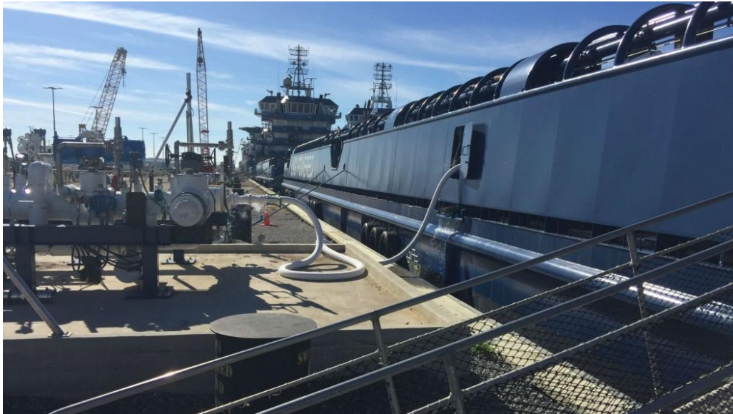
Εικόνα 18: Λιμενικός τερματικός σταθμός ανεφοδιασμού ΥΦΑ στην Βόρεια Αμερική
