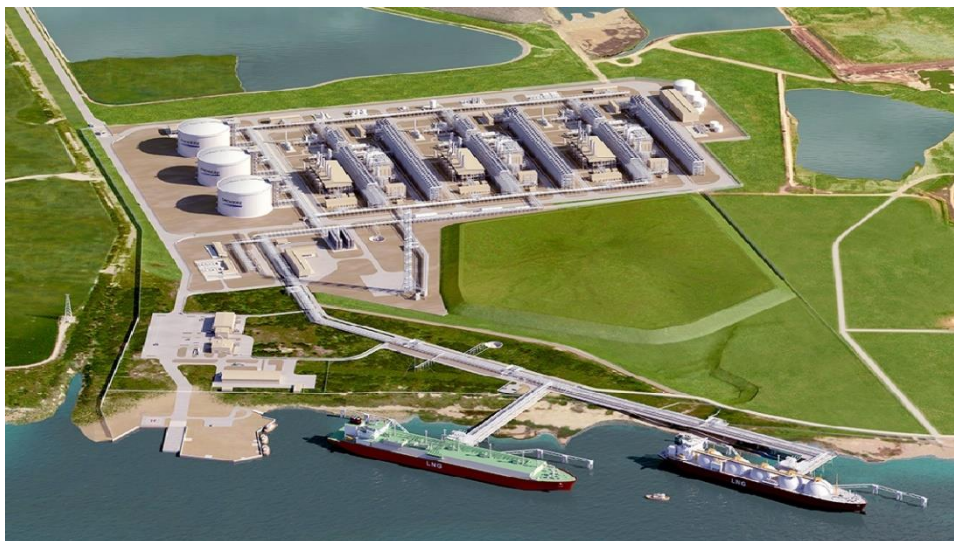
Εικόνα 19: Τερματικός σταθμός ΥΦΑ
