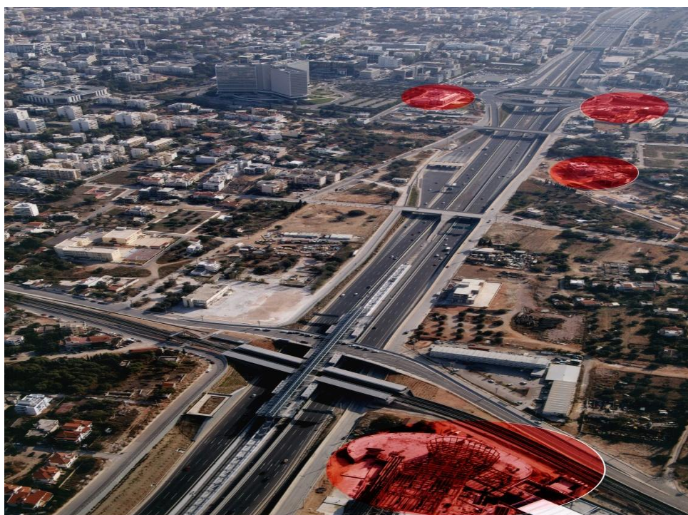
Εικόνα 7 Νέες κατασκευές, στην παράπλευρη ζώνη της Αττική Οδού και κυρίως γύρω από τους κόμβους, 2007
