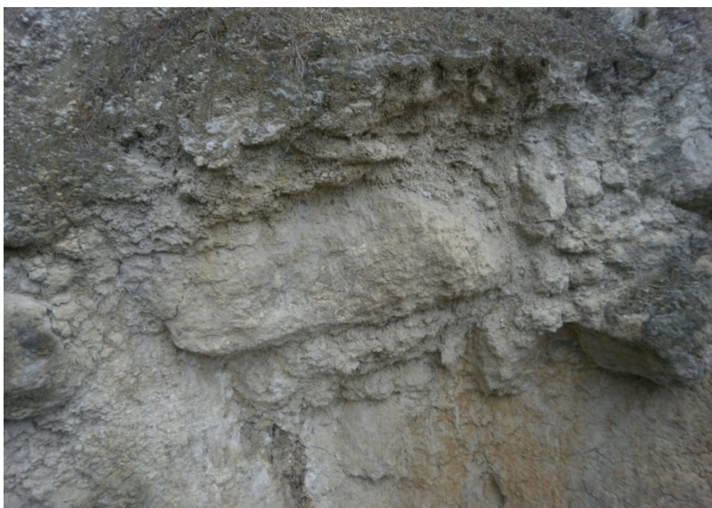
Εικόνα 5.16 Μάργες εύθρυπτες και αποσαθρωμένες τεφρόλευκου χρώματος.
