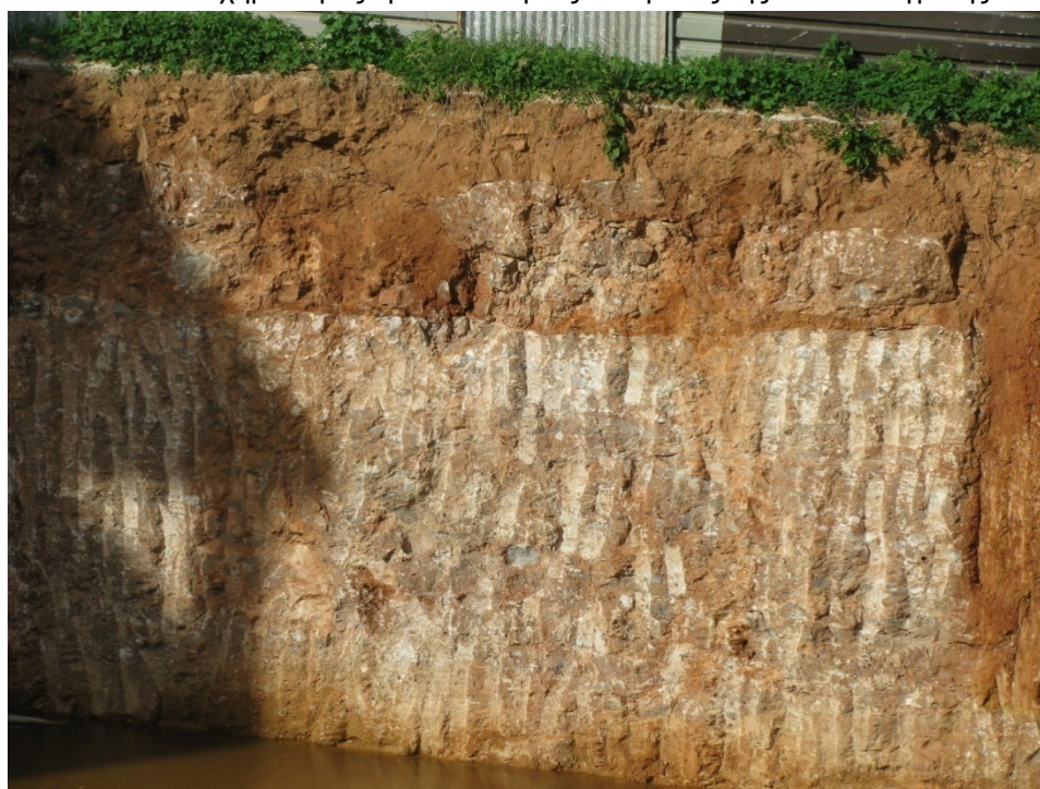
Εικόνα 5.8 Εμφάνιση κροκαλοπαγούς σε θεμελίωση οικίας στη Βούλα.
