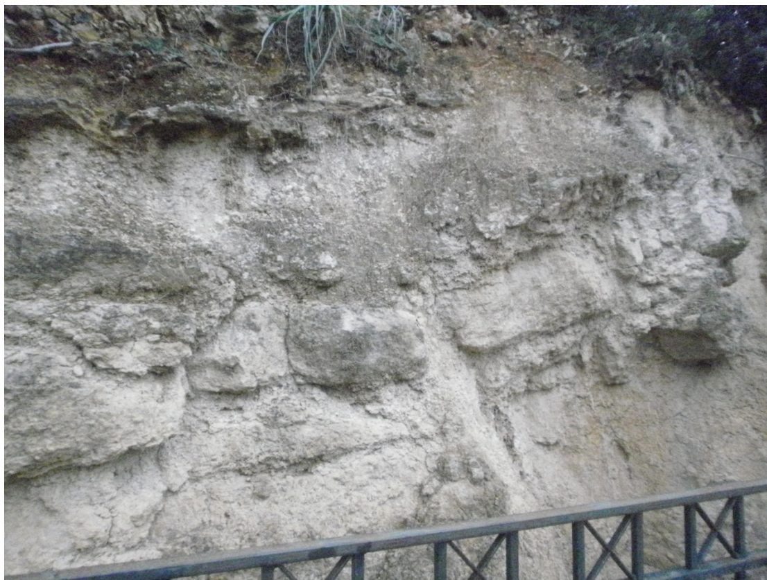
Εικόνα 5.15 Μάργες εύθρυπτες και αποσαθρωμένες τεφρόλευκου χρώματος.
