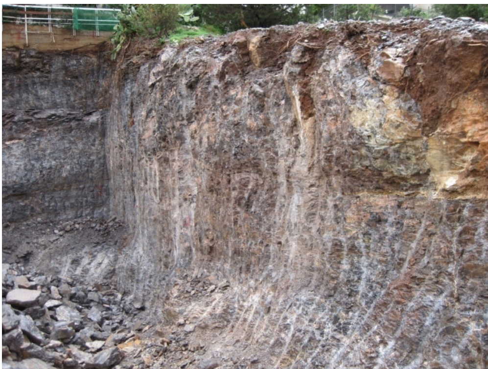
Εικόνα 5.52 Δολομίτης Πιρναρής όπως εμφανίζεται σε εκσκαφή που πραγματοποιήθηκε για τις απαιτήσεις θεμελίωσης οικίας στην οδό Πριάμου.
