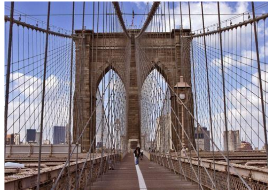
Εικόνα 1.2 - Γέφυρα του Brooklyn
