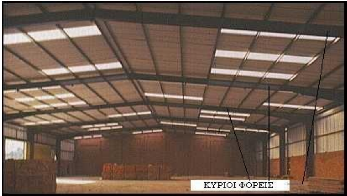
Σχήμα 2.13 : Πλαισιακοί κύριοι φορείς ενός ανοίγματος.
