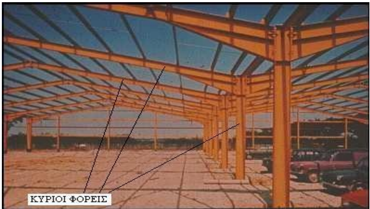
Σχήμα 2.14 : Πλαισιακοί κύριοι φορείς δύο ανοιγμάτων.
