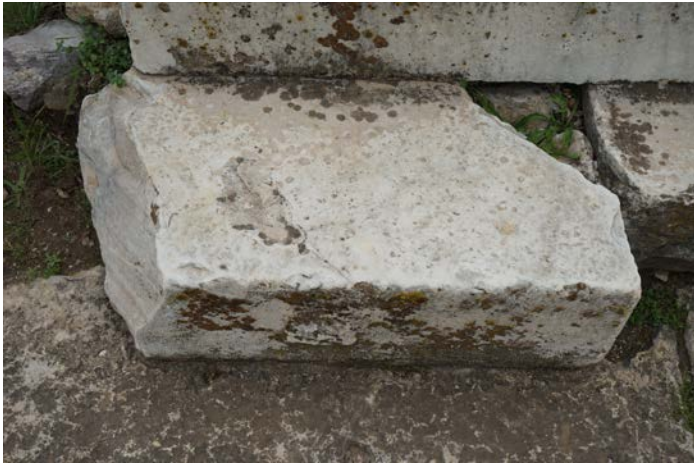
εικ. 19, 20, 21: τεμάχια αναβαθμών της πρώτης στρώσης του κρηπιδώματος
