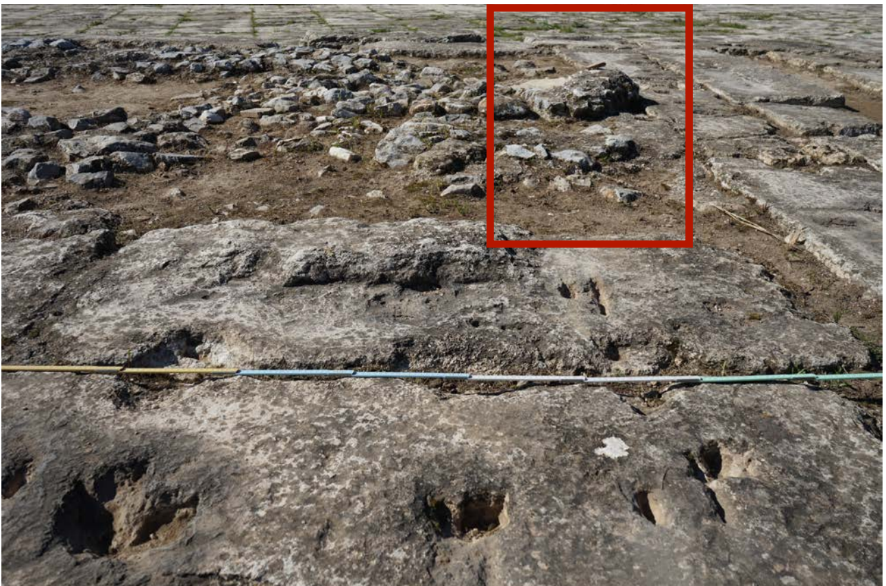
εικ. 32: εξέχον ρωμαϊκό ασβεστοκονίαμα παρά τον οπισθοδόμιο τοίχο
