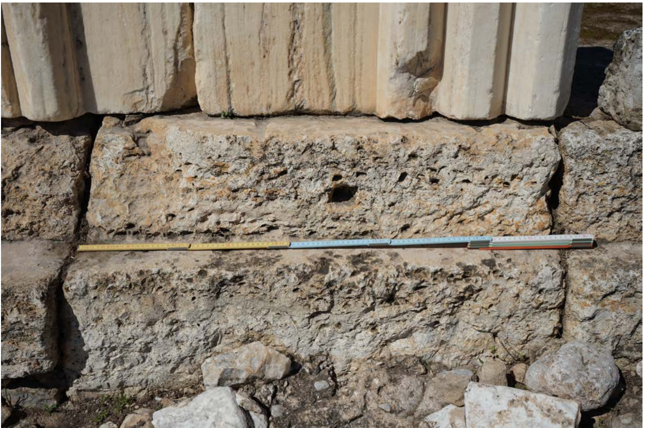
εικ. 26: οπή συνδέσμου στο πρόσωπο του λίθου του στερεοβάτη
