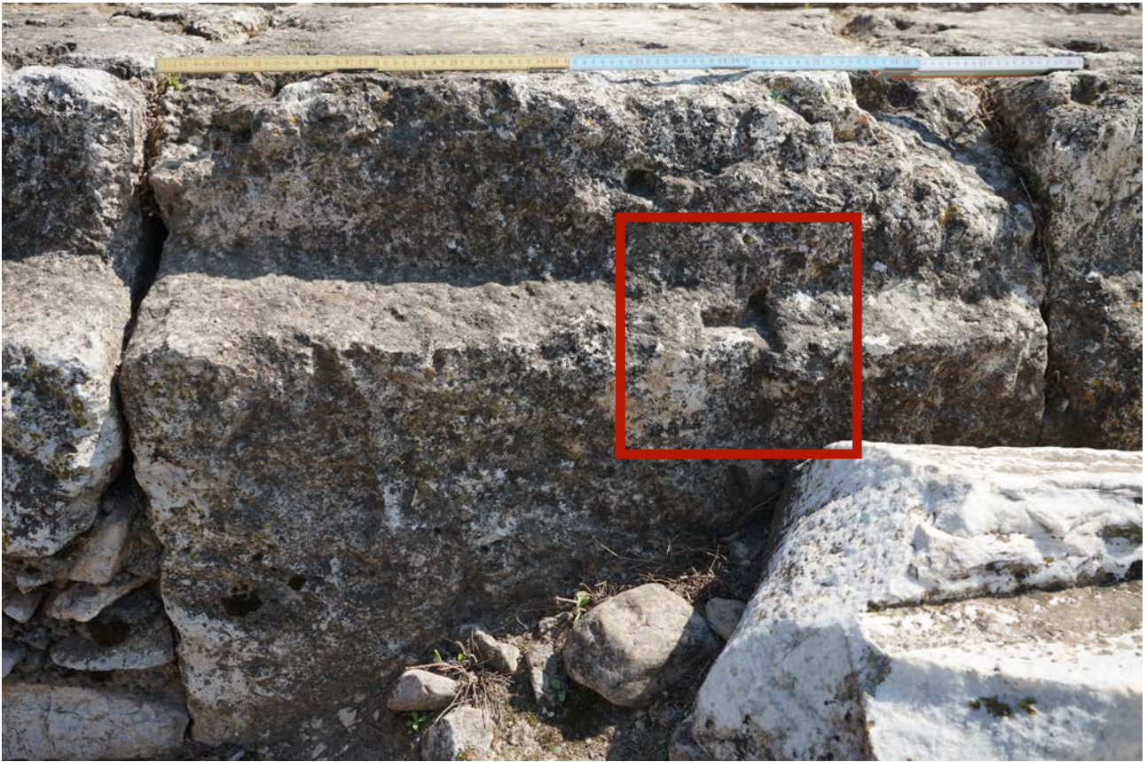
εικ. 25: ίχνη οπής συνδέσμου των βαθμίδων σε λίθο του στερεοβάτη
