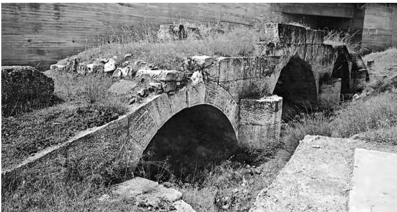
εικ. 4: Η τετράτοξη γέφυρα που οικοδομήθηκε επί Αδριανού (Λερίου)
