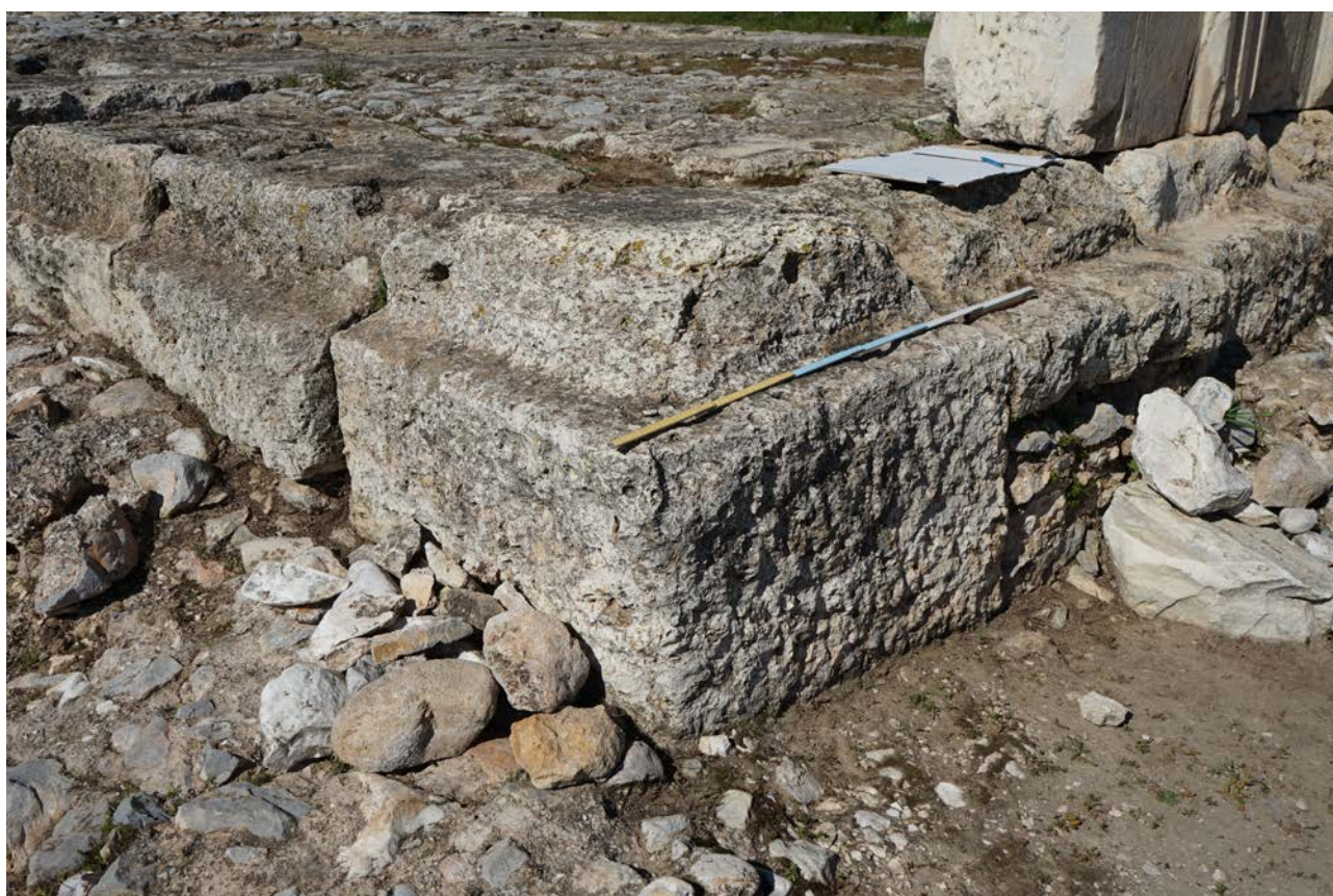
εικ. 24: ΝΔ γωνία στερεοβάτη, διακρίνεται η χαρακτηριστική τομή έδρασης των αναβαθμών
