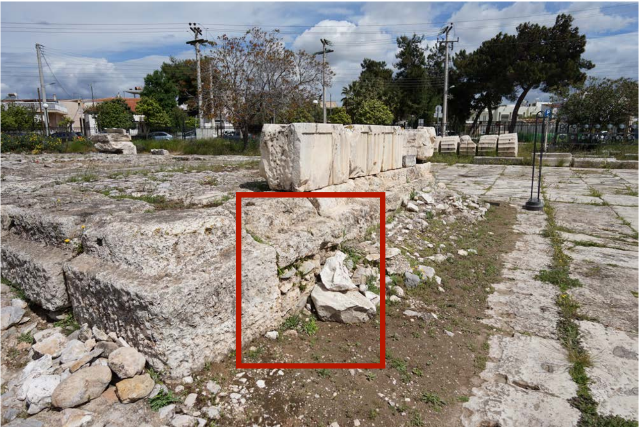
εικ. 30: ΝΔ γωνία στερεοβάτη, διακρίνεται το opus caementicium
