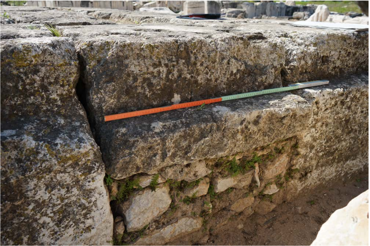
εικ. 29: στερεοβάτης οπισθοδόμου, πωρόλιθος επί opus caementicium
