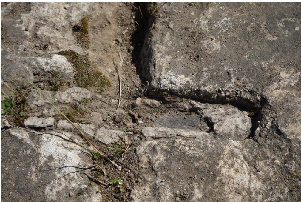
εικ.23: σωζόμενος πειόσημος σύνδεσμος
