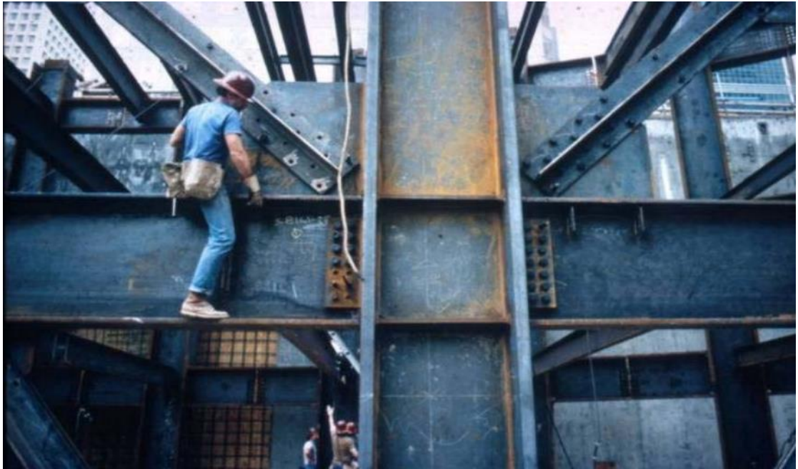
Σχήμα 1.14: Τυπική κοχλιωτή σύνδεση κόμβου υποστυλώματος δοκού
