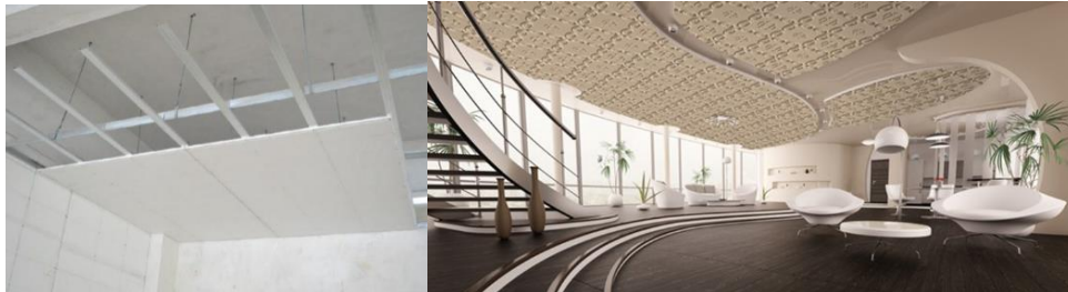
Σχήμα 2.4 – 2.5: Επενδύσεις οροφής στο αρχικό και τελικό στάδιο αντίστοιχα
