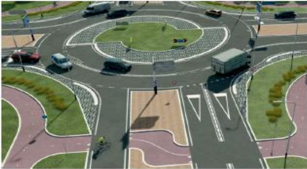
Εικόνα 2.9 : Turbo-roundabout – Πηγή : (Giuffre, Guerrieri, & Grana, 2009)
