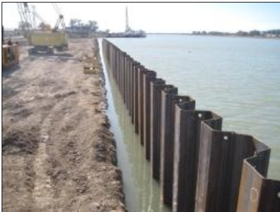
Εικόνα 10. Κατασκευή κρηπιδότοιχου με σιδηροπασσαλοσανίδες.
