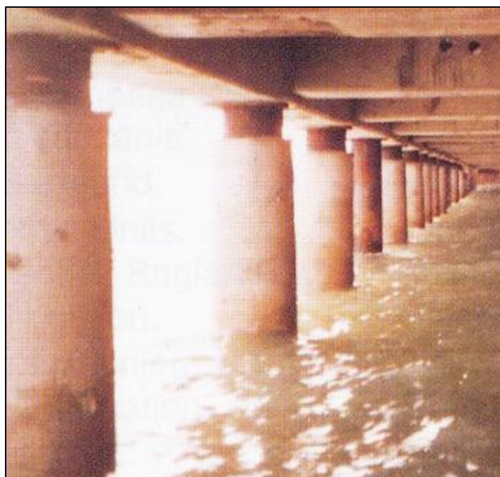
Εικόνα 11. Πάσσαλοι ανοικτού κρηπιδότοιχου.
