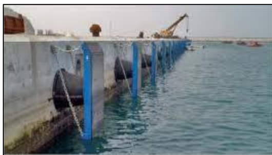
Εικόνα 6. Προσκραυστήρες τύπου SCN
