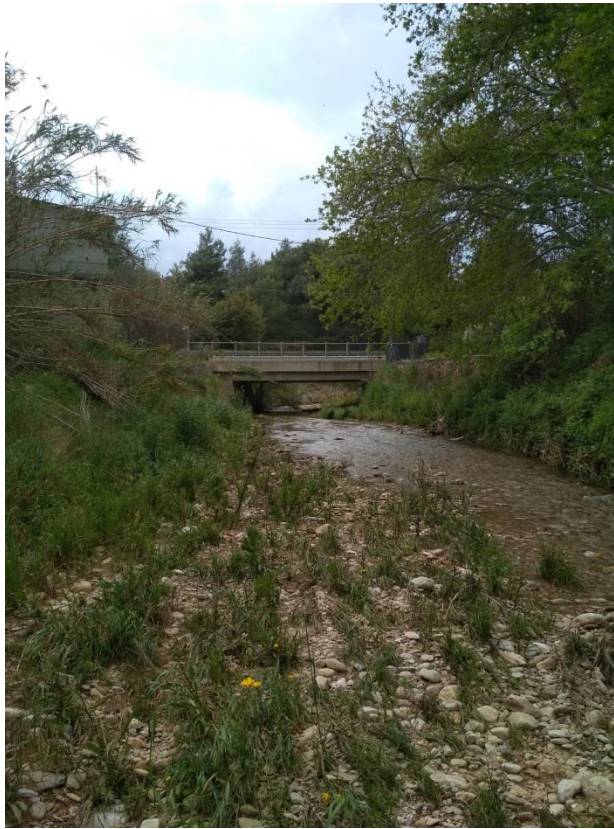
Εικόνα 3-27: Άποψη της γέφυρας Αγ. Δημητρίου από τη Θ4.
