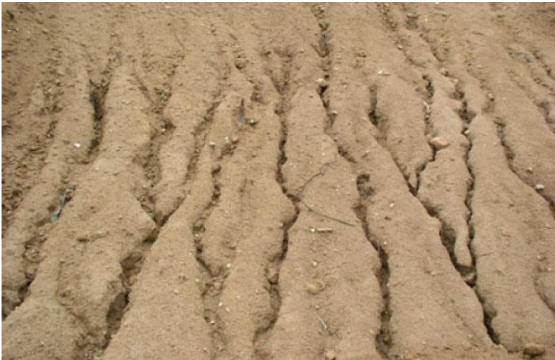
Εικόνα 1-3: Αυλακωτή διάβρωση εδαφικού πρανούς (Janduko, 2015).
