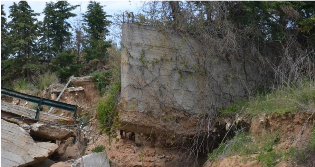
Εικόνα 3-51: Επικρεμάμενο τοιχίο στη Θ8. Από το προσωπικό αρχείο του Α. Λαζαρή.
