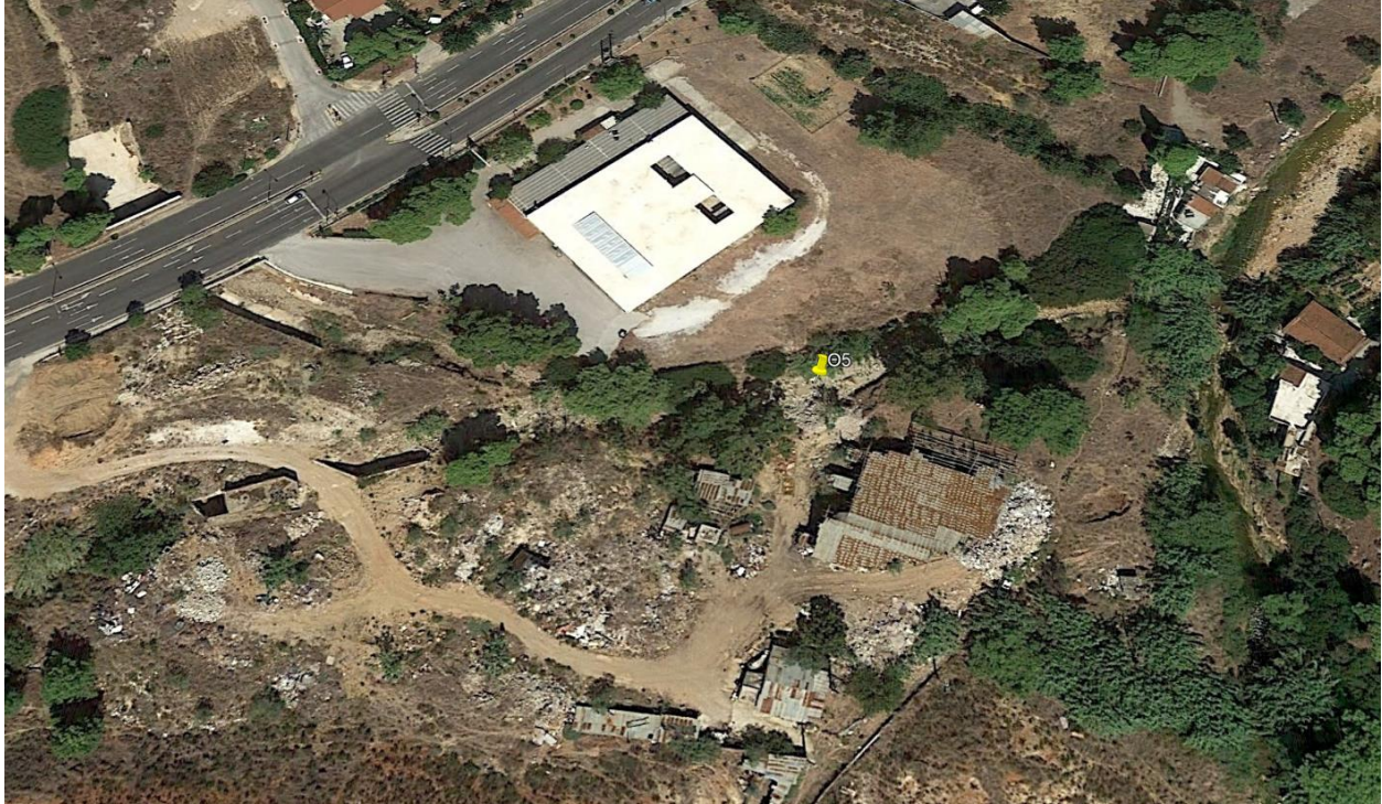
Εικόνα 3-39: Απεικόνιση της Θ5 από Google Earth. Φαίνεται η έκταση που καταλαμβάνουν τα μπάζα στην κοίτη του ρέματος.
