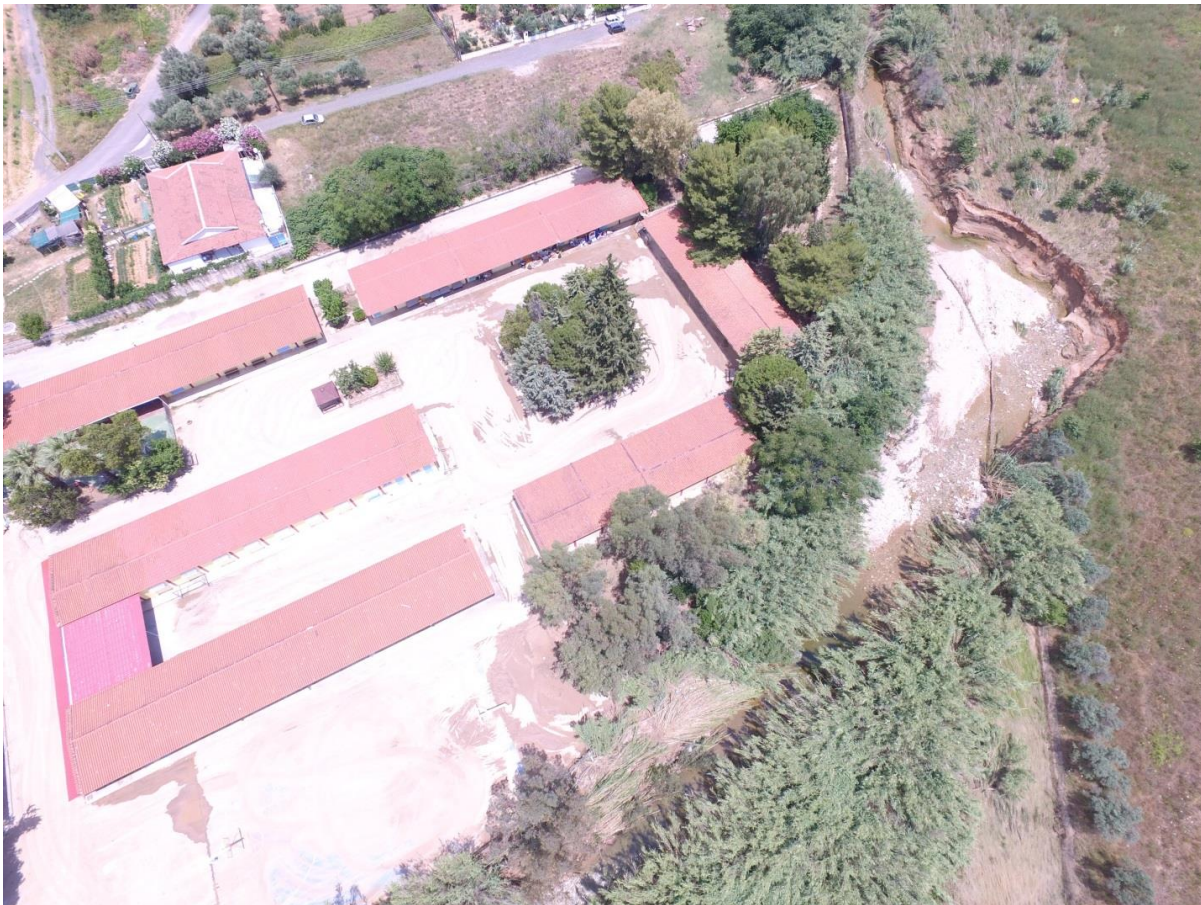
Εικόνα 3-45: Αεροφωτογραφία του σχολείου στη Θ6. Φαίνονται τα φερτά υλικά στον προαύλιο χώρο.
