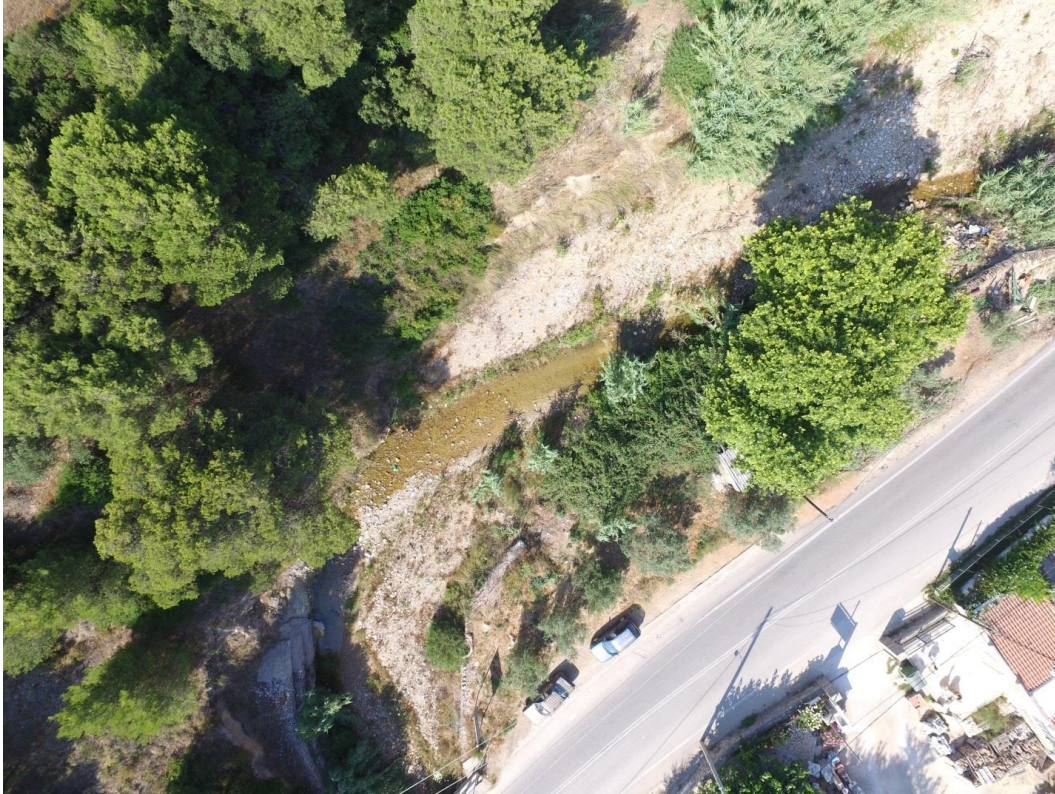
Εικόνα 3-25: Αεροφωτογραφία της θέσης όπου προτείνεται η τοποθέτηση ογκολίθων στη Θ3 στη βάση του δεξιού πρηνούς
