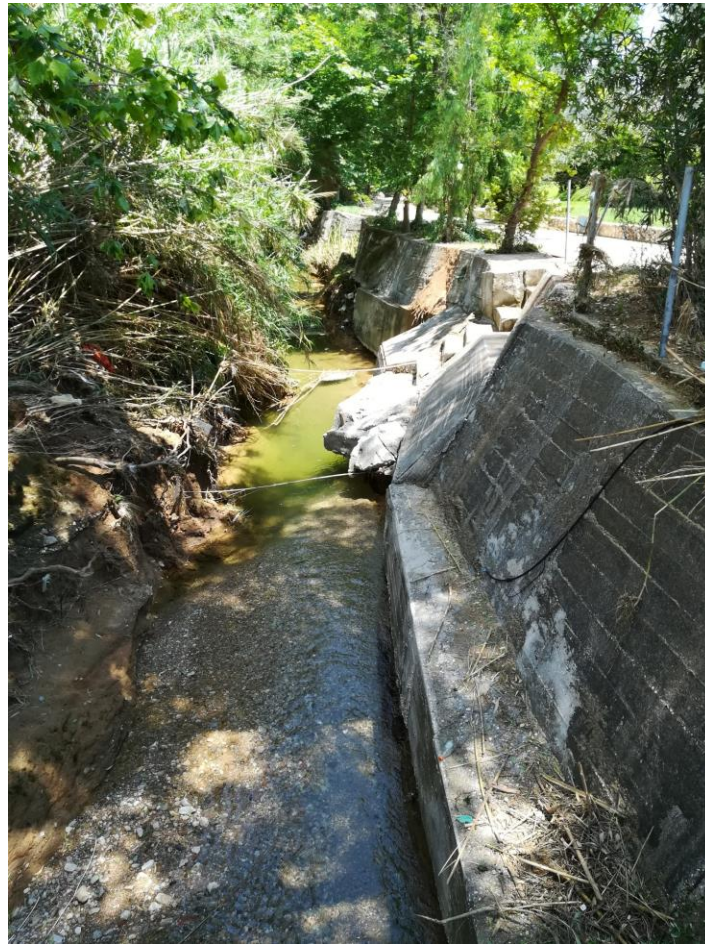
Εικόνα 3-47: Τοίχοι αντιστήριξης κατά μήκος της κοίτης κατάντη της Θ7.
