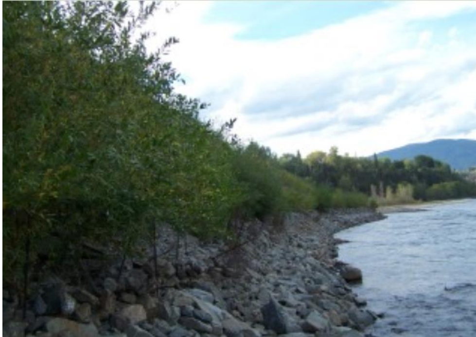
Εικόνα 1-14: Λιθορριπή με φύτευση 5 χρόνια μετά την εγκατάσταση στον ποταμό Columbia (Terra Erosion Ltd., 2010a)
