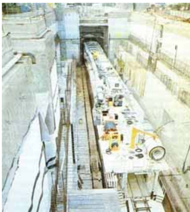
Εικόνα 2.7 - Πανοραμική εικόνα της υποστήριξης του TBM στο σταθμό της Κατεχάκη, πριν την έναρξη των εργασιών
