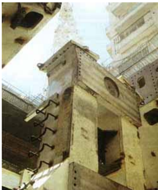
Εικόνα 2.8 - Πανοραμική εικόνα κατά τη συναρμολόγηση της Ασπίδας Ανοικτού Μετώπου (OFS), στο σταθμό "Δάφνη", για την εκσκαφή του μεσοδιαστήματος Δάφνη - Άγιος Ιωάννης.
