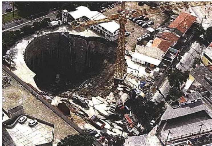
Εικόνα 2.1 - Κατάρρευση οροφής σήραγγας, Σάο Πάολο, Βραζιλία, 2007 (Barton 2007).
