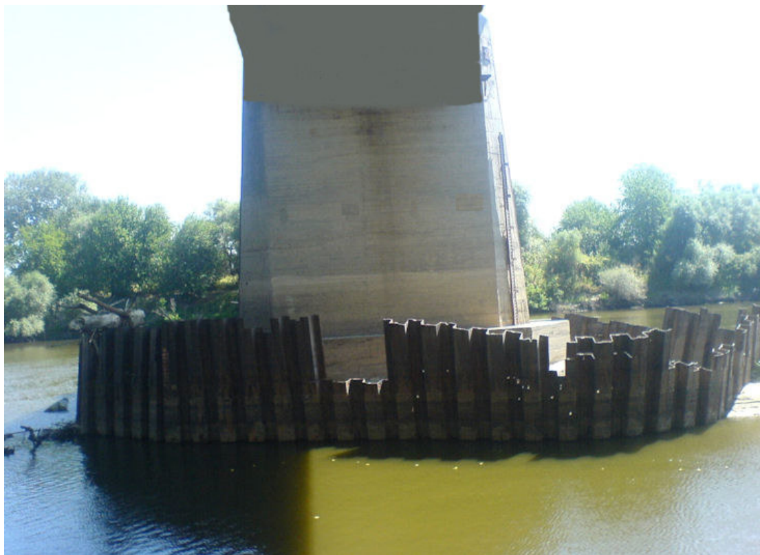
Εικόνα 6-5 6 : Προστασία μεσόβαθρου της γέφυρας των Κήπων.
