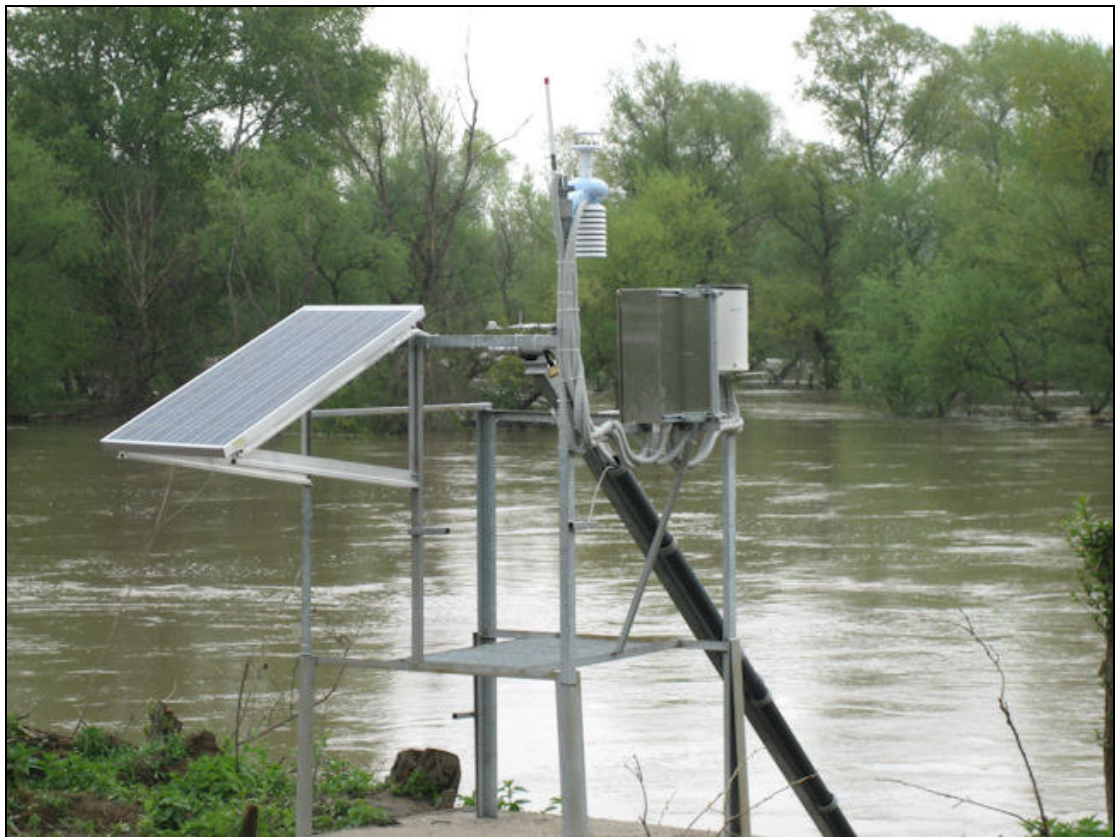
Εικόνα 6-1: Ο ΑΤΣ πλησίον του συνοριακού σταθμού Ορμένιου.
