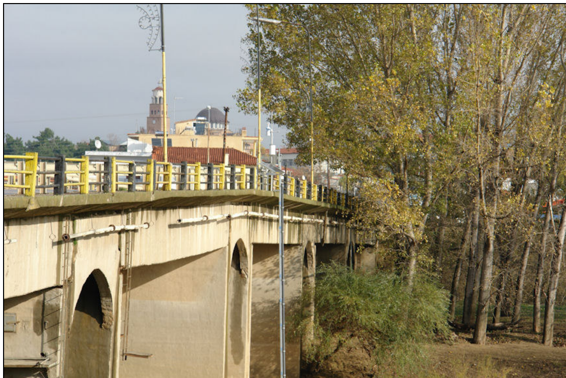
Εικόνα 6-2: Ο ΑΤΣ της παλαιάς γέφυρας Διδυμοτείχου στον Ερυθροπόταμο.
