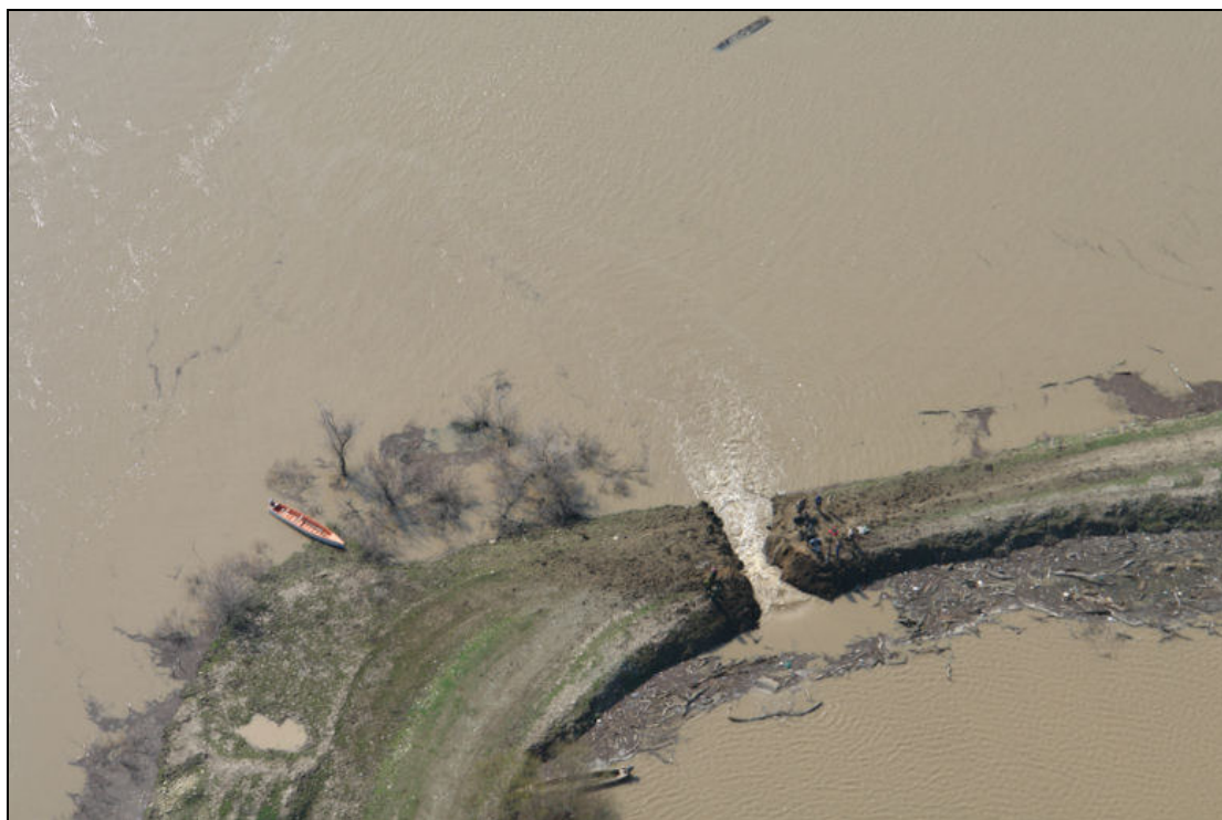
Εικόνα 5-3: Ανατίναξη της έμφραξης στο Δέλτα του Έβρου, πλημμύρες 2006.
