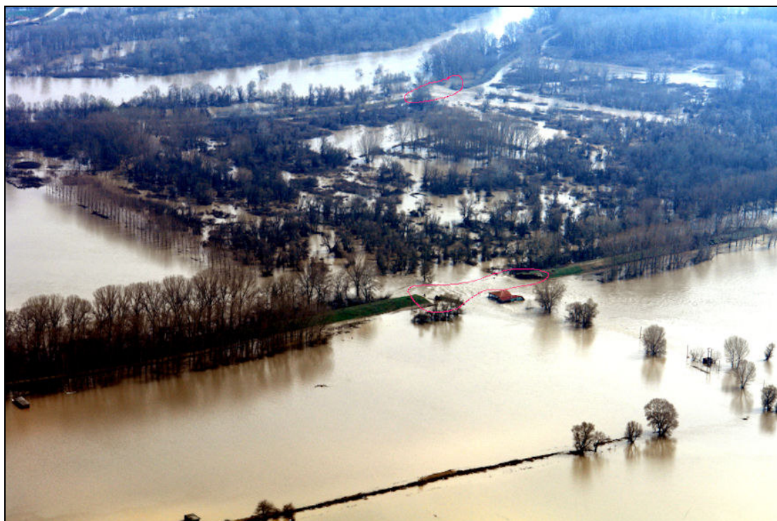
Εικόνα 5-1: Ρήγματα στα παράλληλα αναχώματα, πλημμύρες 2006.
