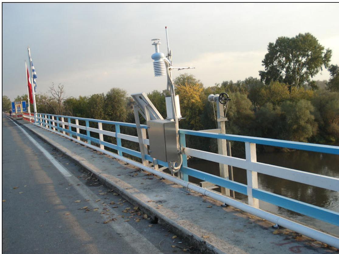
Εικόνα 6-4: Ο ΑΤΣ στη γέφυρα των Κήπων.
