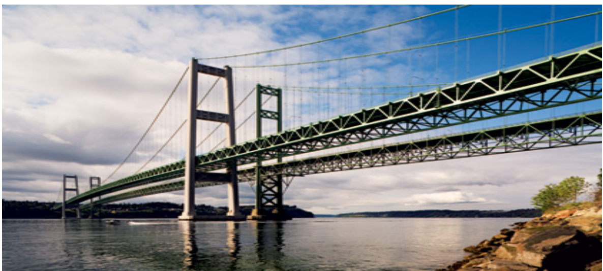
Σχήμα 1.6: Η σύγχρονη κρεμαστή γέφυρα με δικτυωτούς δοκούς.
