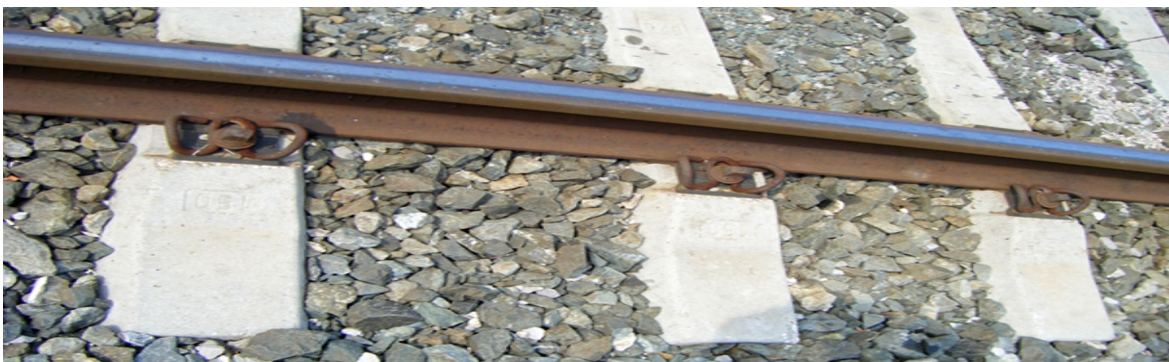
Σχήμα 2.4 : Κλασική επιδομή με έρμα
