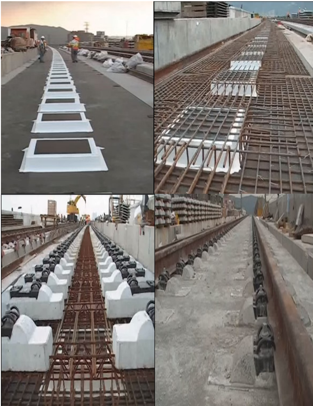
Σχήμα 2.8 : Πορεία εγκατάστασης συστήματος Rheda 2000 με οδοντώσεις
