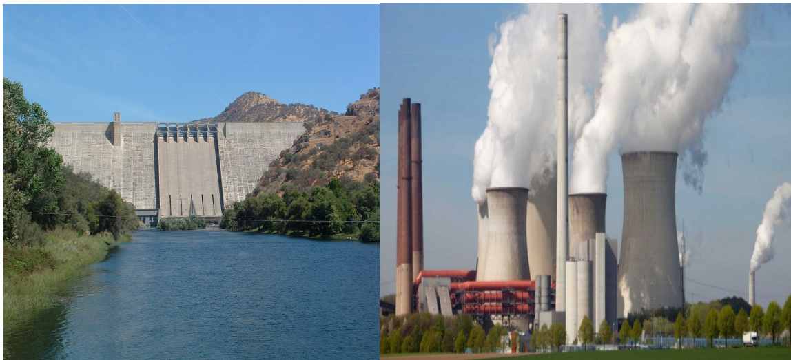
Σχήμα 4.8: Συστήματα κατανεμημένων μαζών α) Φράγμα Pine Lane β) Καπνοδόχος Aramon, Γαλλίας
