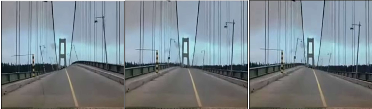
Σχήμα 1.5: Στρέψη καταστρώματος
