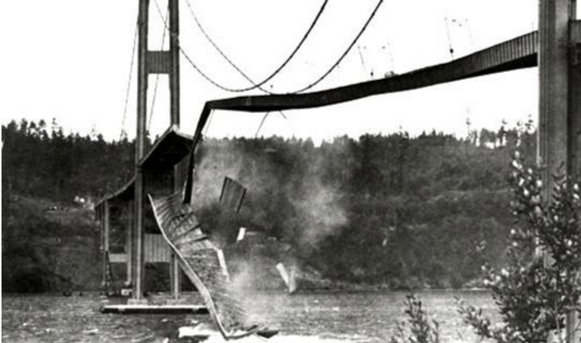
Σχήμα 1.3: Κατάρρευση της Tacoma Narrows Bridge
