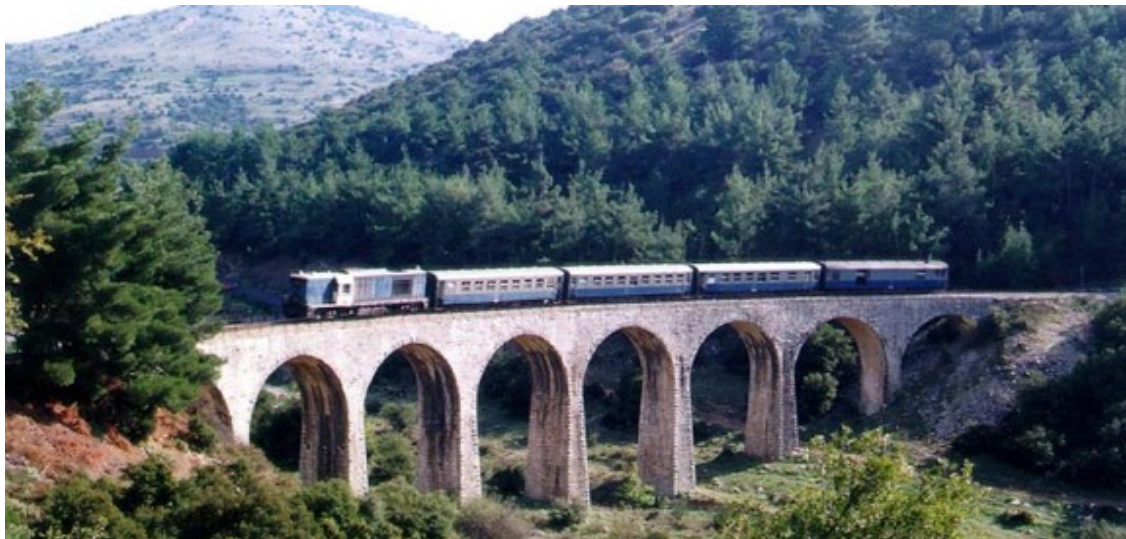
Σχήμα 5.1 : Γέφυρα δύσκαμπτου καταστρώματος και εύκαμπτης επιδομής.
