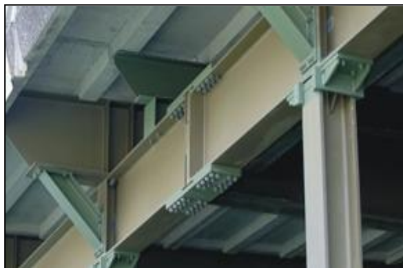
Εικ. 2.7 Λεπτομέρεια σύνδεσης στη στοά Nasse Kehle [Synaxis, 2011].
