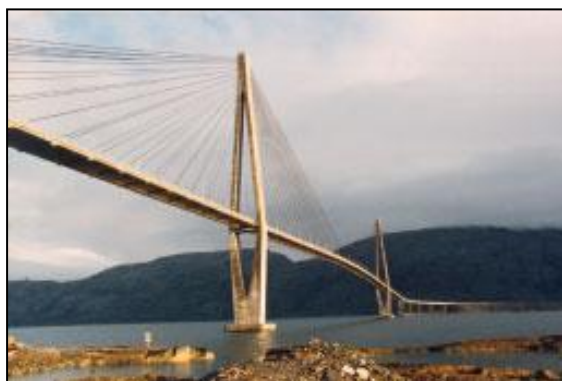
Εικ. 5.95 Γέφυρα Helgeland [Svensson H. 2009].
