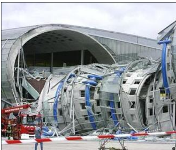
Εικ. 1.3 Μερική κατάρρευση στο αεροδρόμιο Charles de Gaulle του Παρισιού [Starossek U. 2006].
