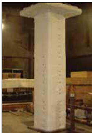
Εικ. 1.7 Υποστώλωμα επιχρισμένο με αντιπυρικό υλικό [Wada A. et al. 2006].
