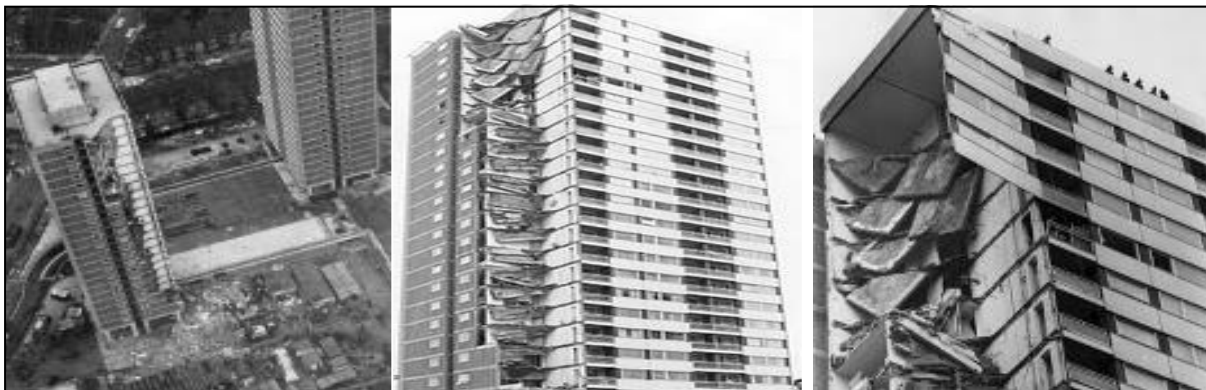
Εικ. 1.1 Προοδευτική κατάρρευση του Ronan Point λόγω έκρηξης φυσικού αερίου [Nielsen J.J 2009].
