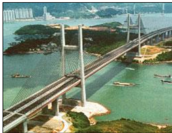
Εικ. 5.88 Γέφυρα Kap Shui Mun [Svensson H. 2009].
