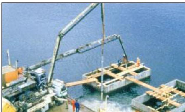
Εικ. 5.96 Βάθρα γέφυρας Helgeland [Svensson H. 2009].
