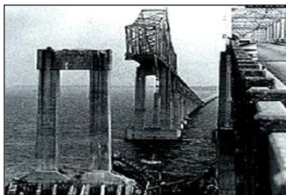
Εικ. 5.78 Κατάρρευση γέφυρας Sunshine [Wikipedia, 2011].
