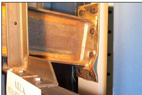
Εικ. 4.51 Αστοχία μετωπικής πλάκας σε σύνδεση ροπής [Bagias I et al. 2008].
