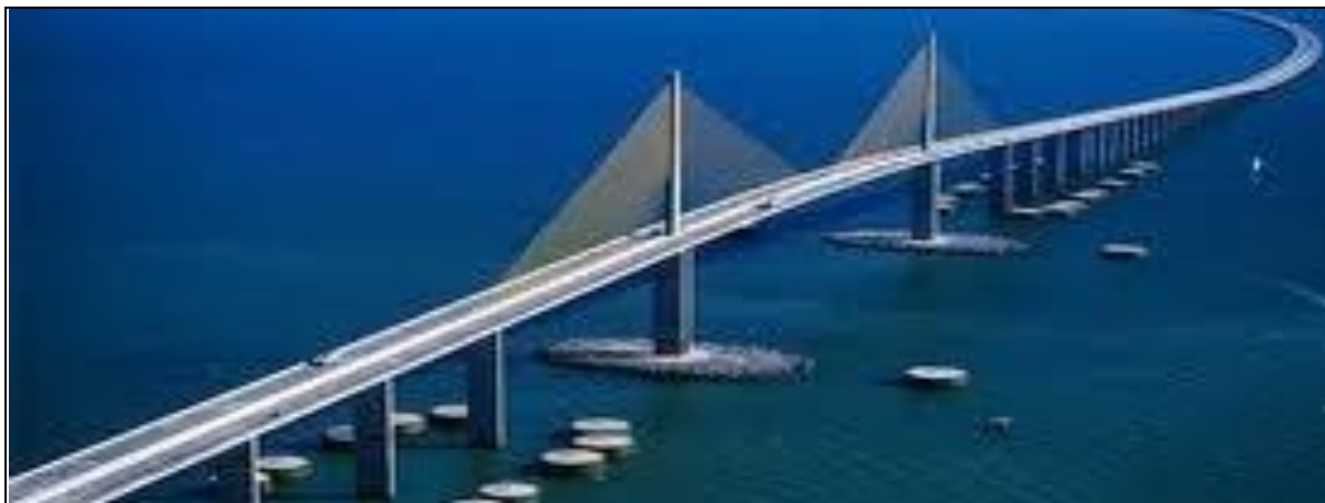
Εικ. 5.79 Η γέφυρα Sunshine Skyway με τις προστατευτικές διατάξεις στα βάθρα [Google images].
