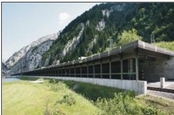
Εικ. 2.6 Η στοά Nasse Kehle [Synaxis, 2011].
