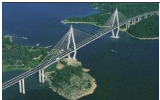
Εικ. 5.97 Γέφυρα Uddevalla [Svensson H. 2009].
