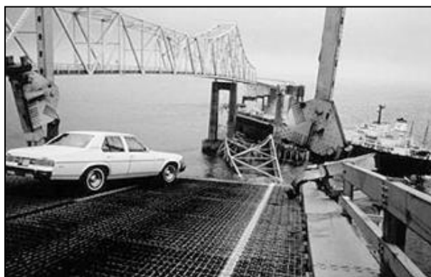
Εικ. 5.77 Κατάρρευση γέφυρας Sunshine [Wikipedia, 2011].
