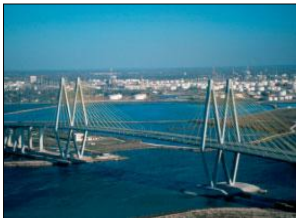
Εικ. 5.87 Γέφυρα στο Houston Ship Channel Crossing [Svensson H. 2009].
