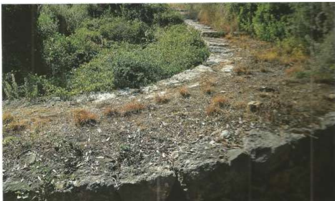
Εικόνα 4 : Τμήμα του λιθόστρωτου δρόμου της Μάνης, στην βόρεια πλευρά της παραλίας Φονέα του Νέου Προαστίου
