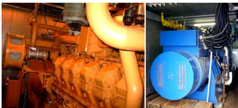
Σχήμα 7. ΜΕΚ ενεργειακής αξιοποίησης του Βιοαερίου
