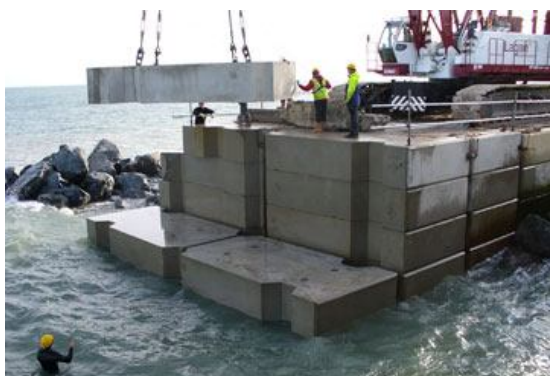
Εικ. 3.30: Κατασκευή κρηπιδότοιχου [95]
