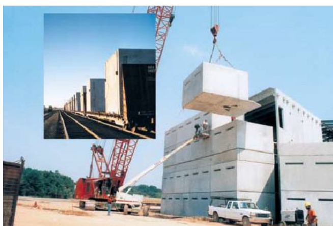
Εικ. 3.29: Τοποθέτηση κυψέλης [33]
