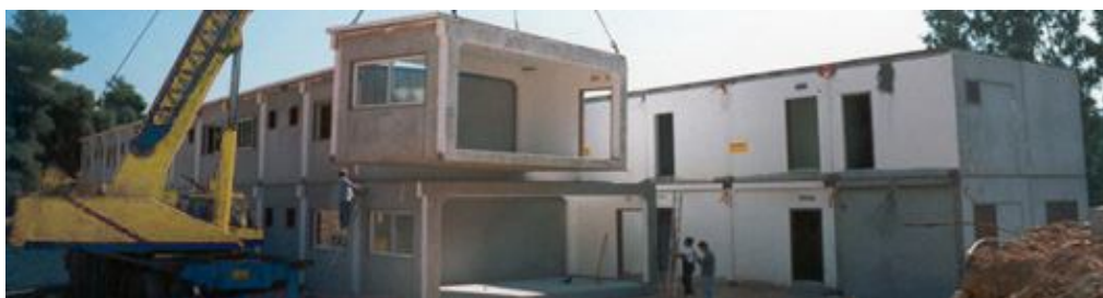
Εικ. 3.4: Ανέγερση κτηρίου με τη μέθοδο των προκατασκευασμένων κυψελών (χωρική προκατασκευή) [71]
