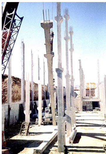
Εικ. 3.2: Προκατασκευασμένα υποστυλώματα μεγάλου ύψους (γραμμική προκατασκευή) [71]
