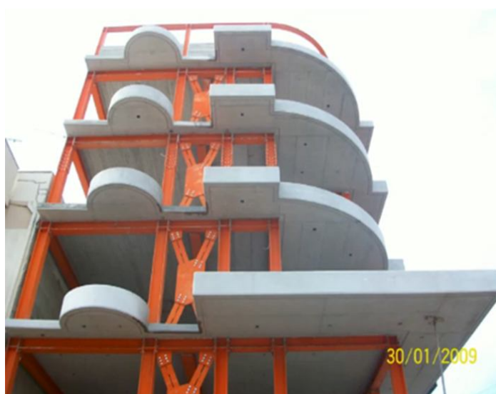
Εικ. 3.9: Στοιχεία φέροντος οργανισμού σύμμικτης κατασκευής [73]
