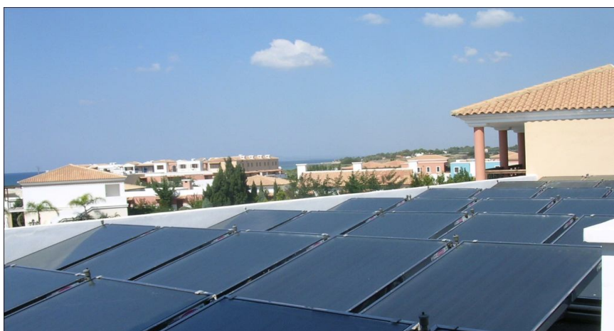
Εικ. 4.15: Ηλιακό πεδίο παραγωγής ζεστού νερού στο ξενοδοχειακό συγκρότημα Aldemar OlympianVillage [96]
