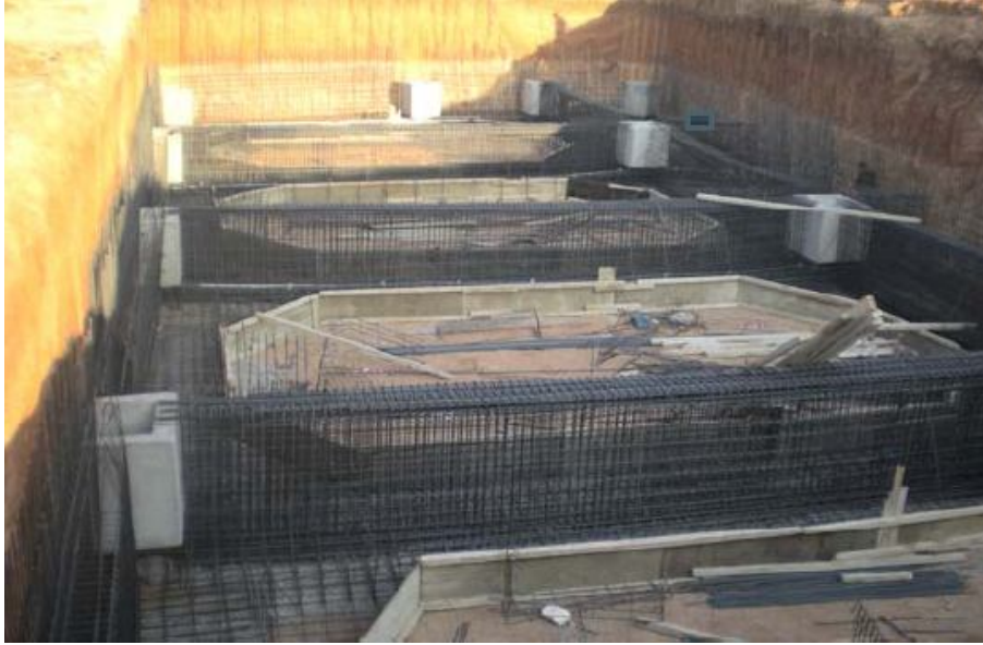
Εικ. 3.11: Προκατασκευασμένες θήκες θεμελίωσης και σιδέρωμα πεδιλοδοκών[22]
