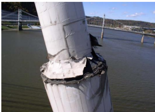
Σχήμα 7.19: Αστοχία σε καλώδιο μεταλλικής γέφυρας
