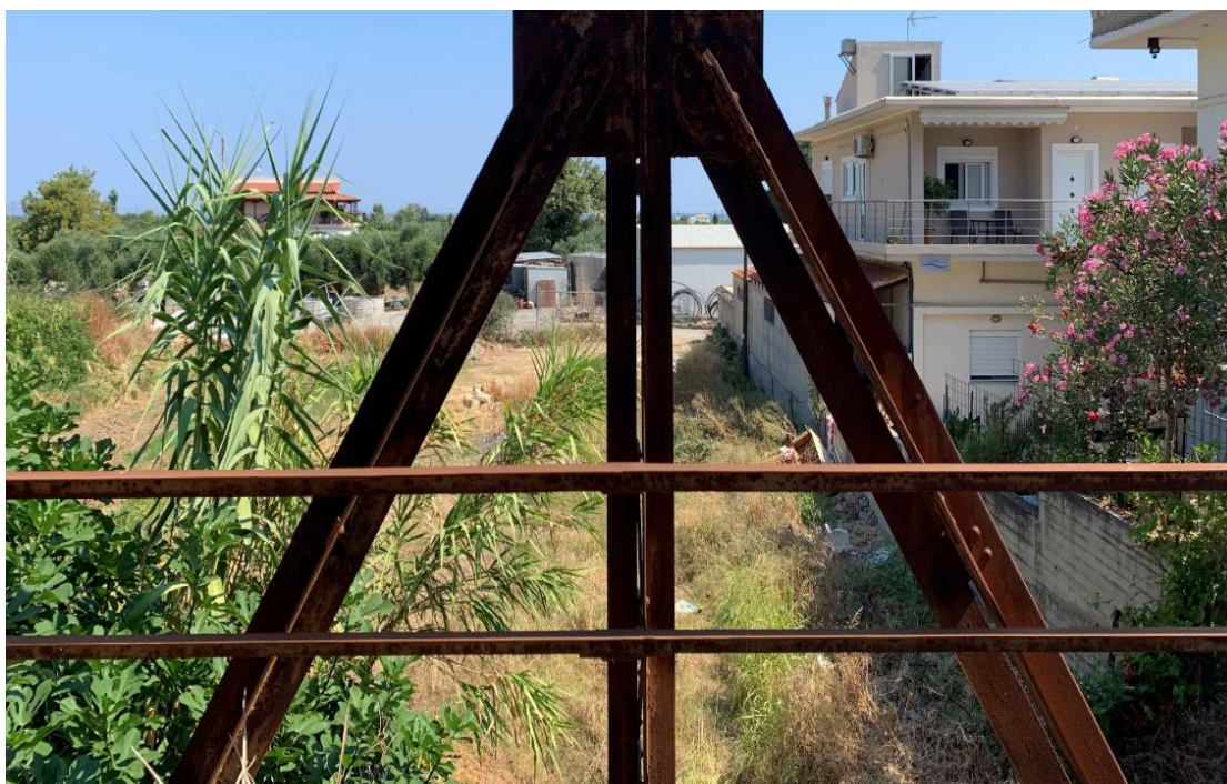
Σχήμα 11.20: Διάβρωση διαγώνιων μελών .
