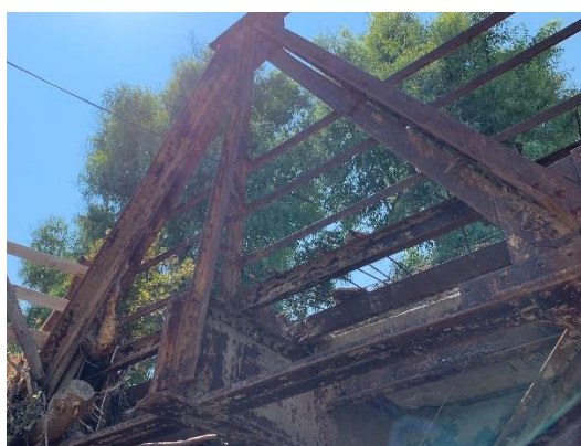
Σχήμα 11.15: Στους κόμβους στήριξης δεν υπάρχουν ορθοστάτες
