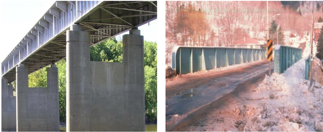
Σχήμα 7.2: Συστήματα 2 δοκών – Μεταλλικές γέφυρες
