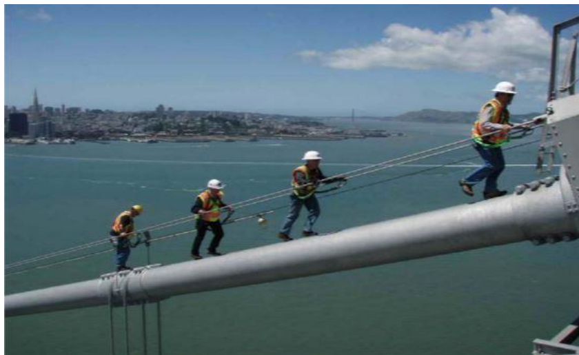
Σχήμα 10.4: Επιθεώρηση καλωδίου από μηχανικούς
