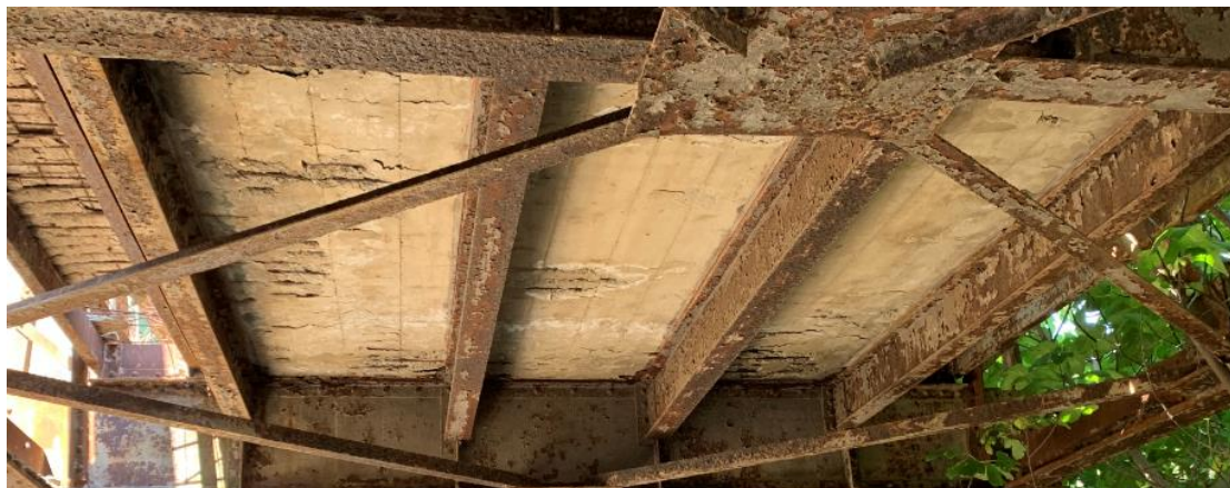
11.16: Ενδιάμεσες υψίκορμες διαμήκεις δοκοί
