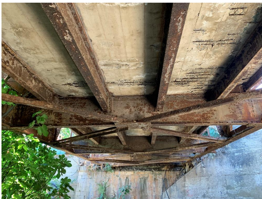
Σχήμα 11.17: Χιαστί σύνδεσμοι συνδεόμενοι σε κομβοέλασμα, αλλά και σε κύριες δοκούς.
