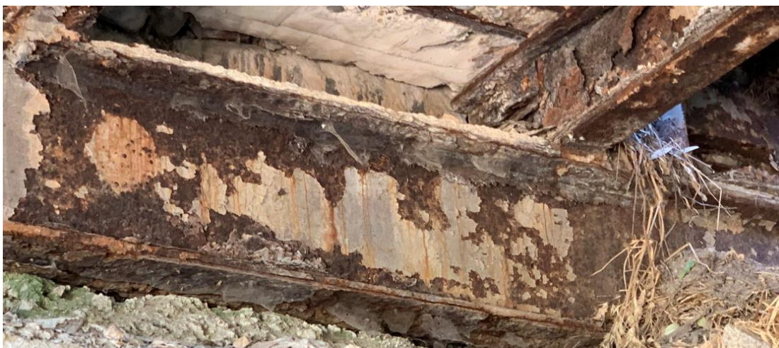
Σχήμα 11.27: Εγκάρσια δοκός με αρκετά εξελιγμένο το επίπεδο διάβρωσης.
