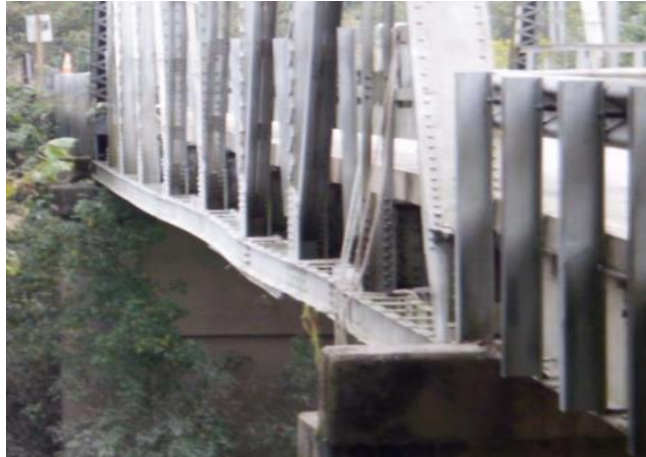
Σχήμα 7.5: Λυγισμός κύριων δοκών λόγω μετακίνησης των ακροβάθρων
