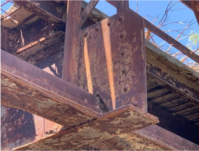
Σχήμα 11.13: Λεπτομέρεια κύριας δοκού με εγκάρσια δοκό
