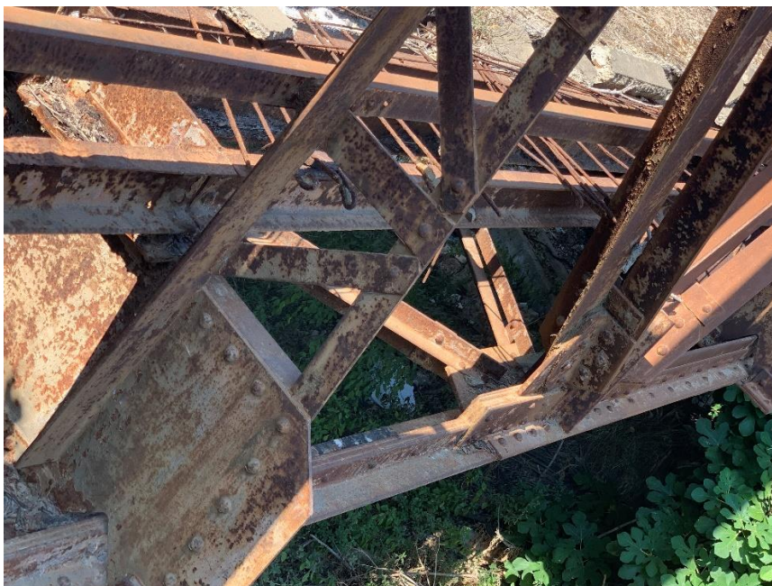
Σχήμα 11.6: Ορθοστάτης της γέφυρας και σύνδεσης του με διαδοκίδα.
