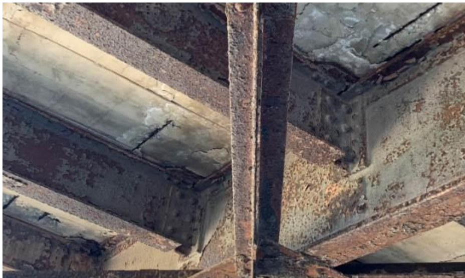
Σχήμα 11.51: Σύνδεση των διαμήκων ΙΡΕ240 με τις εγκάρσιες ΗΕΑ600
