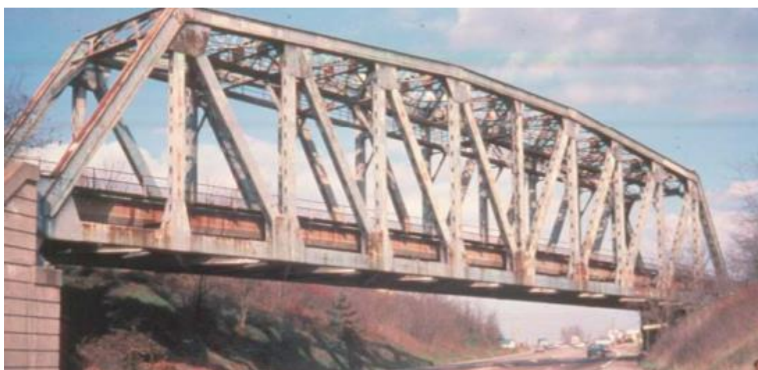
Σχήμα 7.4: Δικτυωτή μεταλλική γέφυρα ενός ανοίγματος
