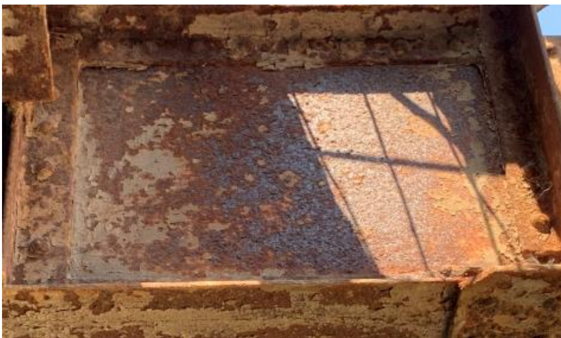
Σχήμα 11.28: Διάβρωση σε εξελιγμένη μορφή, μιας και σε σημεία η σκωρία εξέλασης έχει απομακρυνθεί λόγω διάβρωσης ή μπορεί να αφαιρεθεί με απόξεση, αλλά υπάρχουν και μικρές κοιλότητες βελονισμού που είναι ορατές με γυμνό μάτι.
