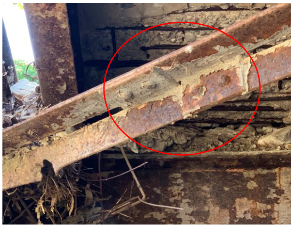
Σχήμα 7.12: Ελάσματα σύνδεσης μελών σε απόσταση (stay plates)
