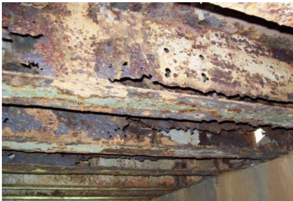
Σχήμα 4.1: Διάβρωση Διατομών – Οπές λόγω εκτεταμένης διάβρωσης
