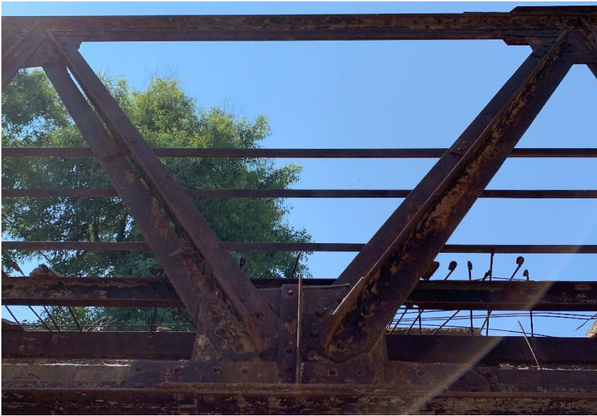
Σχήμα 11.8: Σύνδεση διαγωνίων όψης με έλασμα σύνδεσης στη κάτω κύρια δοκό της γέφυρας.
