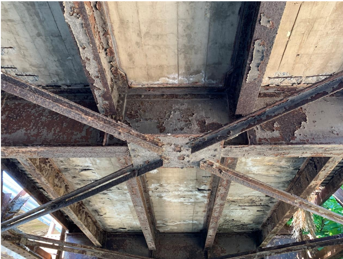
Σχήμα 11.40: Φανερή η διατήρηση του χρώματος ανά τόπους στους χιαστί συνδέσμους
