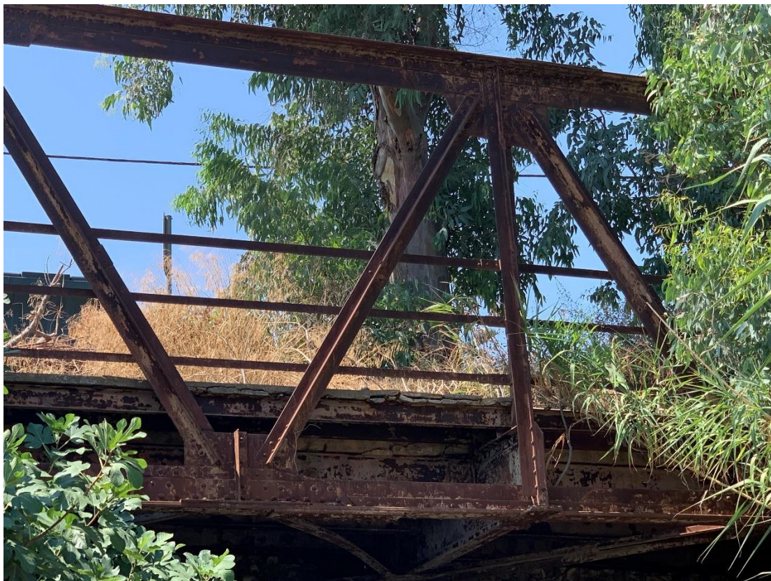
Σχήμα 11.19: Διάβρωση διαγώνιων μελών.
