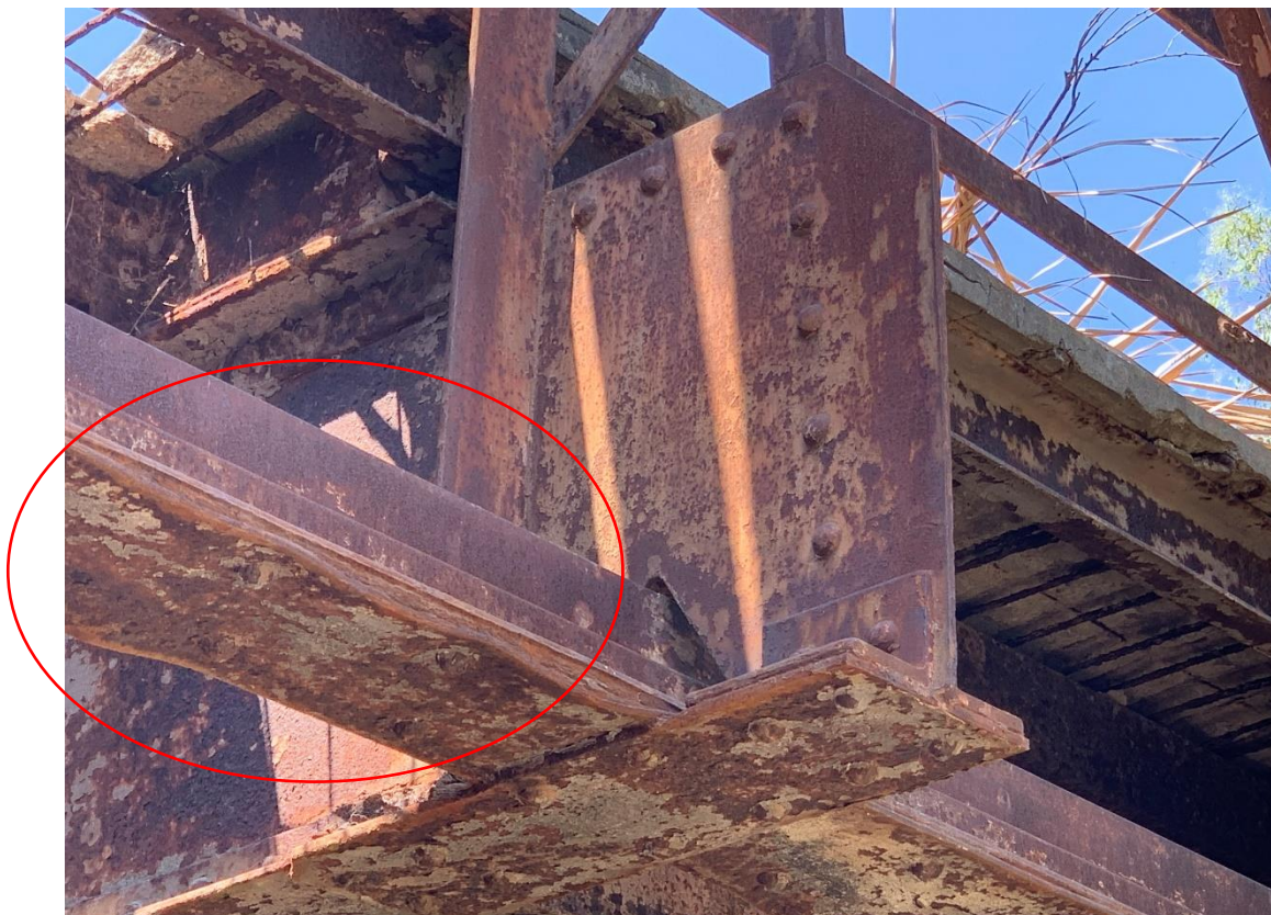
Σχήμα 11.41: Τοπικός λυγισμός στη κύρια δοκό στο πέλαμα ενίσχυσης της σύνθετης διατομής
