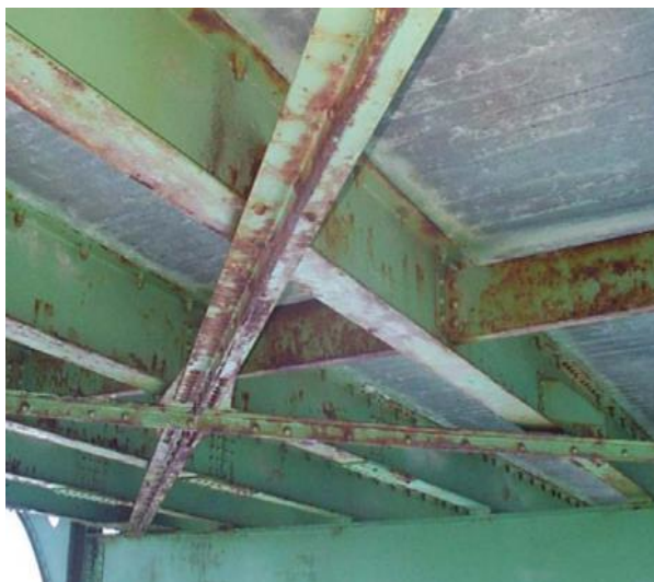
Σχήμα 7.9: Χιαστί σύνδεσμος δυσκαμψίας στο κάτω μέρος μεταλλικής γέφυρας υπό διάβρωση
