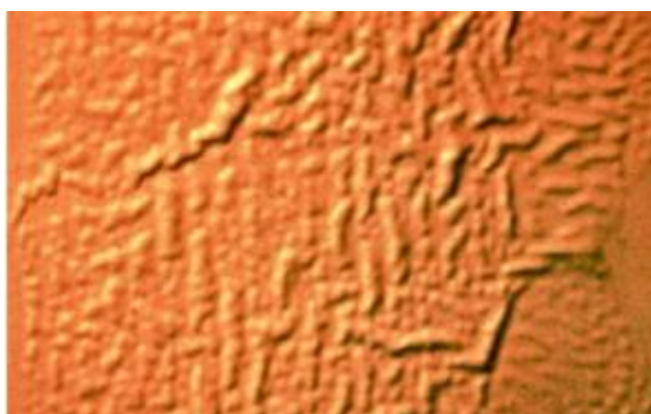
Σχήμα 4.2: Υπερβολική βαφή που οδηγεί σε ζάρες. Μη σωστή στρώση βαφής
