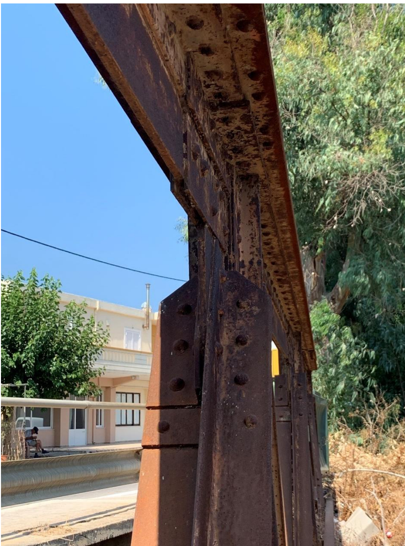
Σχήμα 11.36: Ύπαρξη δειγμάτων προστατευτικής βαφής στο άνω πέλμα δικτυώματος και όχι στο διαγώνιο μέλος
