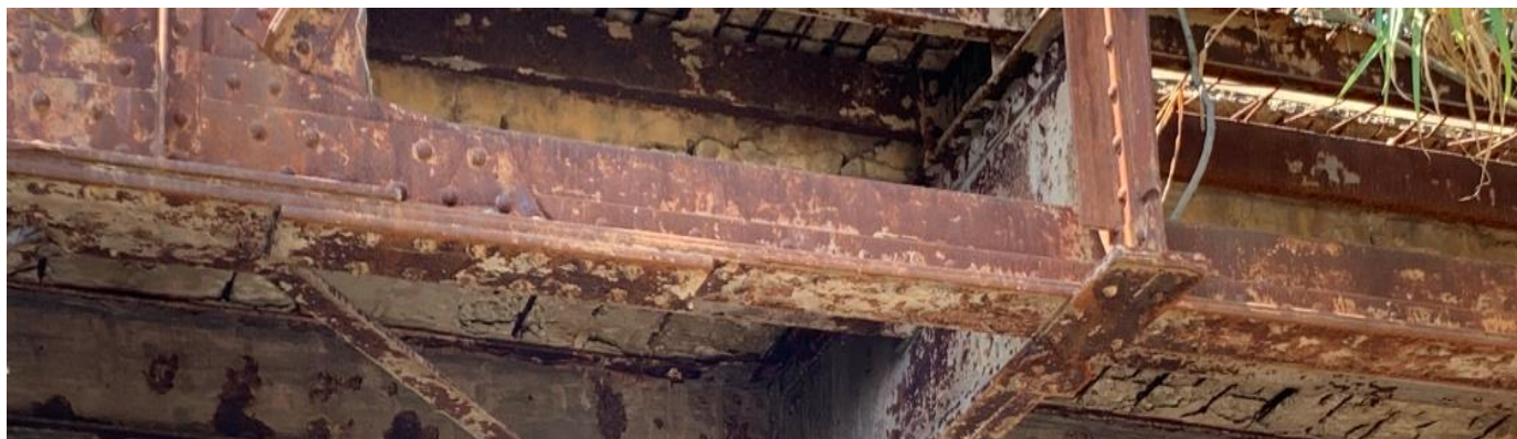
Σχήμα 11.38: Διάβρωση κάτω πελμάτων δικτύωσης.
