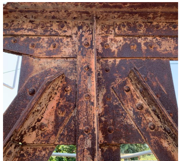
Σχήμα 7.10: Πλάκα σύνδεσης υπό έντονη διάβρωση
