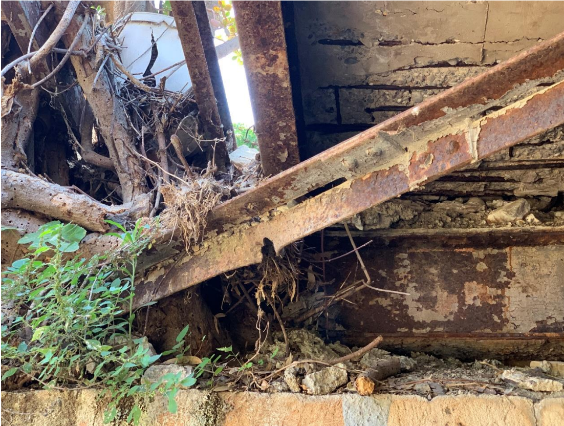
Σχήμα 11.42: Τρύπα που προκλήθηκε από εξέλιξη σχισμής διάβρωσης, σε διαγώνιο μέλος χιαστί
