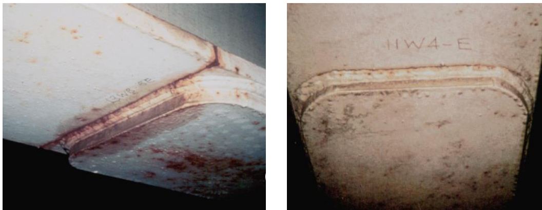
Σχήμα 5.2: Ρωγμές κατά μήκος της συγκόλλησης
