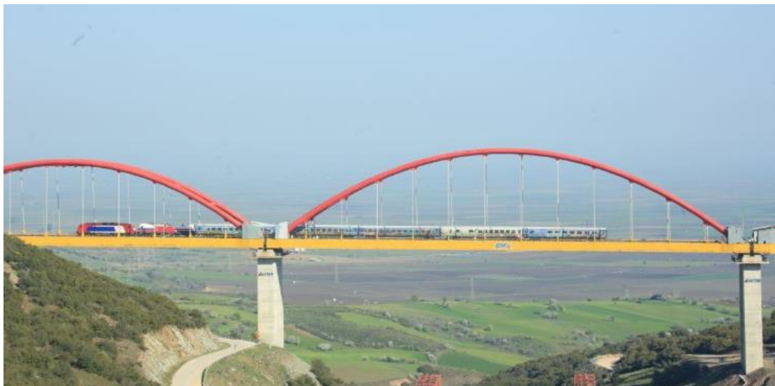
Σχήμα 7.13: Τοξωτή μεταλλική γέφυρα της Εκκάρας.
