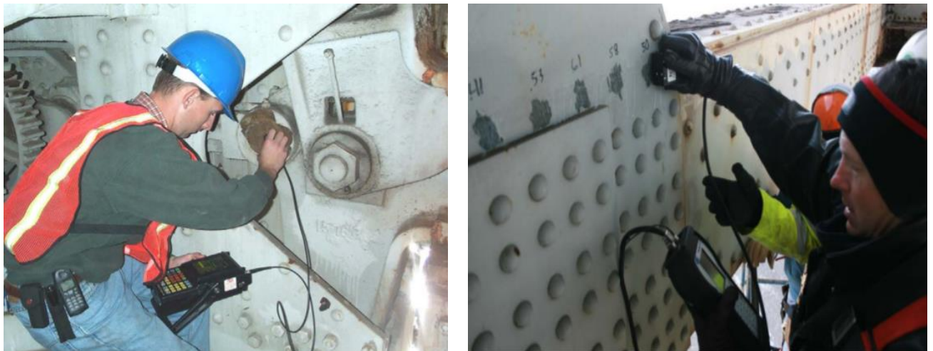
Σχήμα 6.7: Υπερηχητικός έλεγχος σε πείρο μετακινούμενης μεταλλικής γέφυρας
