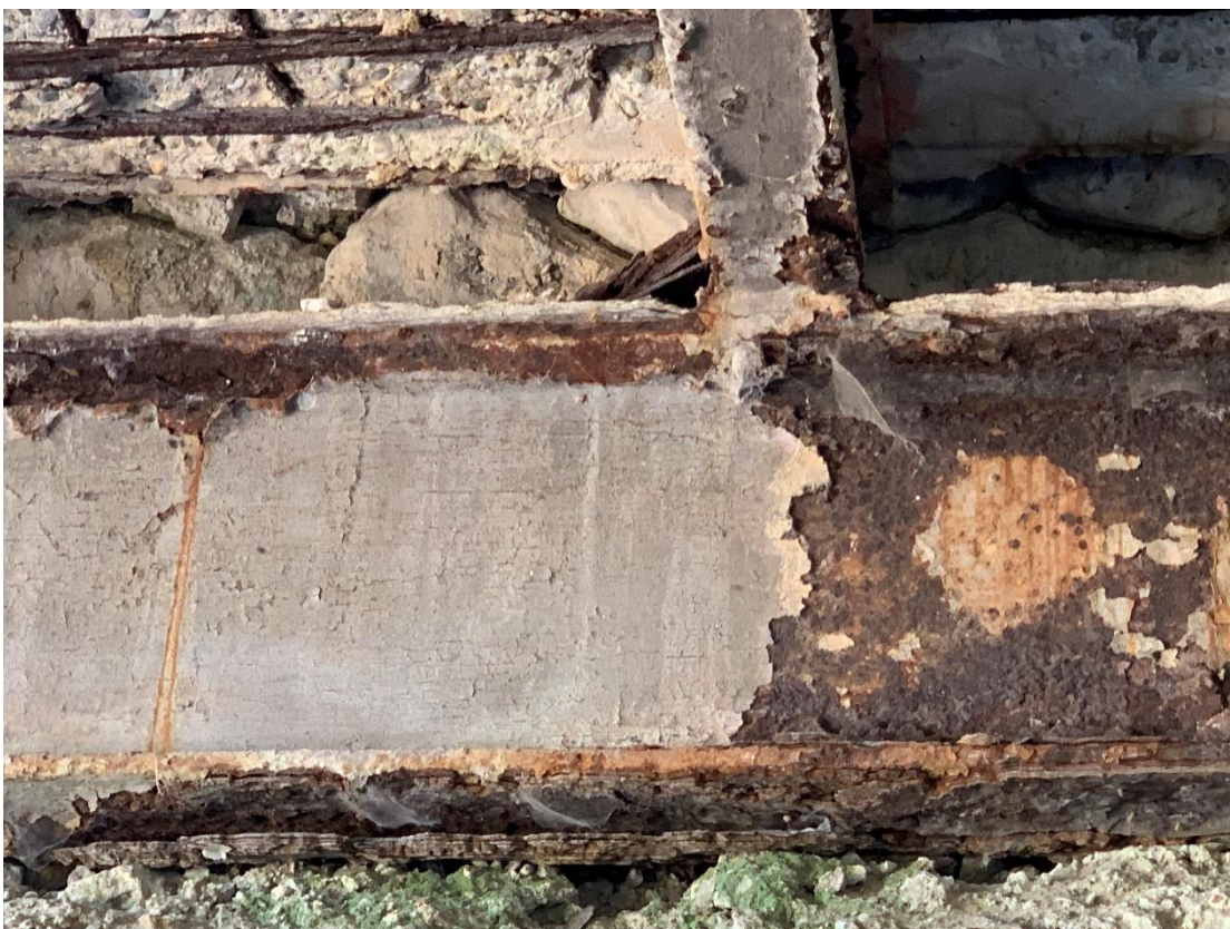
Σχήμα 11.30: Λεπτομέρεια εναλλαγής στην εξέλιξη της διάβρωσης στην ακραία εγκάρσια δοκό.
