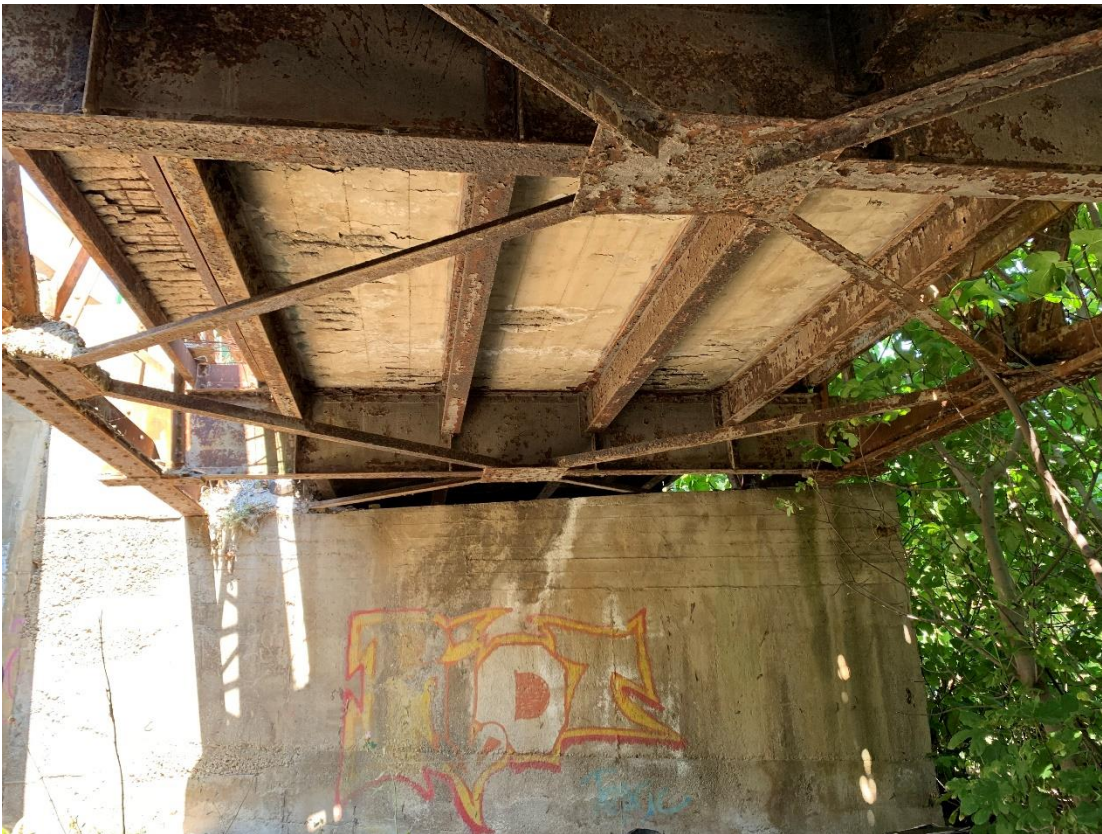
Σχήμα 11.33: Οι ενδιάμεσες διαμήκειες δοκοί δεν έχουν τόσο αυξημένο επίπεδο διάβρωσης. Αρκετές ενδείξεις ύπαρξης προστατευτικής βαφής.
