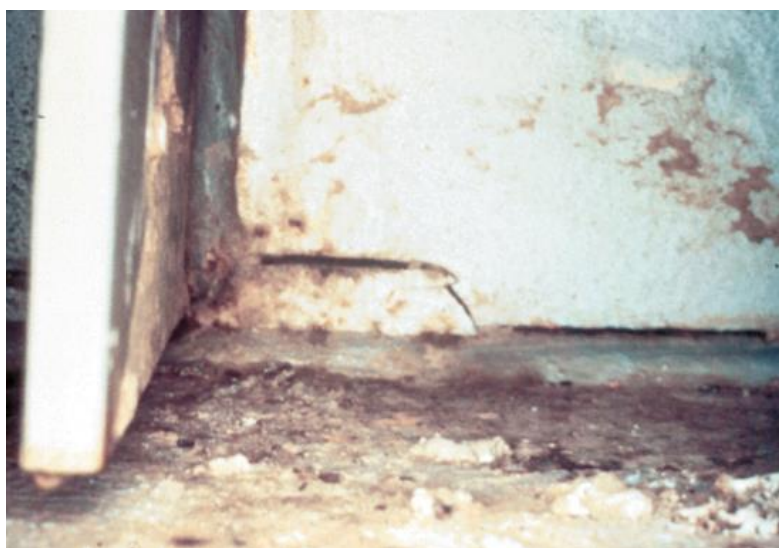
Σχήμα 5.3: Ρωγμή με κατεύθυνση το πέλμα του μέλους
