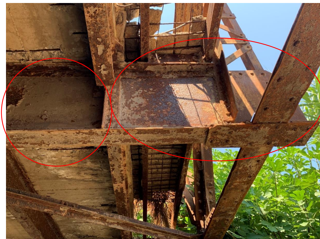
Σχήμα 11.32: Λεπτομέρεια διαφοροποίησης της διάβρωσης από τα μέσα προς τα άκρα
