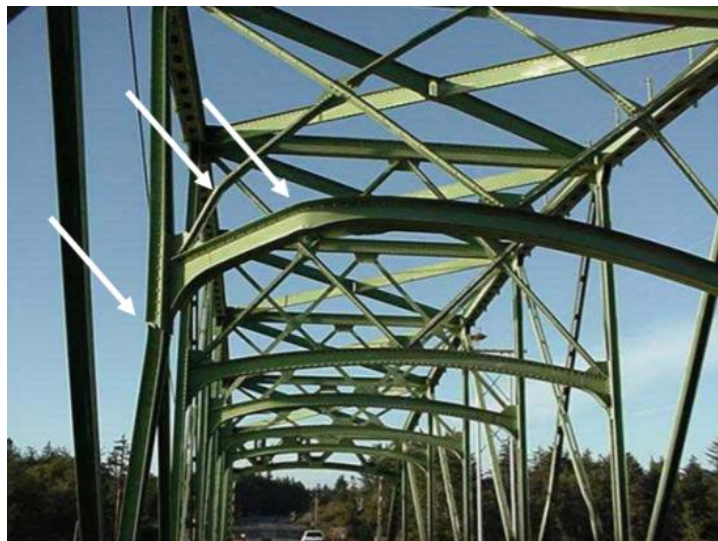
Σχήμα 7.6: Αστοχία μέλους δικτυώματος, λόγω σύγκρουσης οχήματος
