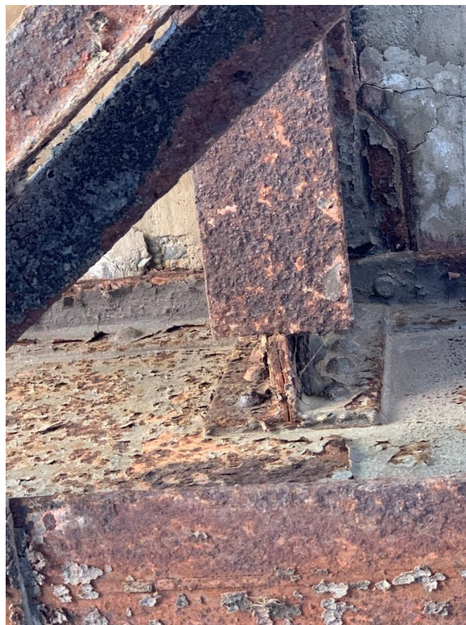
Σχήμα 11.52: Λεπτομέρεια σύνδεσης της ΙΡΕ240 με την ΗΕΑ600 διατομή
