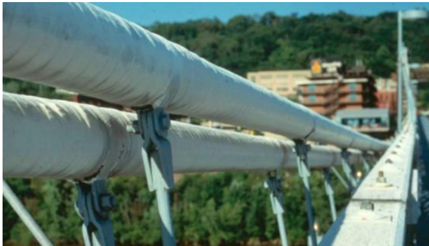
Σχήμα 10.3: Κάλυψη καλωδίου με πλαστική ταινία
