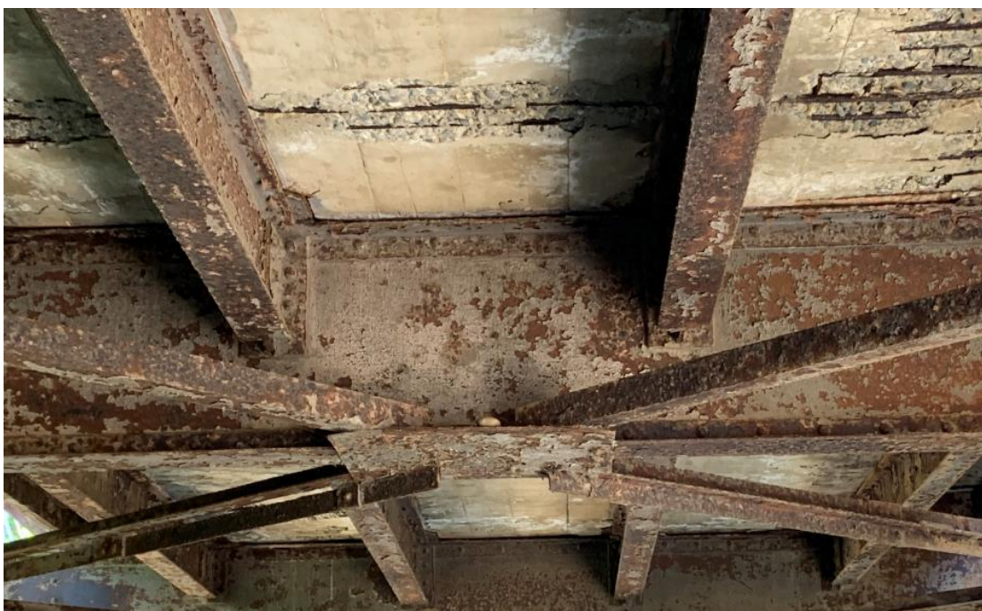
Σχήμα 11.35: Ενδιάμεσες διαμήκεις δοκοί στο μέσο της γέφυρας, με αυξημένη διάβρωση
