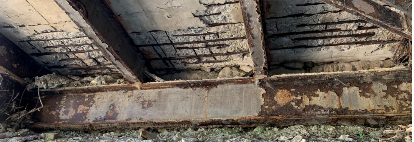
Σχήμα 11.29: Αντιπροσωπευτικό παράδειγμα της έντονης διάβρωσης τοπικά σε εγκάρσια δοκό.
