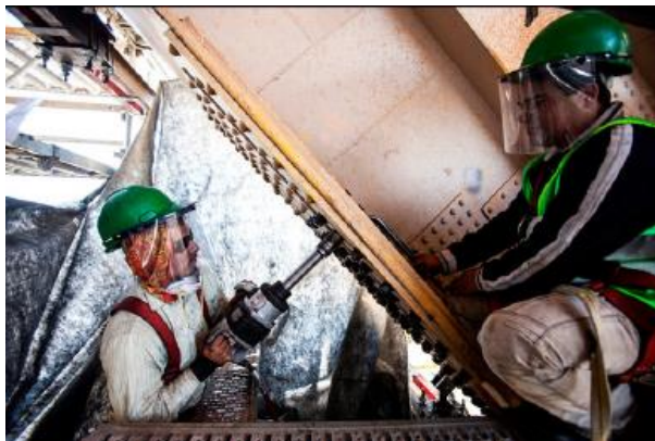
Σχήμα 10.1: Αντικατάσταση ήλων με υψηλής αντοχής κοχλίες
