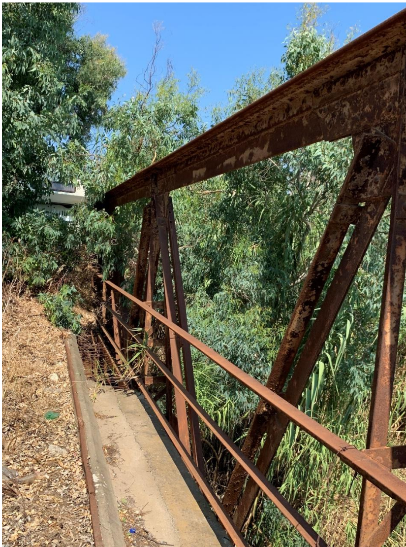
Σχήμα 11.18: Διάβρωση σε προχωρημένο στάδιο στα διαγώνια μέλη του δικτυώματος.
