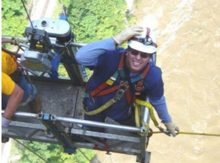
Σχήμα 3.9 Χρήση ιμάντων ασφαλείας κατά την επιθεώρηση
