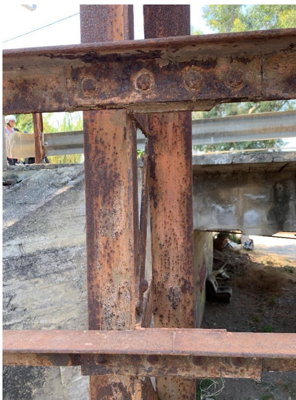
Σχήμα 11.24: Λεπτομέρεια διάβρωσης στους ορθοστάτες
