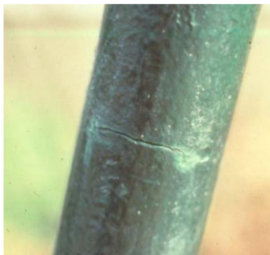
Σχήμα 7.21: Ρωγμή σε προστατευτικό κάλυμμα καλωδίων
