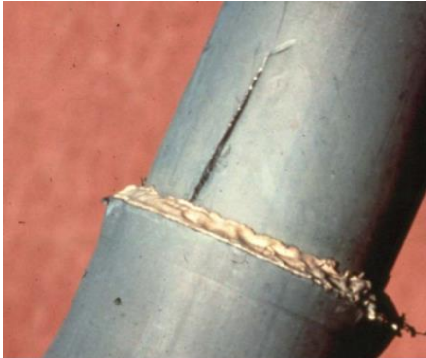
Σχήμα 7.22: Αστοχία – Ρωγμή πολυαιθυλενίου σε προστασία καλωδίων
