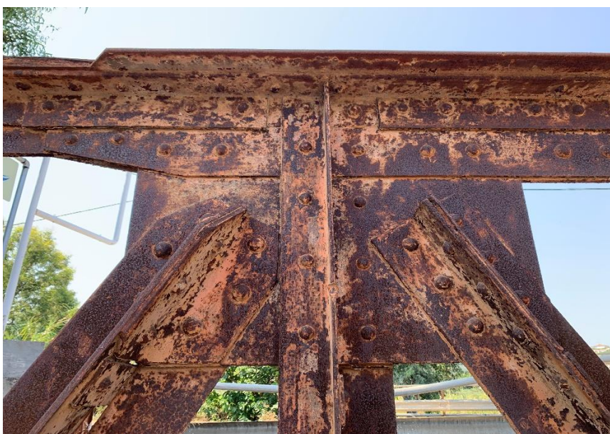
Σχήμα 11.7: Έλασμα σύνδεσης διαγωνίων όψης με άνω κύριες δοκούς
