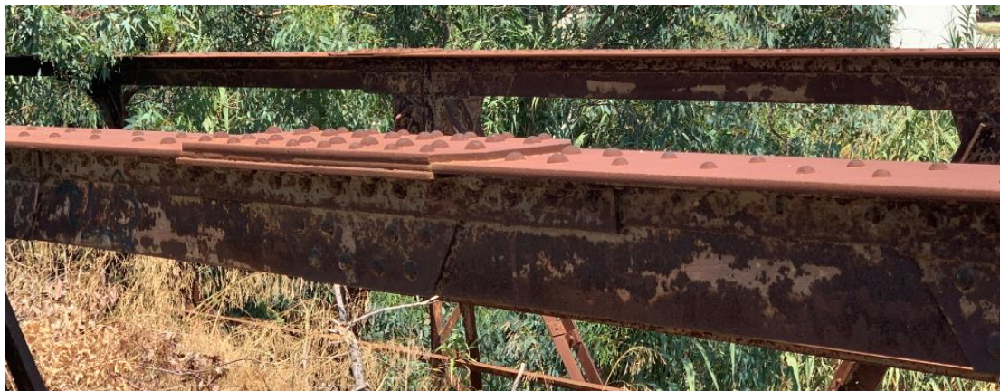
Σχήμα 11.37: Διάβρωση άνω πελμάτων δικτύωσης
