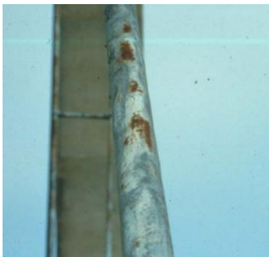
Σχήμα 7.20: Διάβρωση σε προστατευτικό μέταλλο καλωδίων
