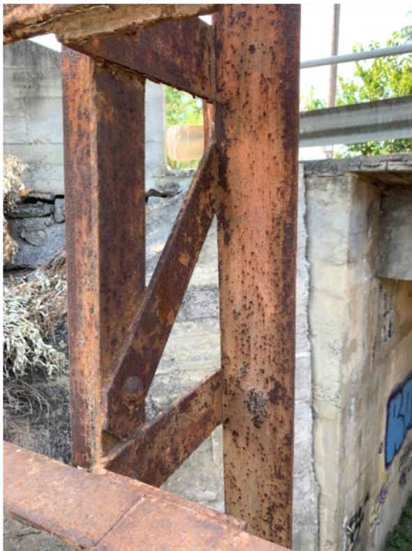
Σχήμα 11.23: Λεπτομέρεια Διάβρωσης στους ορθοστάτες
