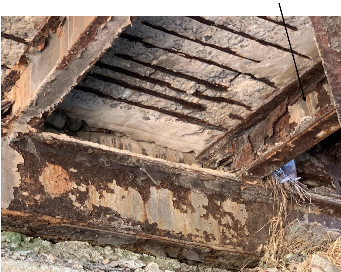
Σχήμα 11.34: Ενδιάμεση διαμήκης δοκός στο άκρο της μεταλλικής γέφυρας
