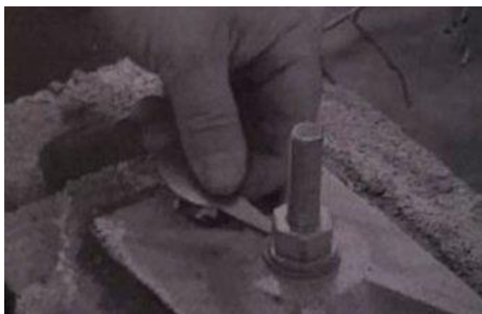
Εικόνα 1.9 Τένοντας προέντασης και πλάκα αγκύρωσης
