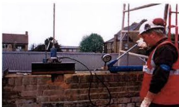
Εικόνα 2.3 Επιβολή προέντασης σε τοιχοποιία με την χρήση αντλίας προέντασης
