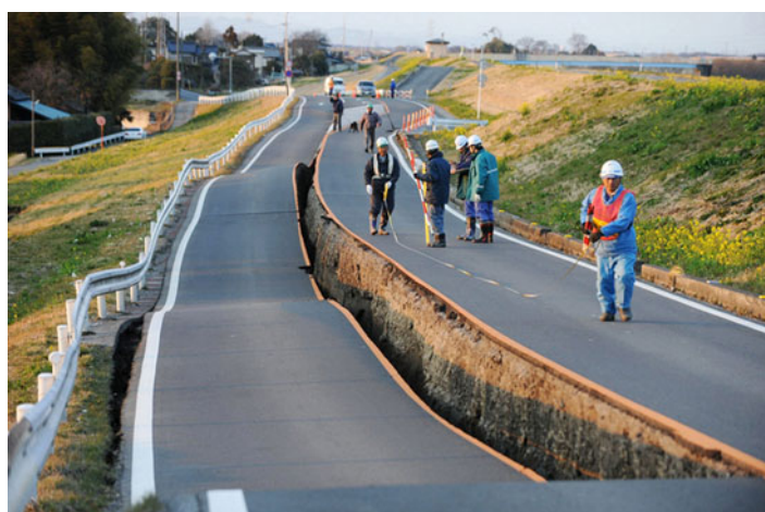
Εικόνα 2.11: Διαφορική καθίζηση εδάφους στο οδικό δίκτυο, http://www.kasmeri.gr/tag/etiketes/fotografia-seismos-iaponia
