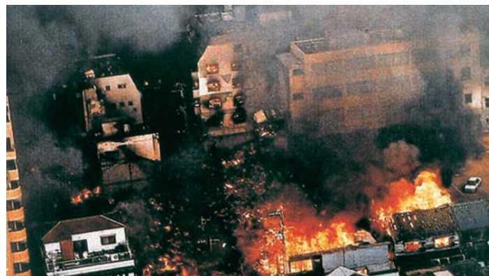
Εικόνα 2.7: Πυρκαγιά από διαρροές στις σωληνώσεις φυσικού αερίου και καταστροφές στο δίκτυο ηλεκτρικής ενέργειας (πόλη Kobe), http://www.diktyoseismos.gr/about-earthquakes/earthquakes-consequences.php
