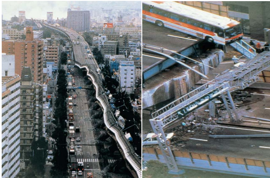
Εικόνα 2.8: Καταστροφές στον αυτοκινητόδρομο Hanshin, http://www.ce.washington.edu/~liquefaction/html/quakes/kobe/kobe.html
