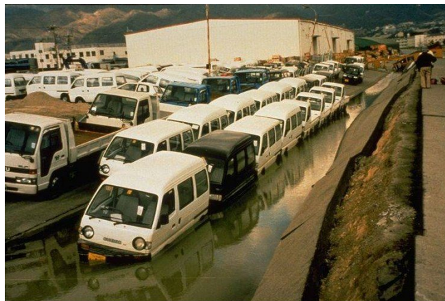
Εικόνα 2.9: Καταστροφές στο οδικό δίκτυο της πόλης Kobe λόγω ρευστοποίησης, http://www.ce.washington.edu/~liquefaction/html/quakes/kobe/kobe.html
