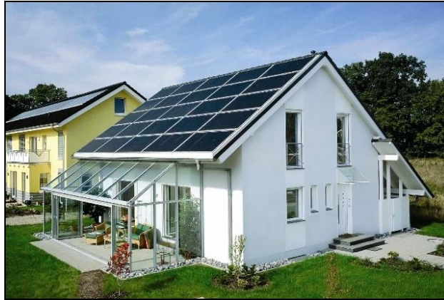
Τοποθέτηση στην εξωτερική επίστρωση του κτιρίου
