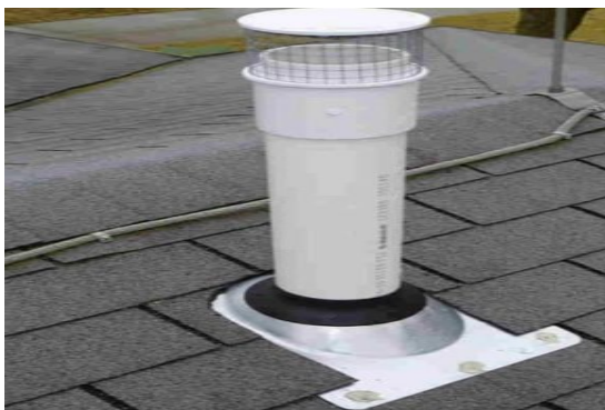
Εικόνα 3.3: Εξαερισμός δικτύου αποχέτευσης (Πηγή:el.decorexpro.com)
