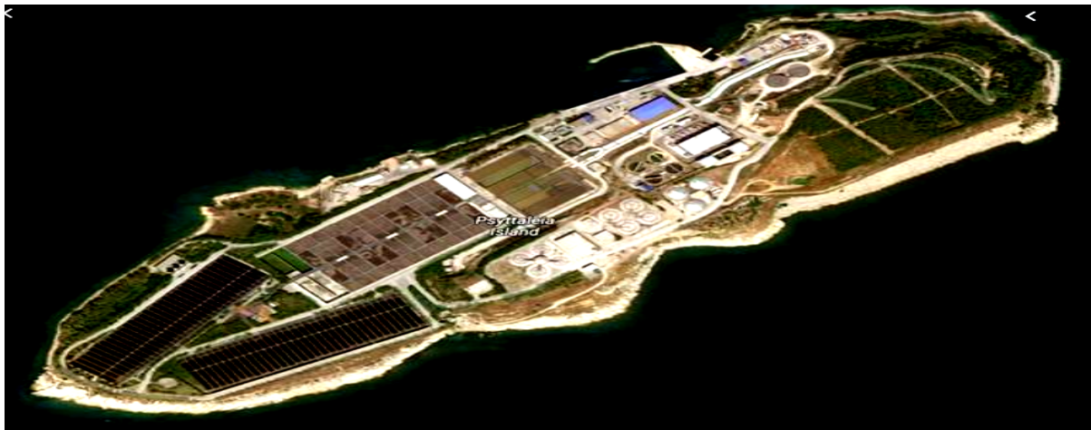
Εικόνα 3.4: Το κέντρο επεξεργασίας λυμάτων στην Ψυττάλεια (Πηγή: b2green.gr/el/posts/18/0/diacheirisi-ydaton-lymaton )
