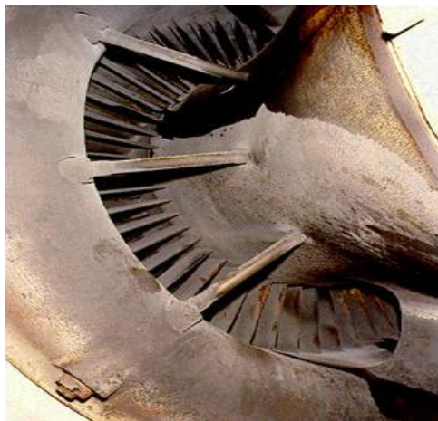
Σχήμα 6.1 Επικαθήσεις σε βιομηχανικό στρόβιλο
