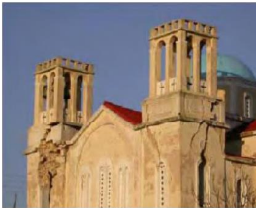
Εικόνα 8: Καταστροφές σε κτήρια και υποδομές των Κυθήρων έπειτα από τον σεισμό στις 8/1/2006. α) Κατολίσθηση στο χωριό Μητάτα (Χρήστος Καρακώστας κ.ά., 2006) β) Κατάρρευση κτηρίου στα Μητάτα (Χρήστος Καρακώστας κ.ά., 2006), γ) Βλάβες στον Ιερό ναό Αγίας Τριάδος στα Μητάτα (Ευαγγελία Ζωβοΐλη, 2016) και δ) Πτώσεις βράχων (B2-Εικόνα7) κοντά στα Μητάτα (Χρήστος Καρακώστας κ.ά., 2006)
