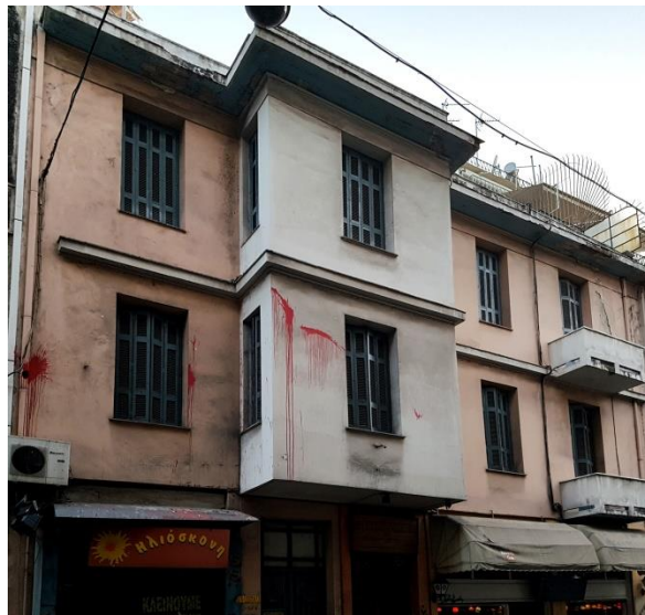
Εικόνα 106: Η όψη της κατοικίας στην Σόλωνος 123, πρώην ιδρύματος για ορφανά κορίτσια. Ζωσμένη με κόκκινη μπογιά, αποτυπώνει την αστική παρακμή, φωτογρ. λήψη: Αύγουστος 2018
