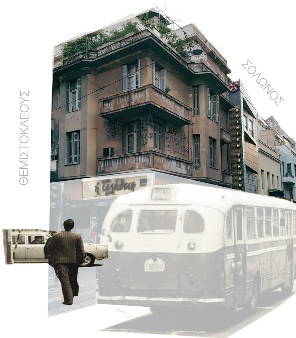
Εικόνα 111: Οδός Σόλωνος στην συμβολή με την Θεμιστοκλέους, διακρίνεται το διατηρητέο κτίριο στο νούμερο 127, τα θολά και ασπρόμαυρα μέρη προέρχονται από φωτογραφία του '70 στο ίδιο ακριβώς σημείο, στο ισόγειο κατάστημα του κτιρίου βρισκόταν το ζαχαροπλαστείο "Η Αλήθεια"
