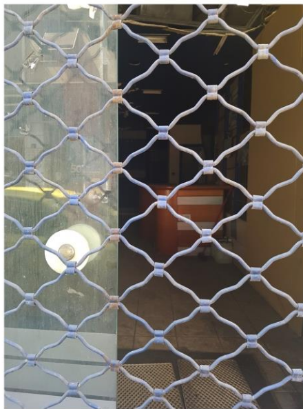
Εικόνα 94: Εγκαταλειμμένο κτίριο στην Σόλωνος 105 ( δίπλα στο κτίριο των «Βατράχων»), το κατάστημα στο ισόγειο, επίσης, εγκαταλειμμένο και εμφανώς φθαρμένο, φωτογρ. λήψη: Σεπτέμβριος 2018
