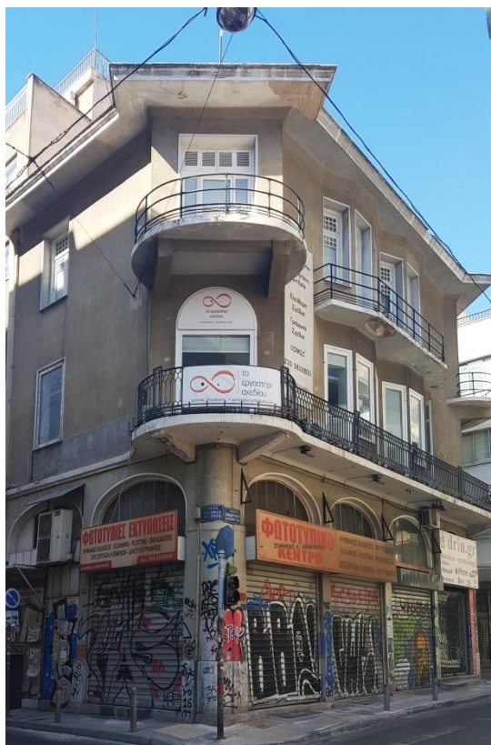
Εικόνα 89: Κτίριο του 1927, το οποίο φέρει ακόμα σημάδια από σφαίρες της περιόδου της Κατοχής, το κτίριο ήταν αρχηγείο του ΕΛΑΣ. Τα τελευταία χρόνια πριν την κρίση σε αυτό το χώρο βρισκόταν τα γραφεία του περιοδικού “Βαβέλ”, Σόλωνος 110
