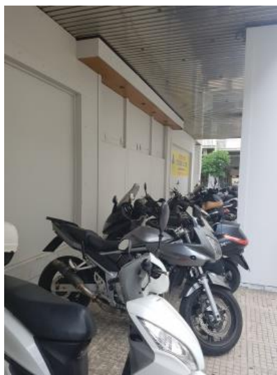
Εικόνα 47: Ο εξωτερικός χώρος του επί χρόνια άδειου καταστήματος στην συμβολή με Πινδάρου έχει μετατραπεί σε άτυπο χώρο στάθμευσης μοτοσυκλετών, φωτογρ. λήψη: Αύγουστος 2018
