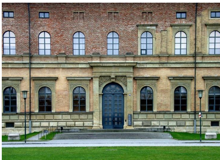
Εικόνα 119: Το κτίριο της Alte Pinakothek (Παλαιά Πινακοθήκη), έργο του αρχιτέκτονα Leo von Klenze του 1836, υπέστη σοβαρές ζημιές κατά την διάρκεια του Β΄ Παγκοσμίου Πολέμου. Η Πινακοθήκη ανοικοδομήθηκε και άνοιξε τις πόρτες της ξανά το 1957. Η αποκατάσταση της από τον αρχιτέκτονα Hans Dollgast, έγινε με προσθήκη τούβλων που συλλέχθηκαν από τις κυρίες των ερειπίων και με αφοσίωση στο αρχικό σχέδιο του Klenze. του Στην όψη είναι εμφανής η χρήση των θραυσμάτων που συμβολίζουν την απώλεια. Ένα είδος εμβολιασμού των τραυματισμένων θραυσμάτων που διασώθηκαν.
