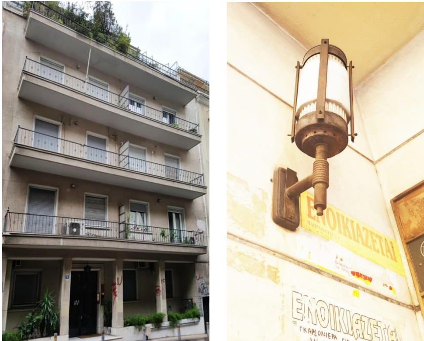
Εικόνα 58: Αριστερά: Σόλωνος 39, στην είσοδο της πολυκατοικίας διαπράχθηκε φόνος το 1994, φωτογρ. λήψη: 2018, Δεξιά: Διαβρωμένο από τον χρόνο, φωτιστικό εισόδου πολυκατοικίας στο νούμερο 41 της Σόλωνος, ίχνος παρελθόντος, φωτογρ. λήψη: 2018
