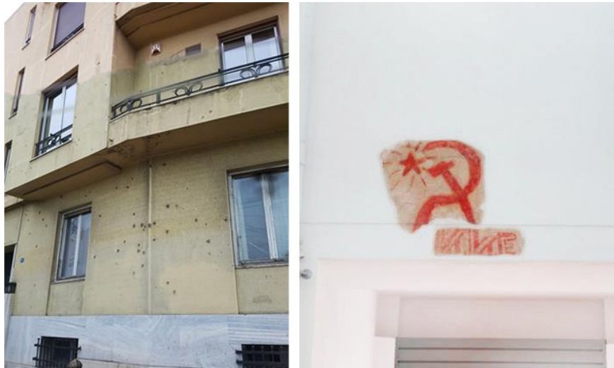
Εικόνα 7: Αριστερά: Σφαίρες από την μάχη του Μακρυγιάννη (Δεκεμβριανά) στην πολυκατοικία στην λεωφ. Βας. Αμαλίας 42. Δεξιά: Στις δύο πλευρικές εισόδους της δημοτικής αγορά Κυψέλης αποκαλύφθηκαν δύο ζωγραφισμένα σφυροδρέπανα του ΚΚΕ κατά τη διάρκεια των εργασιών συντήρησης του κτιρίου και είναι δύο από τα χιλιάδες που φτιάχτηκαν για τον εορτασμό των 26 χρόνων του ΚΚΕ λίγο μετά την απελευθέρωση το 1944 και λίγο πριν από τα Δεκεμβριανά. Το κτίριο ανακαινίστηκε και επαναλειτουργεί (2018), οι τοιχογραφίες «κοσμούν» τις εισόδους και αποτελούν ίχνη που υπενθυμίζουν ιστορίες και συγκρούσεις του παρελθόντος.
