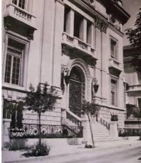
Εικόνα 36: Οικία Μηταράκη, Σέκερη 1 (απέναντι από το κτίριο του Ziller όπου βρίσκεται σήμερα η Ιταλική Πρεσβεία), κατεδαφίστηκε το 1955, στην θέση της στεγάζεται το Μέγαρο Αρβανίτη
