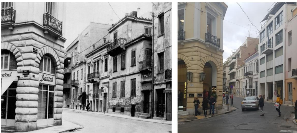
Εικόνα 41: Άποψη οδού Σόλωνος από την οδό Κανάρη, οι φωτογραφίες τοποθετούνται με χρονολογική σειρά η δεξιά φωτογραφία είναι του 1960 και η αριστερή του 2018. Απουσιάζει μόνο το τριώροφο κτίριο ανάμεσα στο κτίριο του Μιχαλέα και στο νεοκλασικό κτίριο όπου στεγάζεται σήμερα η εταιρεία Arivita. Έχει αντικατασταθεί με κτίριο γραφείων δεκαετίας του '90.
