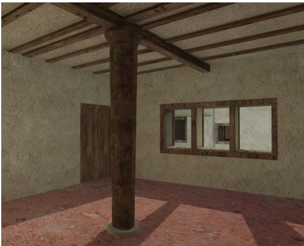
Εικόνα 4.1.10: Τρισδιάστατη απεικόνιση του δωματίου A1, στην οποία φαίνεται ο ξύλινος κίονας με τη λίθινη βάση και το μεγάλο παράθυρο.
