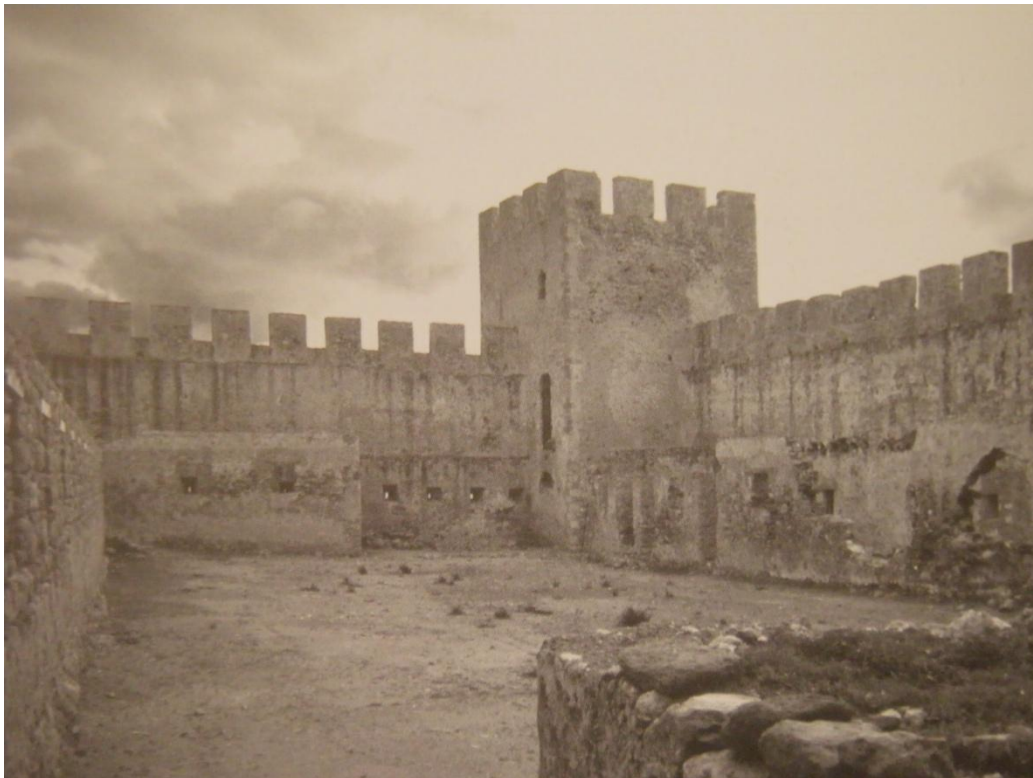
Εικόνα 3: Φραγκοκάστελλο. Το εσωτερικό του φρουρίου σήμερα.
