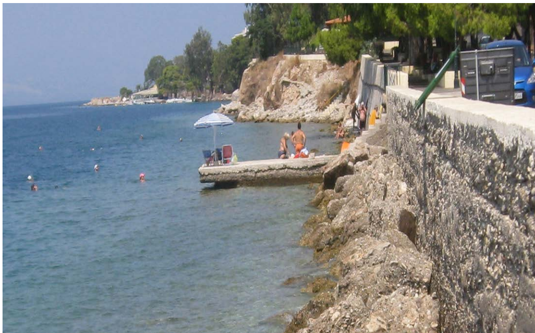
Εικόνα 5-8. Άποψη εξέδρας και χρήση από λουόμενους. Πρόβλημα υποσκαφής στο νότιο άκρο της.
