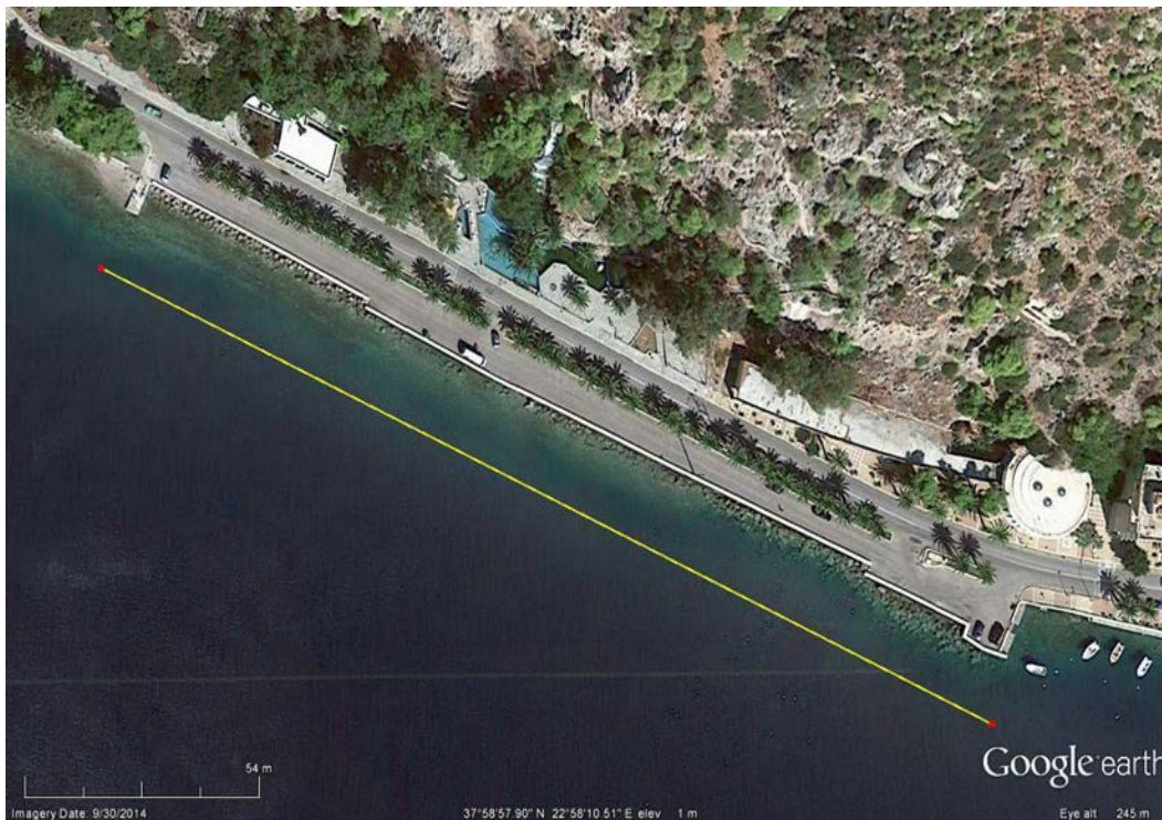
Εικόνα 5-6. Ανεπαρκής προστασία κατακόρυφου μετώπου παραλιακού δρόμου
