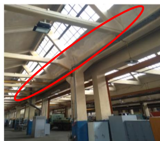
Εικόνα 50: Πλάγια δοκός σύνδεσης των φεγγιτών
