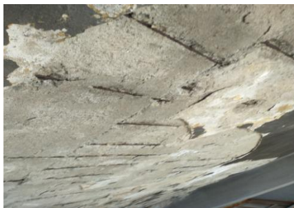
Εικόνα 113: Οπλισμός Κεκλιμένων Πλακών
