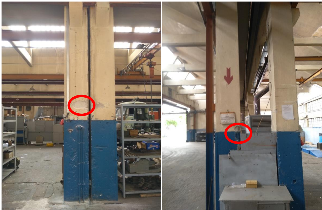
Εικόνα 21. Θέσεις εκτέλεσης κρουσιμετρήσεων
