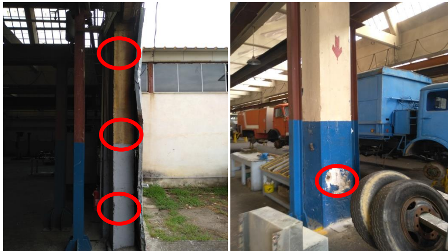
Εικόνα 23. Θέσεις εκτέλεσης κρουσιμετρήσεων
