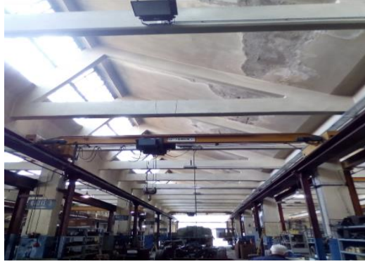
Εικόνα 53: Γερανοπέφυρα εδραζόμενη επί αυτοσχέδιων διατάξεων
