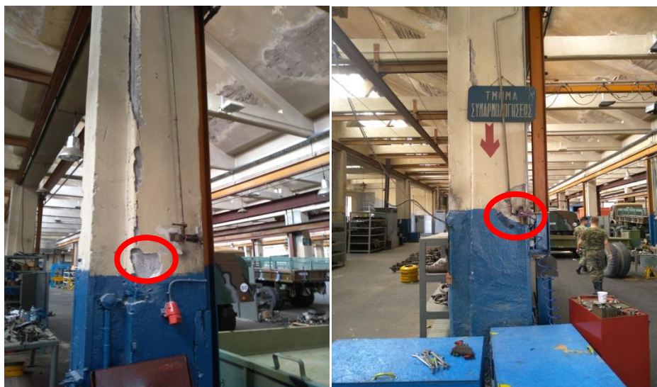
Εικόνα 24. Θέσεις εκτέλεσης κρουσιμετρήσεων
