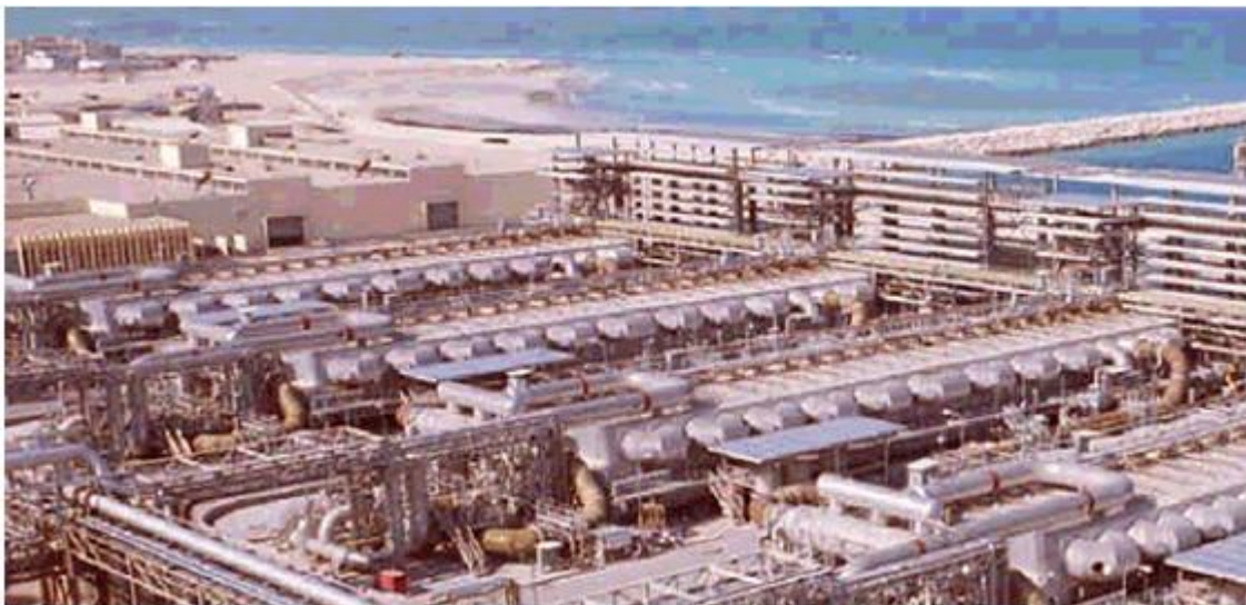
Εικόνα 1.1 Εγκατάσταση με πολυβάθμια εκρηκτική εξάτμιση στη Σαουδική Αραβία δυναμικότητας 138.000 κ.μ την ημέρα [10] (Κάραλης Γ., 2011)
