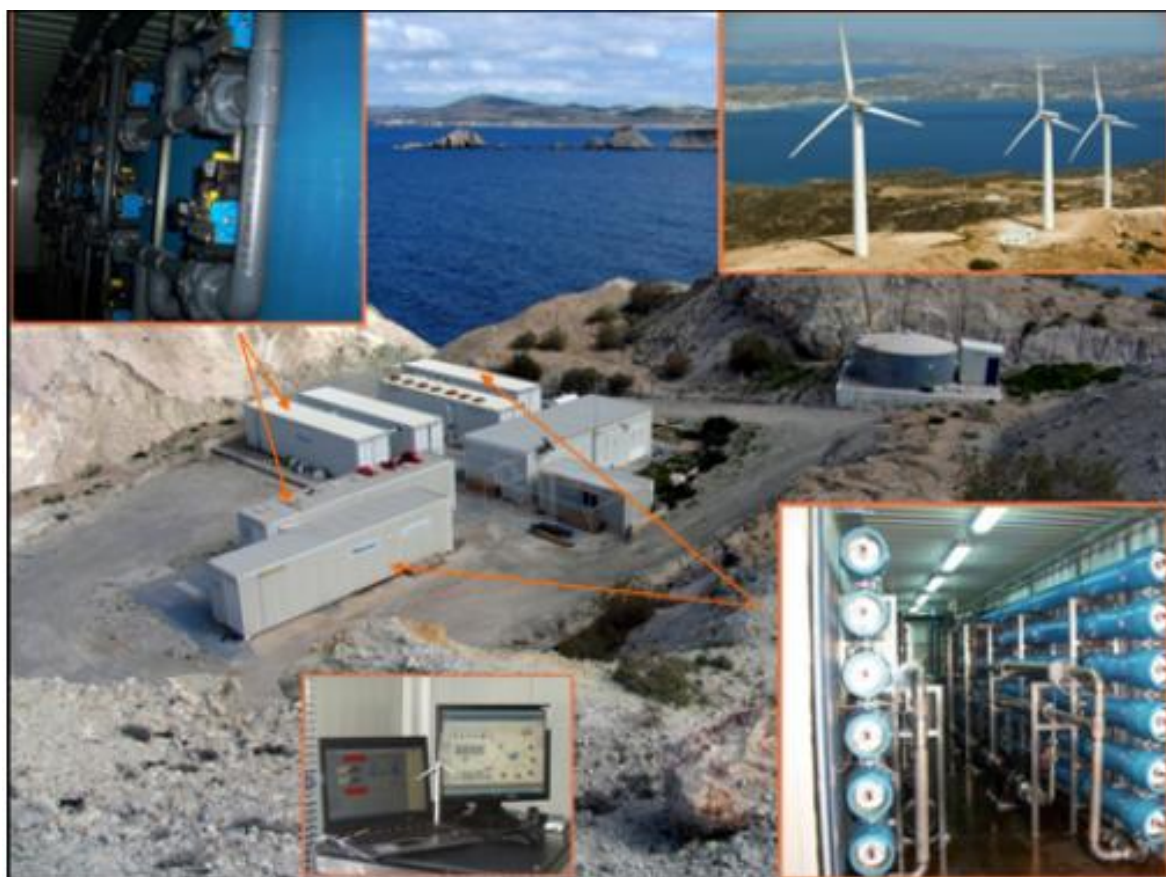
Σχήμα 4.1 Μονάδα αφαλάτωσης Μήλου (με αιολική ενέργεια). (Αφαλάτωση με χρήση αιολικής ενέργειας στη Μήλο. Ολοκληρωμένη λύση για την αντιμετώπιση του προβλήματος λειψυδρίας., 2010)
