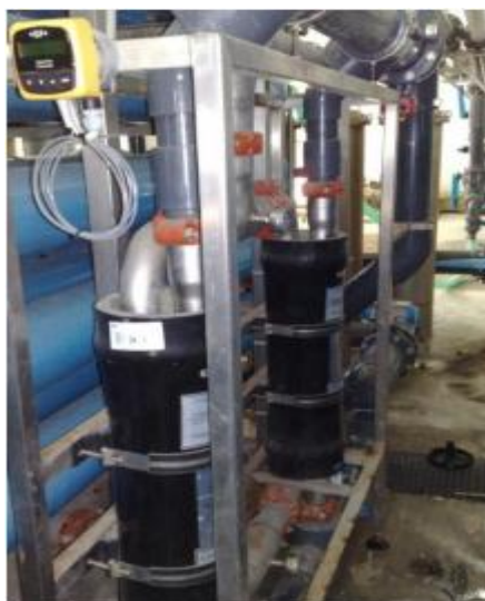
Εικόνα 1.7 Σύστημα ανάκτησης ενέργειας απορριπτόμενης άλμης.
