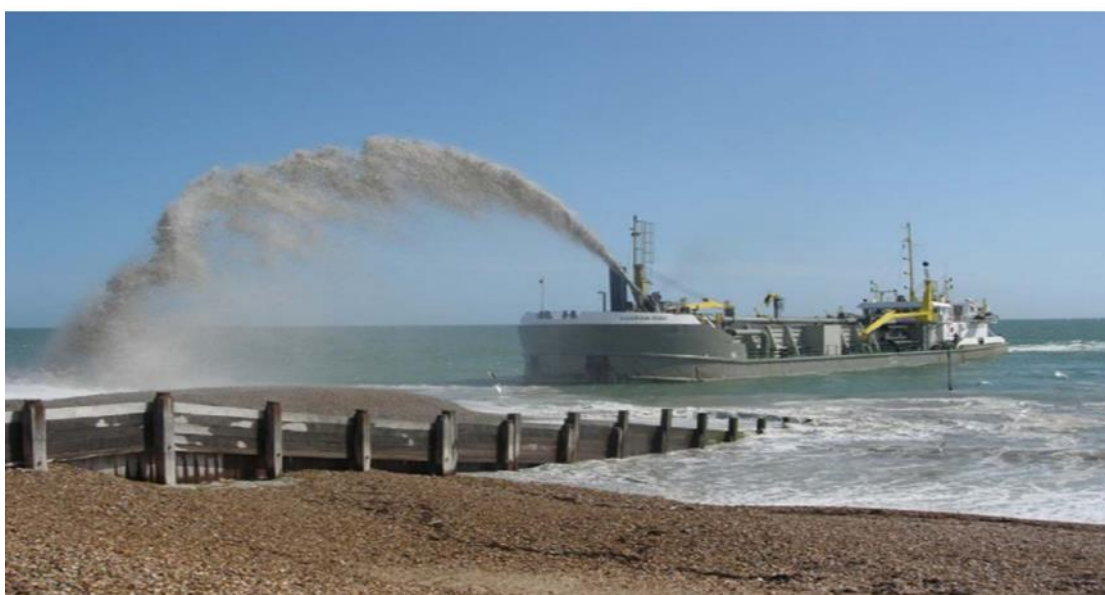
Εικόνα 11. Βυθοκόρος σε διαδικασία απόρριψης ιζήματος για αναπλήρωση ακτής ( www.escp.org.uk )
