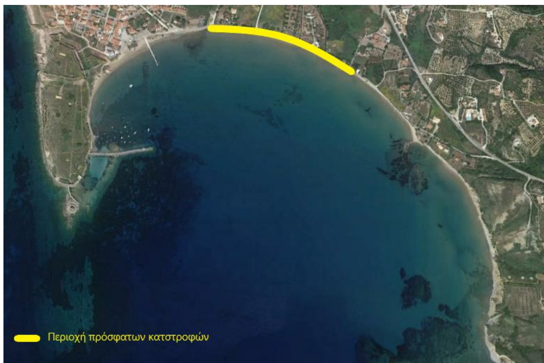
Σχήμα 11. Περιοχή πρόσφατων καταστροφών στην παράκτια ζώνη της Μεθώνης
