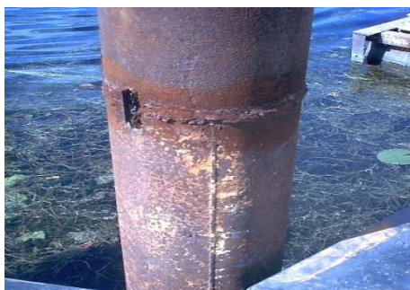
Εικόνα 7 - Ομοιόμορφη Διάβρωση
