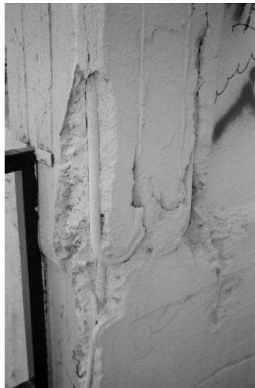
Εικόνα 7.14: αριστερά: εκτεθειμένη ράβδος οπλισμού χωρίς συνδετήρες και δεξιά: εκτεθειμένος γάντζος αγκύρωσης χωρίς συνδετήρες σε υποστύλωμα.
