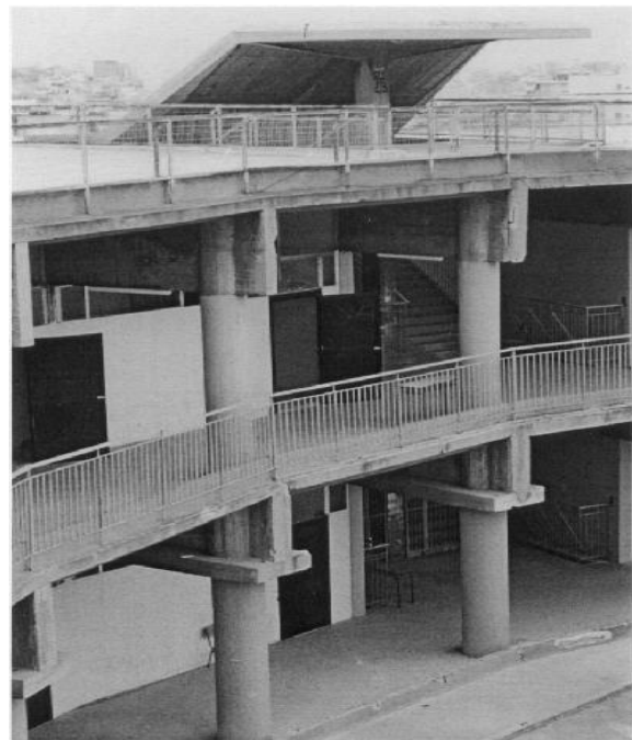
Εικόνα 7.20: αριστερά: ανεπαρκής κατασκευή κενου και δεξιά: σύστημα ισχυρής δοκού με ασθενή υποστυλώματα
