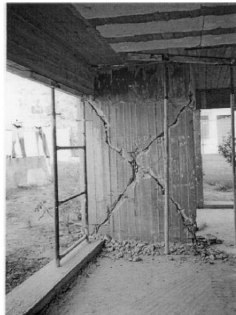
Εικόνα 7.15: αριστερά: αστοχία σε τοίχο μαλακού ορόφου και δεξιά: διατμητική ρωγμή τύπου \chi σε τοίχο οπλισμένου σκυροδέματος.
