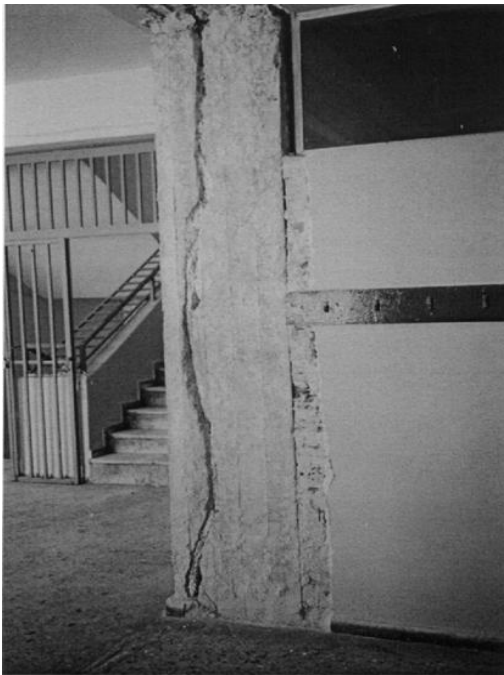
Εικόνα 7.20: αριστερά: ανεπαρκής κατασκευή κενου και δεξιά: σύστημα ισχυρής δοκού με ασθενή υποστυλώματα
