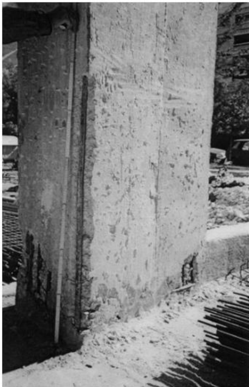
Εικόνα 7.14: αριστερά: εκτεθειμένη ράβδος οπλισμού χωρίς συνδετήρες και δεξιά: εκτεθειμένος γάντζος αγκύρωσης χωρίς συνδετήρες σε υποστύλωμα.
