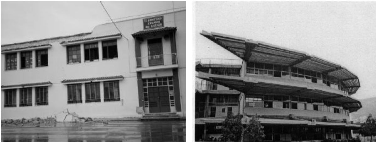
Εικόνα 7.21: αριστερά: κατάρρευση παραπέτου στέγης και δεξιά: σύστημα μακρίας αρθρωτής δοκού
