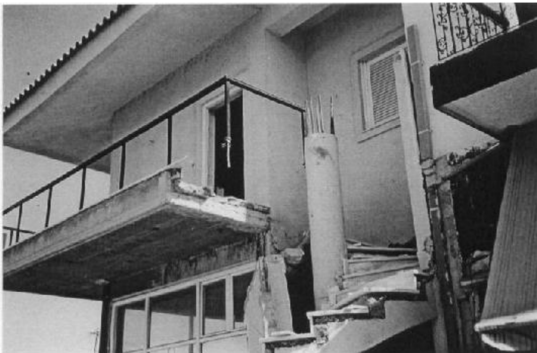
Εικόνα 7.17: Μερική κατάρρευση σε κλίμακα
