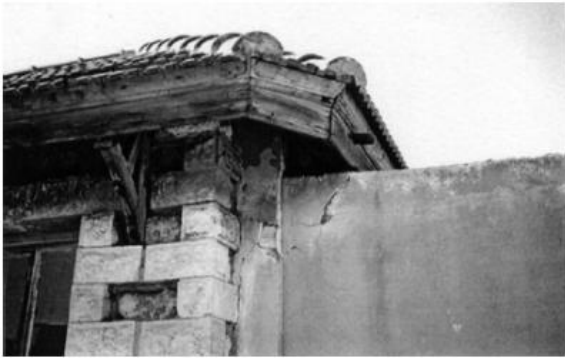
Εικόνα 7.19: αριστερά: κρούση γειτονικής κατασκευής και δεξιά: αστοχία δοκού λόγω κρούσης
