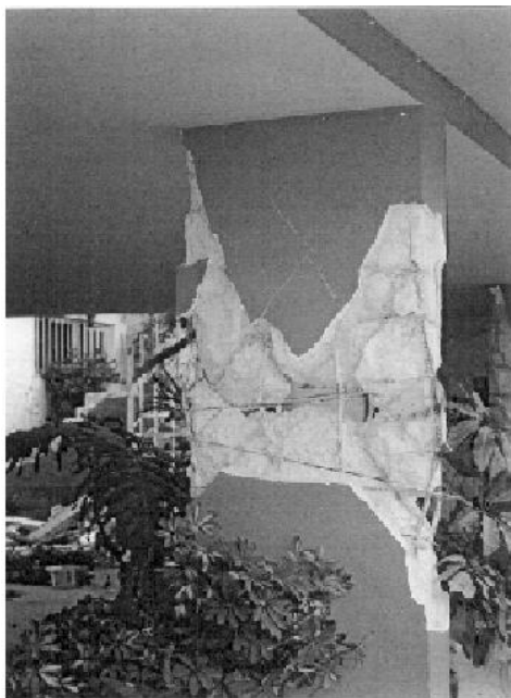
Εικόνα 7.15: αριστερά: αστοχία σε τοίχο μαλακού ορόφου και δεξιά: διατμητική ρωγμή τύπου \chi σε τοίχο οπλισμένου σκυροδέματος.
