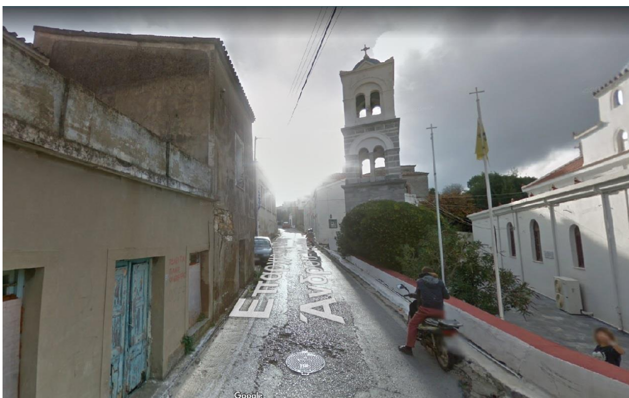
Οι δύο κατευθύνσεις του οικισμού με τα κτίσματα σε συνεχές σύστημα και σε ασφυκτική επαφή με το δρόμο.
