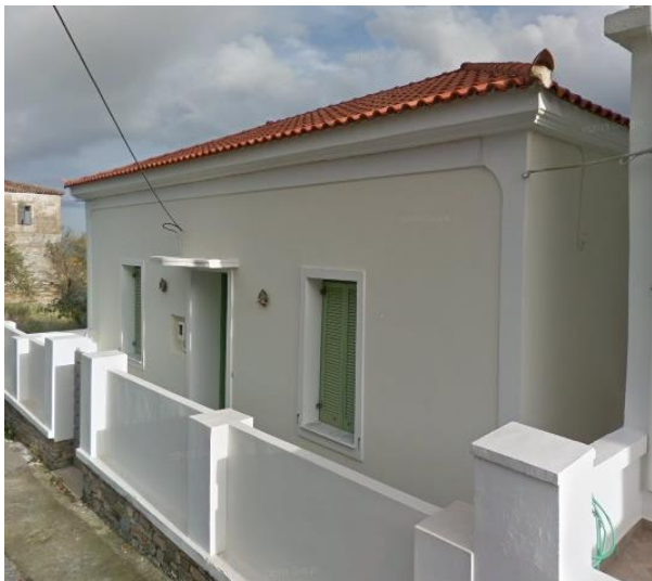
Κατοικία με νεοκλασικές επιρροές.
