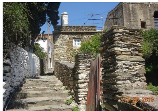
Φέρουσα τοιχοποιία από σχιστόλιθους
