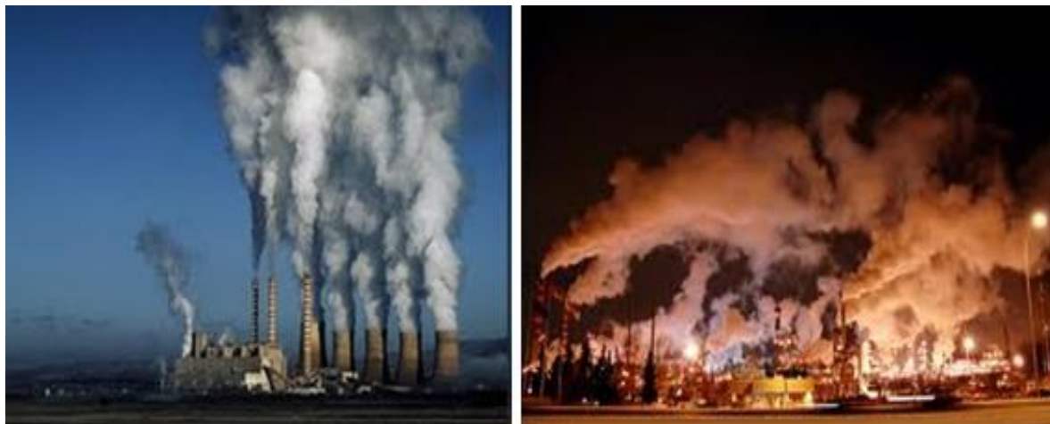
Σχήμα 1.2 Αριστερά: Ατμοηλεκτρικό εργοστάσιο στη Πτολεμαΐδα. Δεξιά: Δωλιστήρια στον Ασπρόπυργο
