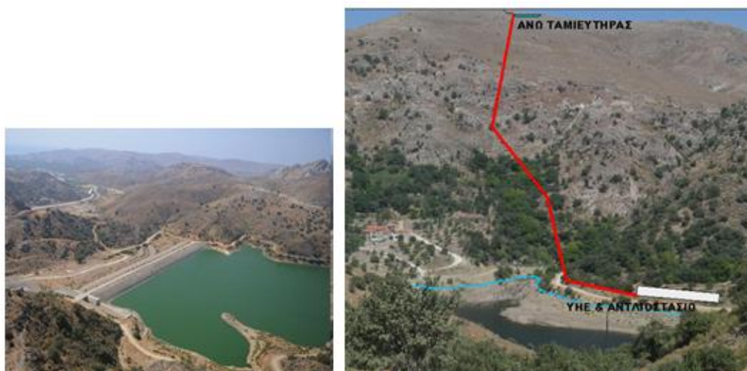
Σχήμα 3.15 Φράγμα Ερεσού-σχηματική απεικόνιση υβριδικού σταθμού
