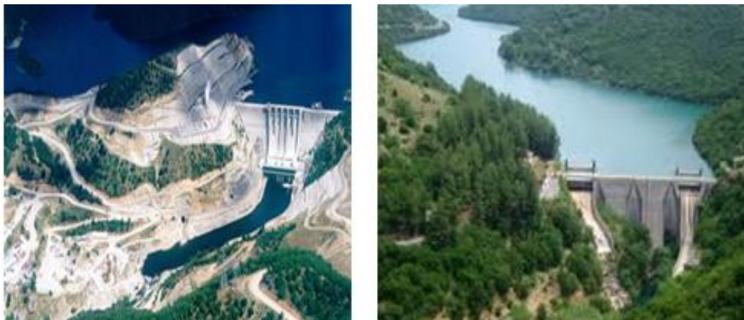
Σχήμα 2.40 Αριστερά: Υδροηλεκτρικό φράγμα Πλατανόβρυσης στο Νέστο ισχύος 116MW και υδραυλικής πτώσης 95m. Για τη κατασκευή του χρησιμοποιήθηκε ιπταμένη τέφρα από το θερμοηλεκτρικό σταθμό Πτολεμαΐδας. Δεξιά: Υδροηλεκτρικό φράγμα Λάδωνα ισχύος 70MW.
