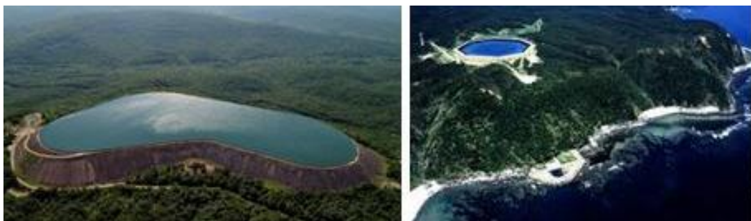
Σχήμα 2.41 Αριστερά: Μονάδα αντλησιοταμίευσης ισχύος 500MW και υδραυλικής πτώσης 240m, στην περιοχή Taum Sauk των ΗΠΑ. Δεξιά: Σταθμός αντλησιοταμίευσης με θαλασσινό νερό στη περιοχή Okinawa της Ισπανίας. Η πάνω δεξαμενή βρίσκεται σε ύψος 150m από την επιφάνεια της θάλασσας και η συνολική ισχύς του σταθμού είναι 30MW.
