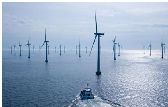
Σχήμα2.9 Υπεράκτιο αιολικό πάρκο στη θαλάσσια περιοχή του Thanet της νότιας Αγγλίας
