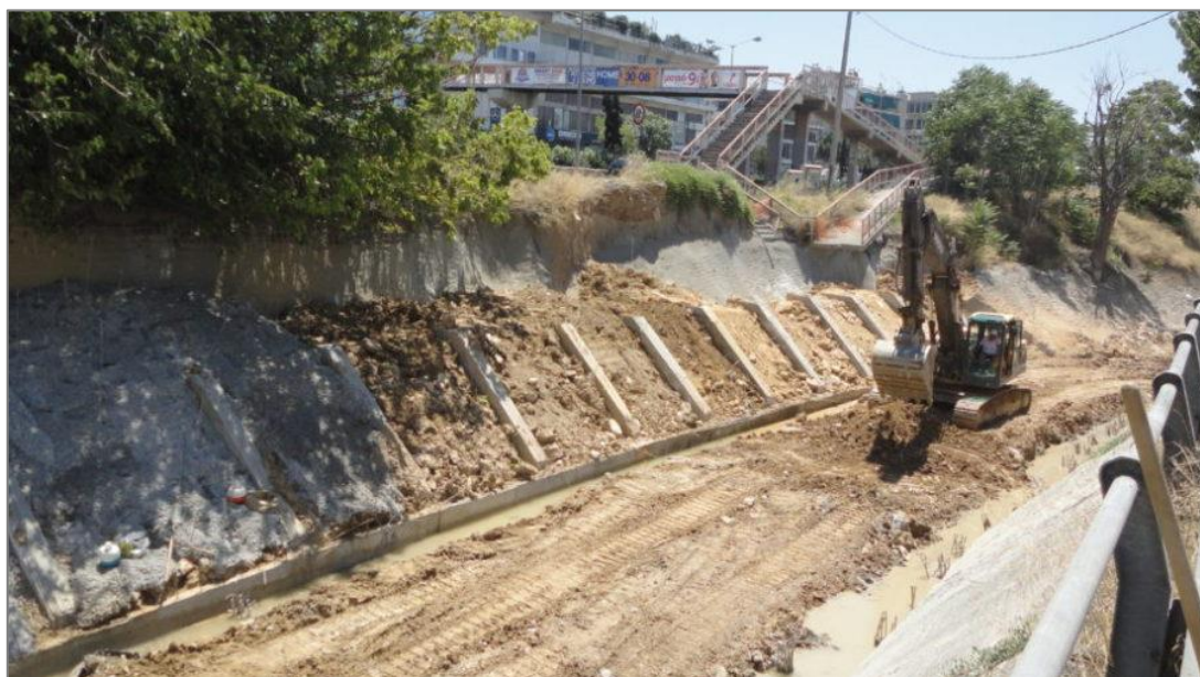
Εικόνα 3-4: Έργα στην κοίτη του Κηφισού, στο ύψος της οδού Λάμπρου Κατσώνη
