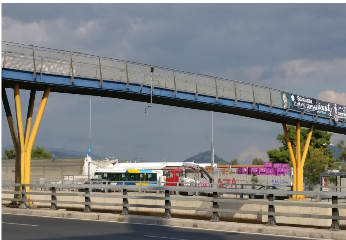
Εικόνα 3-19: Θέση τοποθέτησης τηλεμετρικού σταθμού Αγ.Ιωάννης Ρέντης
