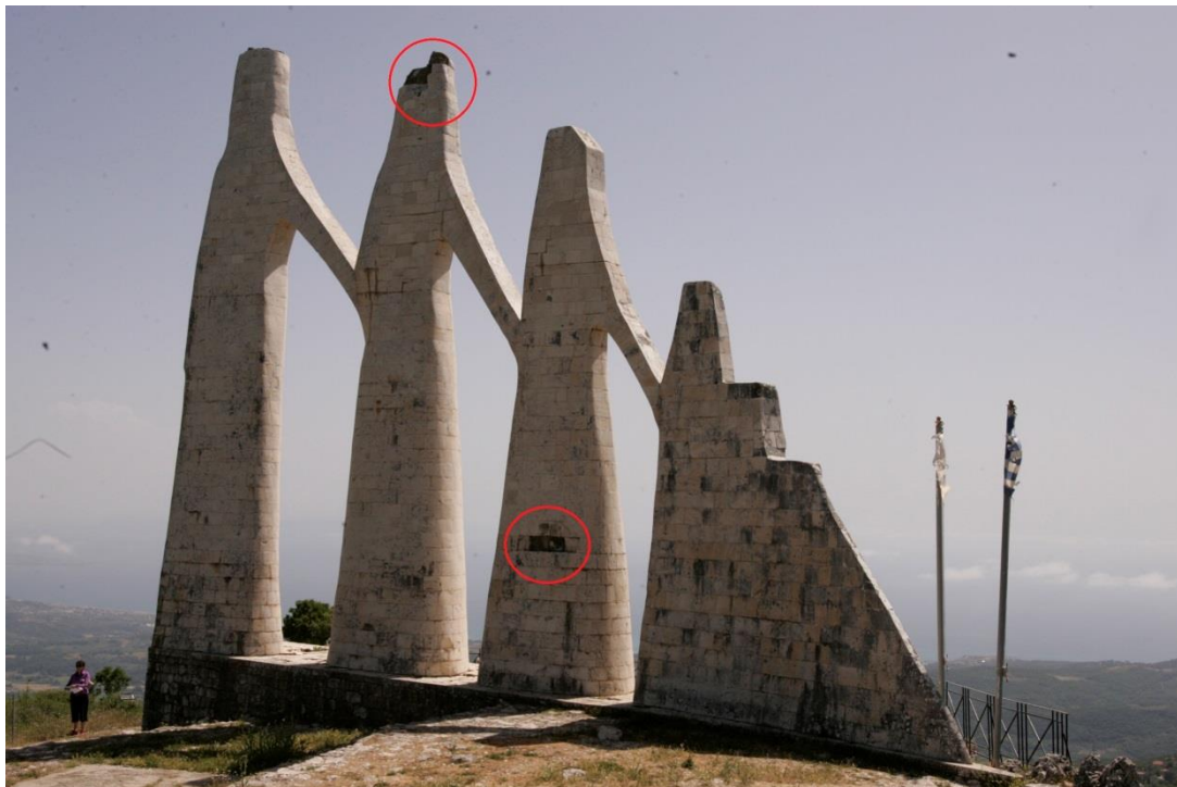
Εικόνα 2 - 8: Βλάβες στην ανατολική όψη του μνημείου Ζαλόγγου
