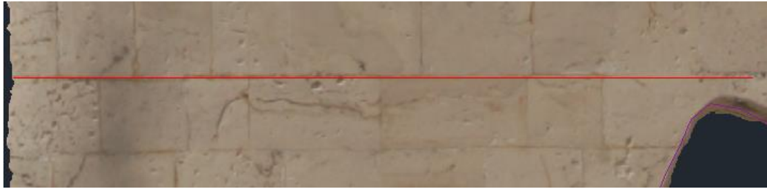
Εικόνα 5 - 41: Νέα ορθοφωτογραφία - έλεγχος αρμών
