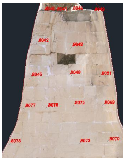
Εικόνα 4 - 103: Φωτοσταθερά στο παλιό ορθοφωτομωσαϊκό στο επίπεδο B'-B
