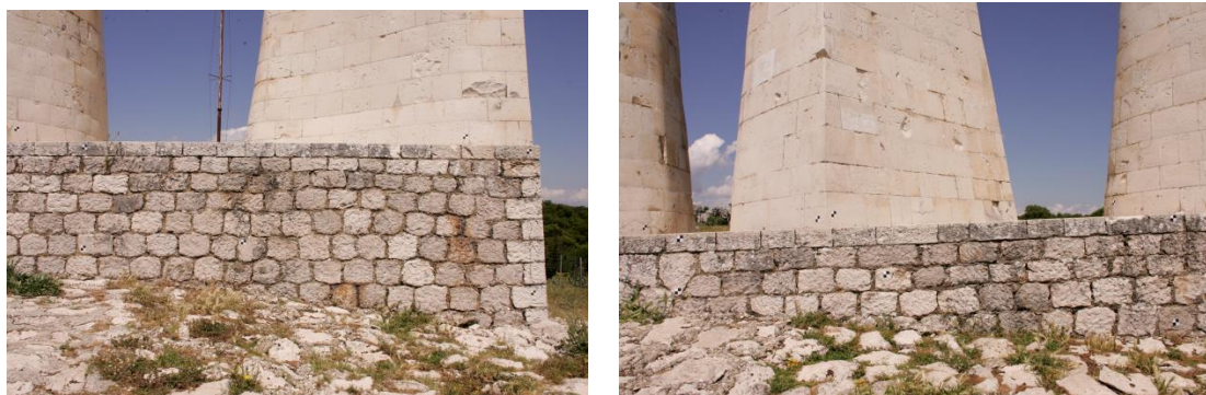
Εικόνα 3 - 17: Λήψεις εικόνων βάθρου δυτικής όψης για φωτογραμμετρική αναγωγή
