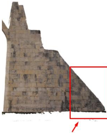
Εικόνα 5 - 32: Μεγάλες αποχές στην τέταρτη μορφή της ανατολικής όψης
