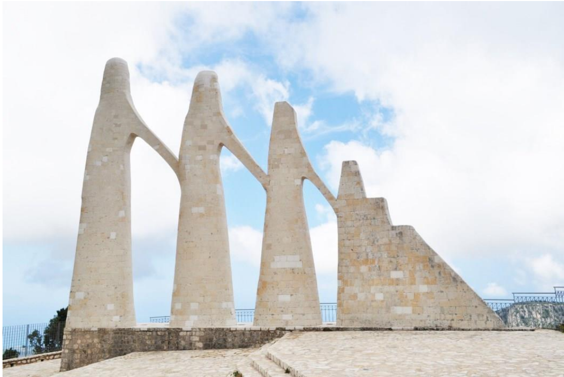
Εικόνα 2 - 10: Αποκατάσταση_ανατολική όψη μνημείου
