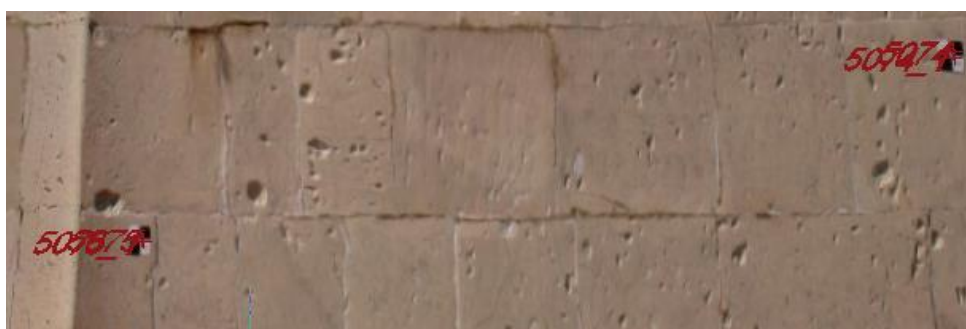
Εικόνα 4 - 104: Φωτοσταθερά στο νέο ορθοφωτομωσαϊκό στο επιπέδο Β'-Β
