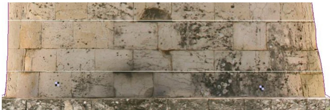
Εικόνα 5 - 40: Παλιά ορθοφωτογραφία – έλεγχος αρμών
