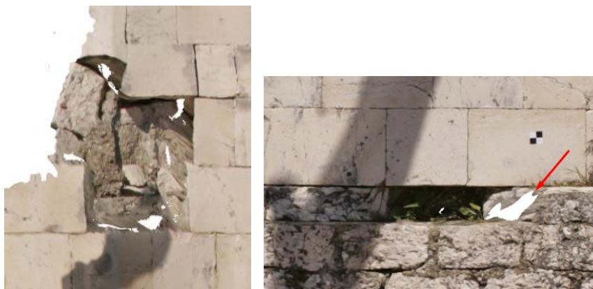
Εικόνα 4 - 98: Προβλήματα πιστότητας στην ορθοφωτογραφία του επιπέδου B''-B'
