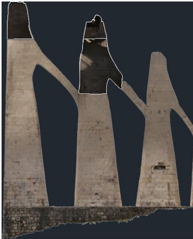
Εικόνα 4 - 107: Ορθοφωτομωσαϊκό A-A' πριν την ραδιομετρική επεξεργασία
