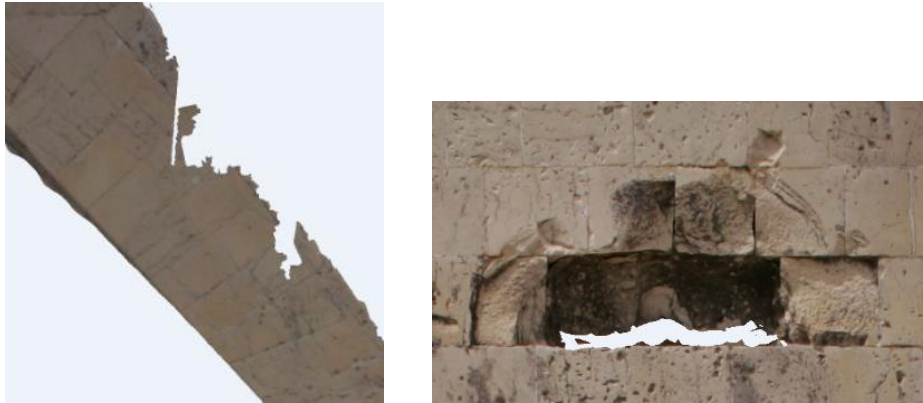
Εικόνα 4 - 87: Προβλήματα στο ορθοφωτομωσαϊκό του επιπέδου A-A'
