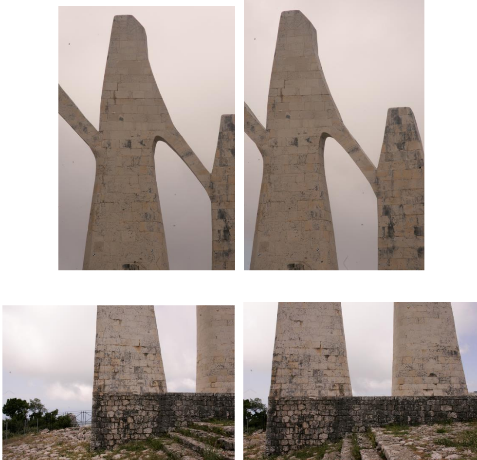
Εικόνα 3 - 18: Λήψεις εικόνων ανατολικής όψης για στερεοσκοπική φωτογραμμετρία
