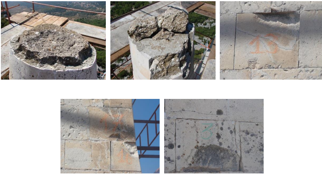
Εικόνα 2 - 6: Φθορές μνημείου Ζαλόγγου
