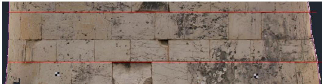
Εικόνα 5 - 39: Νέα ορθοφωτογραφία – έλεγχος αρμών
