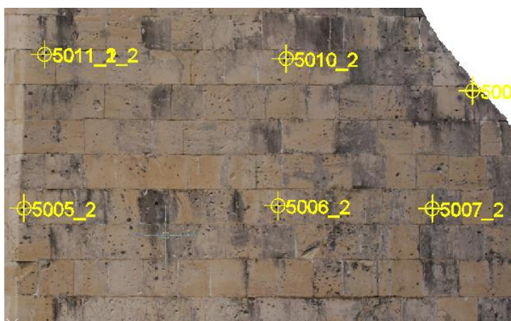
Εικόνα 4 - 93: Φωτοσταθερά στο νέο ορθοφωτομωσαϊκό στο επιπέδο Α'-Α''
