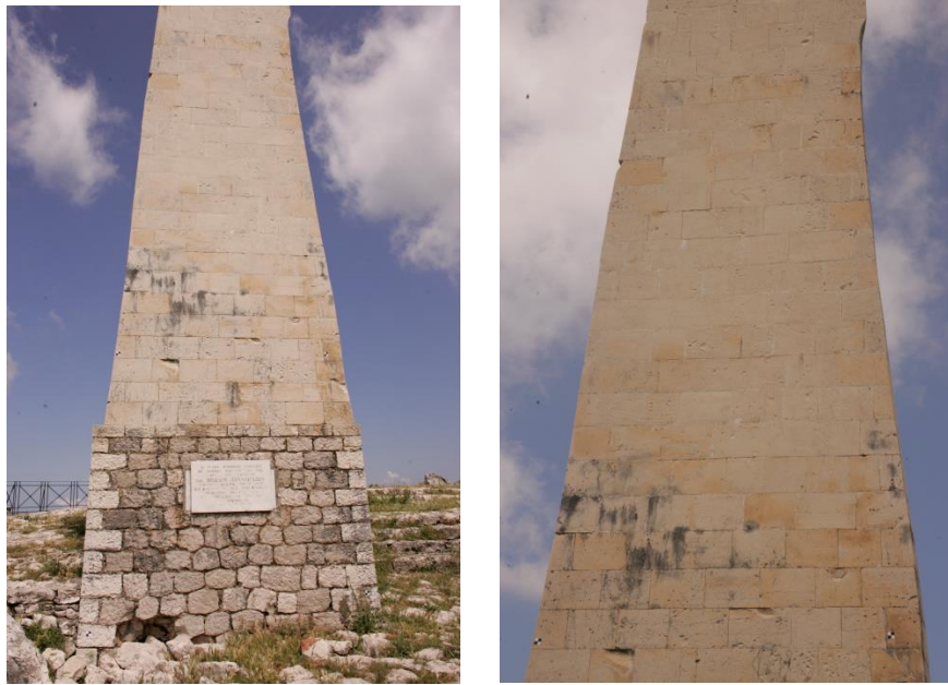
Εικόνα 3 - 16: Λήψεις εικόνων νότιας όψης για φωτογραμμετρική αναγωγή
