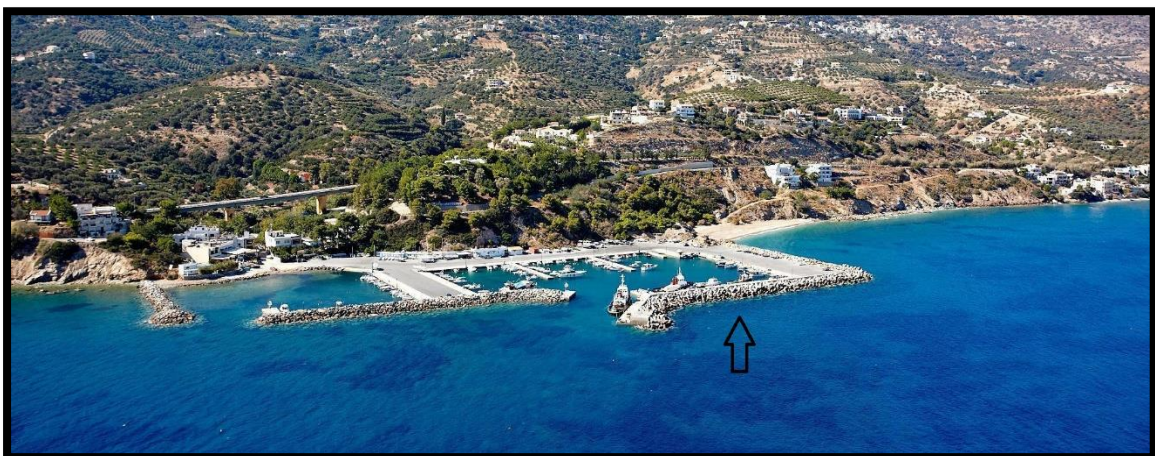
Εικόνα 6.10: Μαρίνα Ροδιάς - Λινοπεράματα , Ένδειξη σημείου εγκατάστασης μηχανισμού
