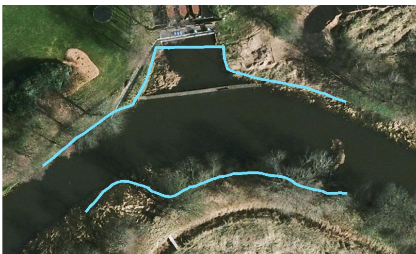
Εικόνα 3.3-5: Οι όχθες του ποταμού της περιοχής μελέτης σε σύστημα συντεταγμένων UTM και στη ζώνη 32N, [ ArcMap ].
