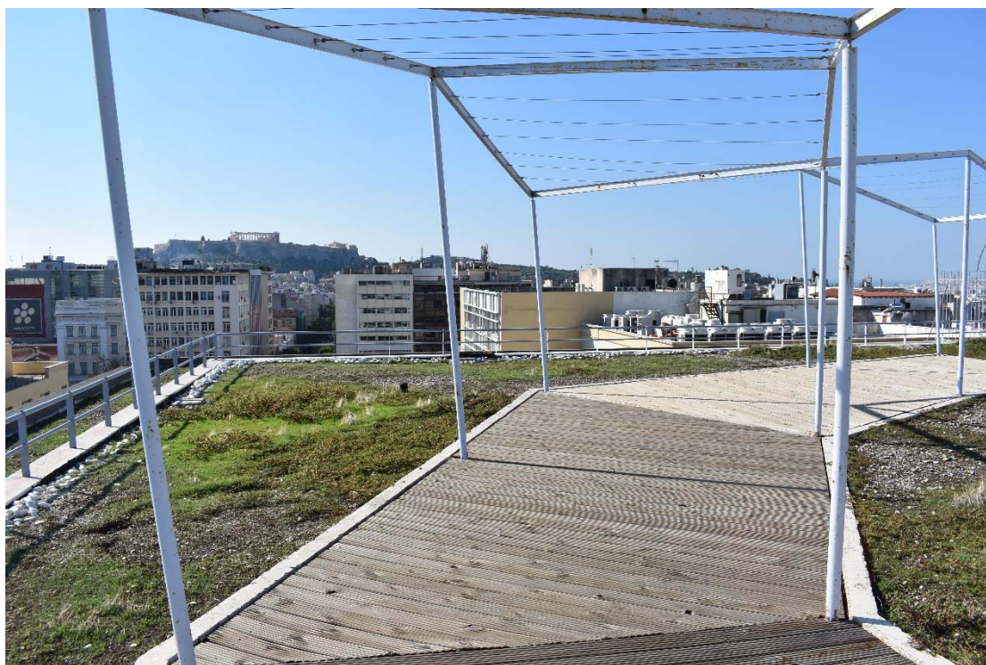
Εικόνα 6 Φυτευτό δώμα οροφής τελευταίου ορόφου
