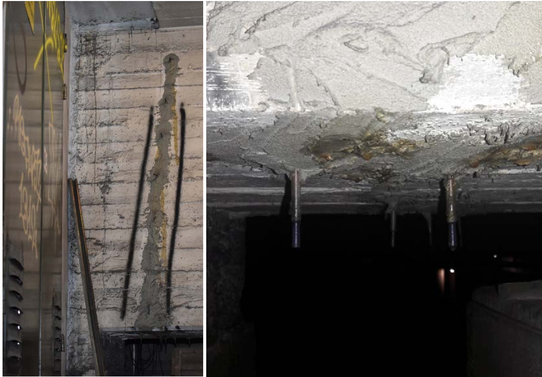
Εικόνα 2 Αποκατάσταση δοκών με χρήση ρυτινών
