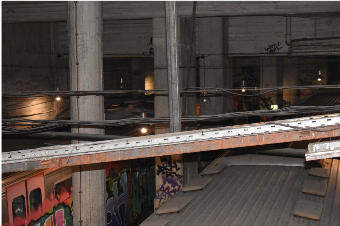
Εικόνα 4 Άποψη οροφής υπογείου
