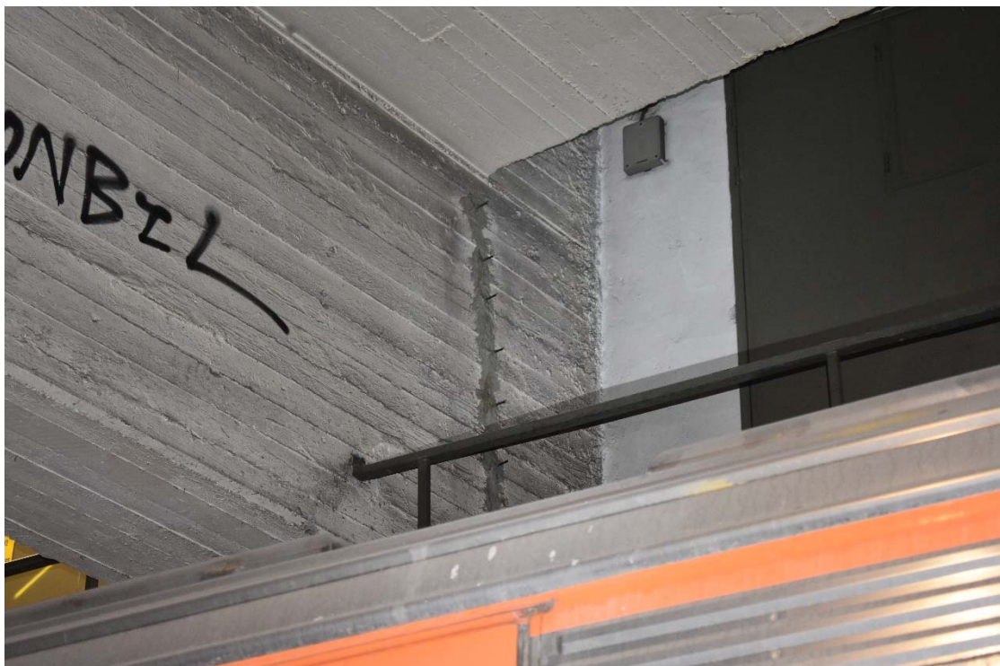
Εικόνα 3 Ενισχυμένη δοκός οροφής υπογείου
