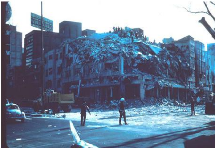
Εικόνα 5-Μεξικό 1985-κατάρρευση του ανώτερου τμήματος 8-όροφου κτιρίου λόγω του φαινομένου
