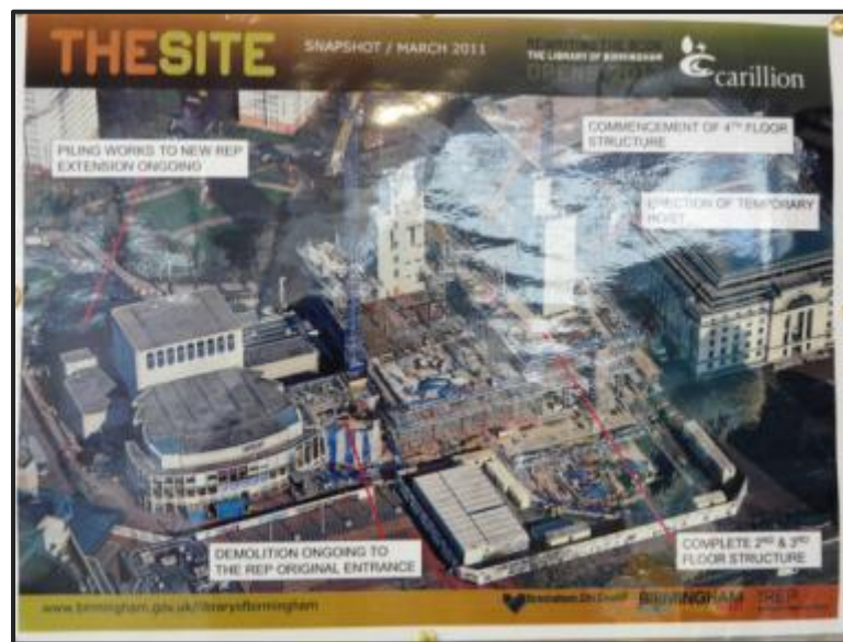
Εικόνα 70. Εικόνα από το εργοτάξιο της νέας βιβλιοθήκης του Birmingham τον Μάρτιο του 2011, αρχείο Σ. Τσάδαρη
