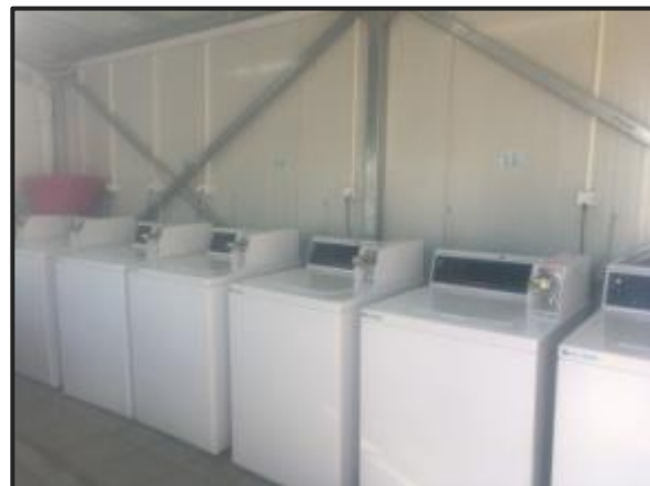
Εικόνα 40 Χώρος κοινόχρηστων πλυντηρίων, αρχείο Σ. Τσάδαρη
