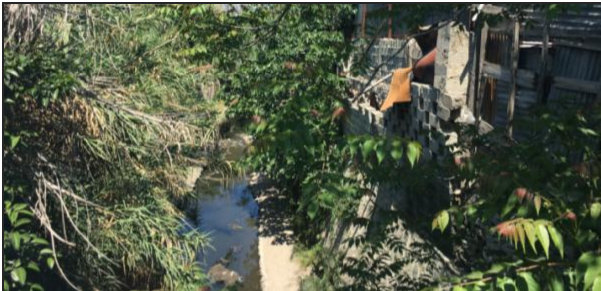
Εικόνα 110 Άποψη του ρέματος του Προφήτη Δανιήλ από την οδό Ορφέος, άνοιξη 2017, αρχείο Σ. Τσάδαρη
