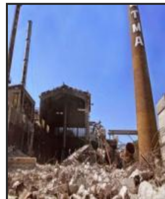
Εικόνα 20 Εικόνα από την κατεδάφιση της ΕΤΜΑ (Πηγή Hot Doc)
