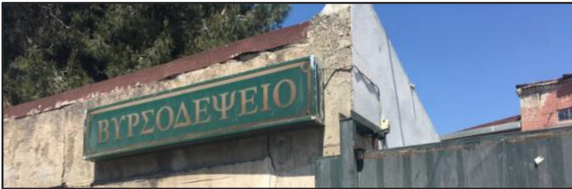
Εικόνα 88. Το παλιό βυρσοδεψείο στην οδό Ορφέως 174, διατηρητέο κτίριο του Υπουργείου Πολιτισμού, μέλος του διεθνούς δικτύου TEH (Trans Europe Halles) και του IETM. Λειτουργεί ως καλλιτεχνικός χώρος. ( http://www.vyrsodepseio.com/el )
