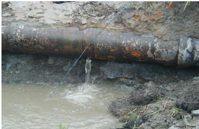
Εικόνα 6: Εκσκαφή για επιδιόρθωση σε αγωγό με διαρροή στην Θεσσαλονίκη (Ζαφειράκου, 2013)
